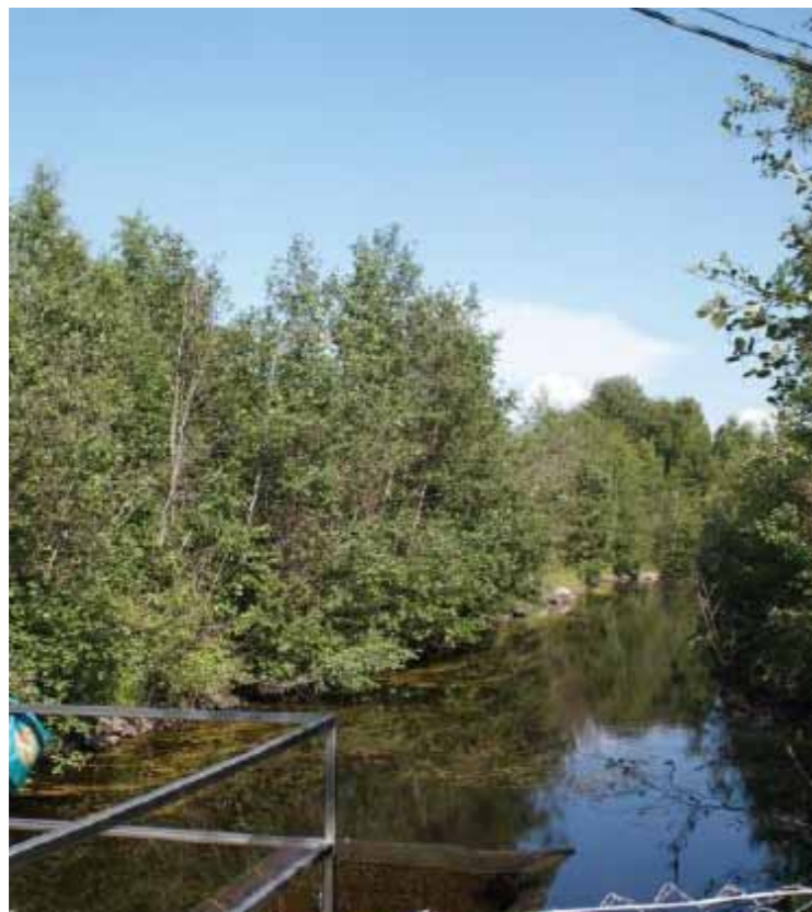
Kuva 5. Lauhdevesikanavan umpeenkasvanut reunakasvusto (Kuva: VSU Oy)
