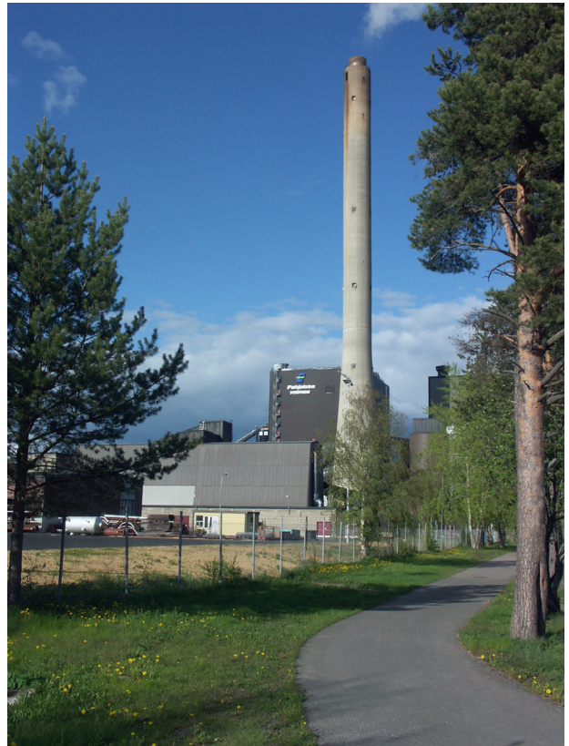
Oulun Energian Toppilan voimalaitokset. Kuva: Eino Niskala
