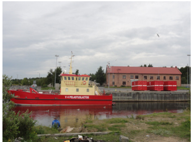
Toppilan sahan entinen voimalarakennus on Oulu-Koillismaan Pelastuslaitoksen käytössä.
