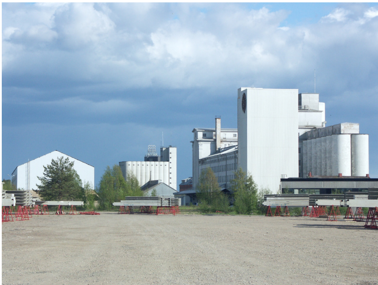
Tervahovintien länsipäässä, Toppilansalmen rannassa on teollisuuden käyttöön tehtyjä rakennuksia. Kuva: Eino Niskala
