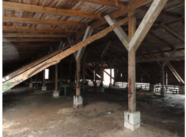
Venevajassa on maapohja ja puiset rakenteet. Kuva: Kaarina Niskala
