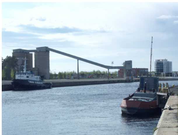
Toppilan satama, laiturirakenteita ja Toppilansaaren puoleinen sementtisiilo. Kuva: Eino Niskala
