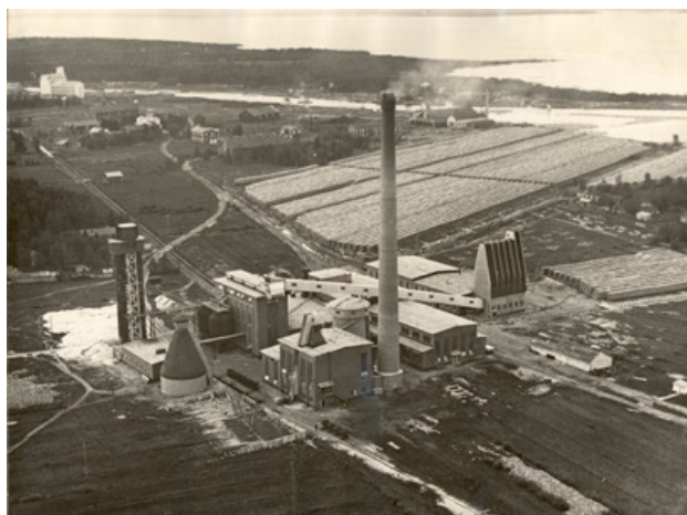
Osakeyhtiö Toppilan selluloosatehdas taustallaan puukentät ja Toppilan sahan entisiä rakennuksia. Kuva: Pohjois-Pohjanmaan museo
