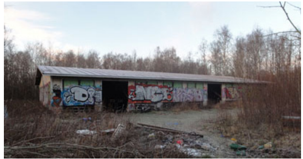
Venevaja on rakennettu 1960-luvun alussa. Kuva: Kaarina Niskala
