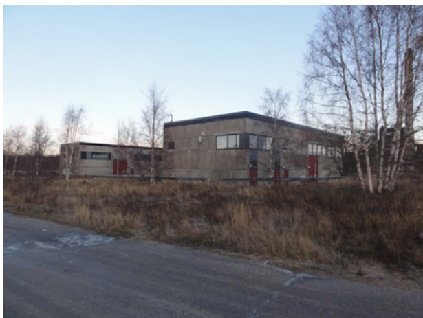
Oulun Energian Toppilan voimaloiden pumppaamot. Kuva: Kaarina Niskala
