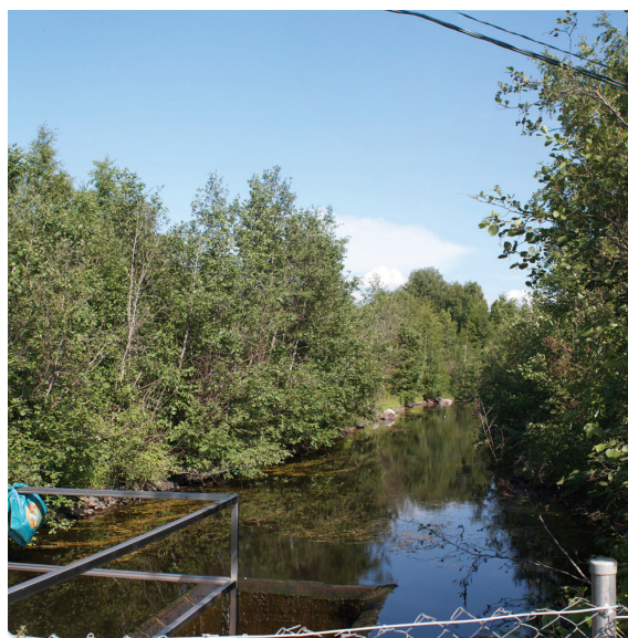
Kuva 8. Lauhdekanavan umpeenkasvanut reunakasvusto
