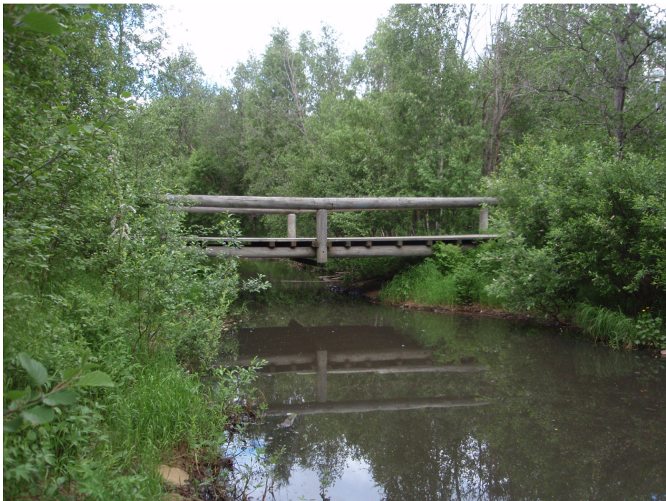
Kuva 10. Toppilan rantapuiston läpi kulkeva ruostevetinen oja rajautuu lehtipuistikkoon. (Kuva: Sauvola)
