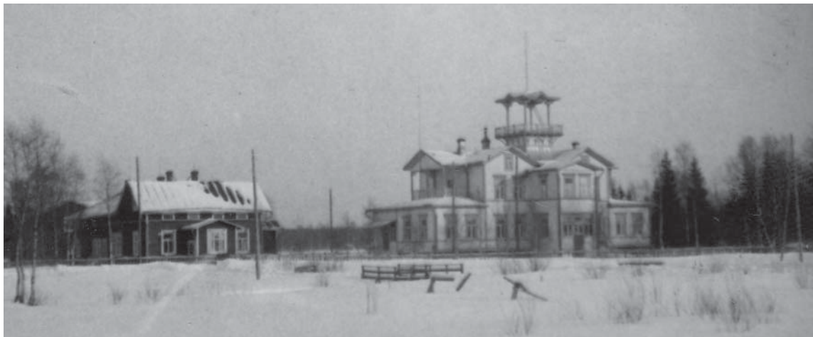
Toppilan sulfiittitehtaan konttori. Valokuva Uno Laukka 1950-60 -luku. UL 538 PPM.
