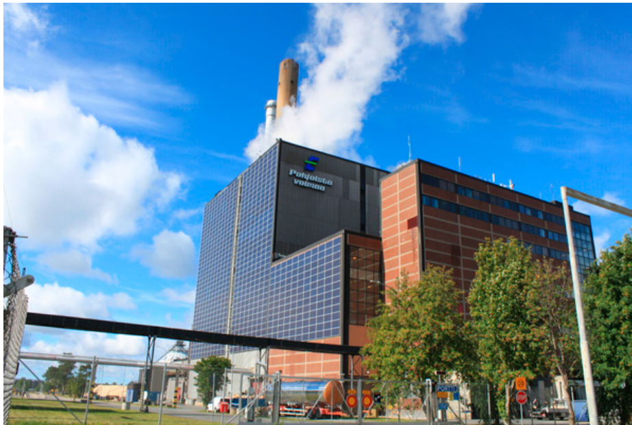
Toppilan voimalaitoksen julkisivun aurinkoseinä on Suomen suurimpia ja sähkön tuotanto on ylittänyt odotukset. Kevät/kesäaikaan sähkön tuotto oli parhaimmillaan noin 28 000 kWh.
