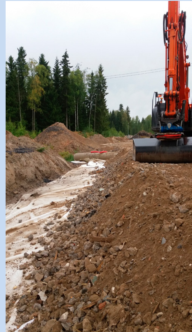
Resurssiviisas infrastruktuuri –hankkeen yhtenä osaprojektina toteutettiin Kipsitien rakentaminen kierrätysmateriaaleja hyödyntäen.
