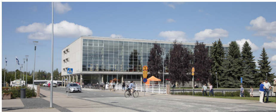
Pääkirjaston vuotuisesta sähkönkulutuksesta noin 15 % katetaan aurinkosähköllä.
