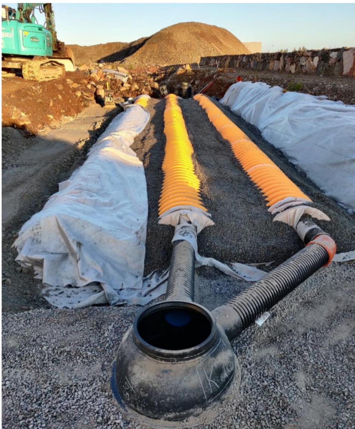
Kuva 2. Hulevesitunnelin periaate. Kuva: Viacon Oy.
