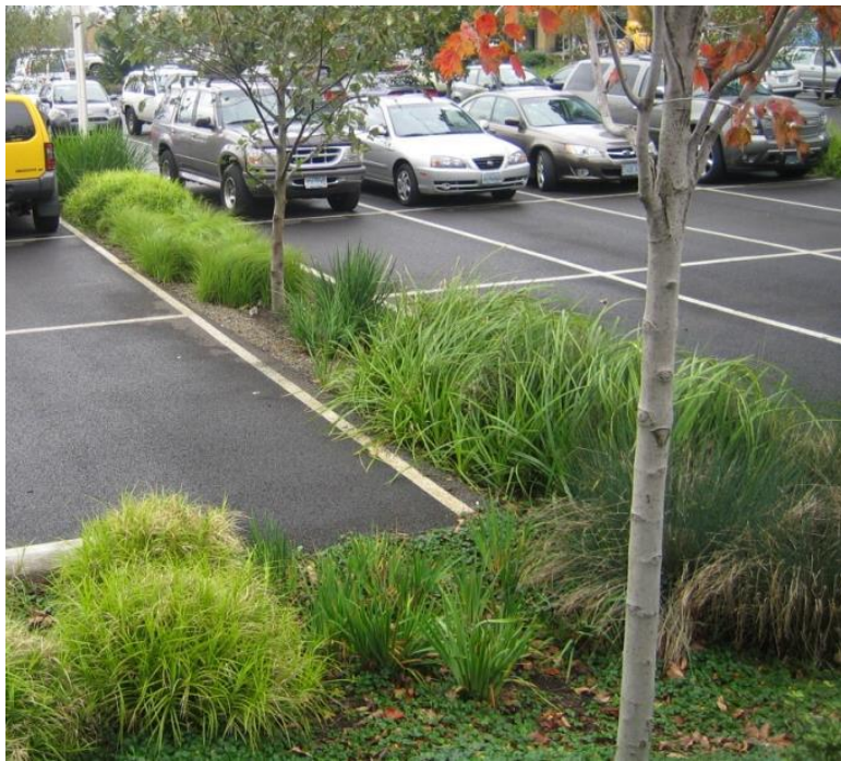
Kuva 6. Pysäköintialueen hulevesien hallintaa biosuodatusrakenteella. Hulevesi pääsee biosuodatusalueelle suoraan ilman reunakiveyksiä ja niihin tehtäviä aukkoja (vrt. kuva 6). Seattle, USA.
