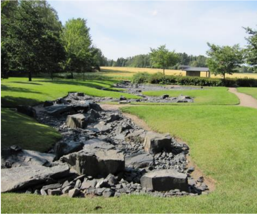
Kuva 8. Tyypikuva suodattavasta viivytyspainanteesta.
