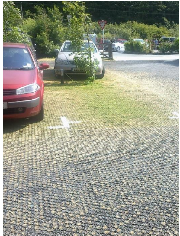
Kuva 4. Muovisella vahvikekennolla tuettuja pysäköintialueita. Kennoa voidaan käyttää vahvistamaan sorapintaa (oikea kuva, Englanti) tai kenno voidaan vähemmän liikennöidyllä alueella nurmettaa (vasen kuva, Ruotsi).
