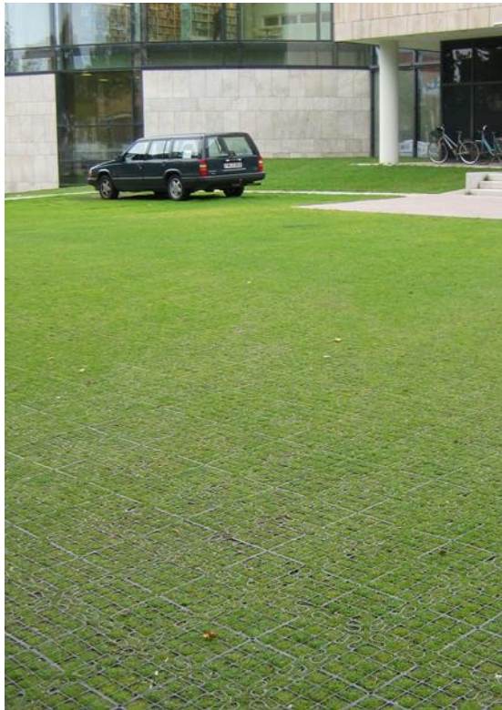
Kuva 4. Muovisella vahvikekennolla tuettuja pysäköintialueita. Kennoa voidaan käyttää vahvistamaan sorapintaa (oikea kuva, Englanti) tai kenno voidaan vähemmän liikennöidyllä alueella nurmettaa (vasen kuva, Ruotsi).
