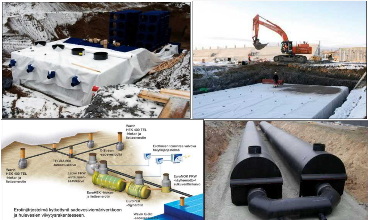
Kuva 13. Vasen yläkuva: Maanalaisen viivytystilavuudeltaan 300 m 3 kennoston rakentamista Tampereen Tykkikentkadulla (FCG). Oikea yläkuva: hulevesikasettien asentamista (Wavin Finland), Vasen alakuva: esimerkki hiekan- ja öljynerotuksesta (Wavin Finland), Oikea alakuva: esimerkki vedenpitävästä säiliöstä (Uponor).
