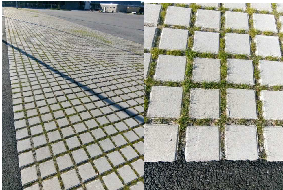
Kuva 11. Esimerkki läpäisevien päällysteiden käytöstä Ouluhallin pysäköintialueella.
