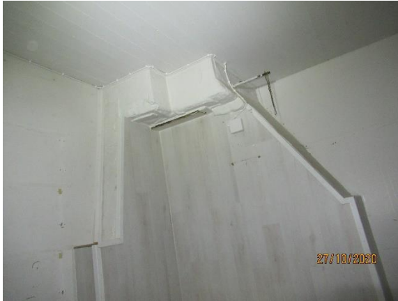
Näyte 4. Hormin tasoite ei sisällä asbestia.
