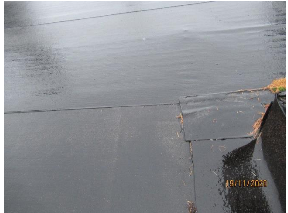
Näyte 11. Päärakennuksen vesikaton bitumikermi.
