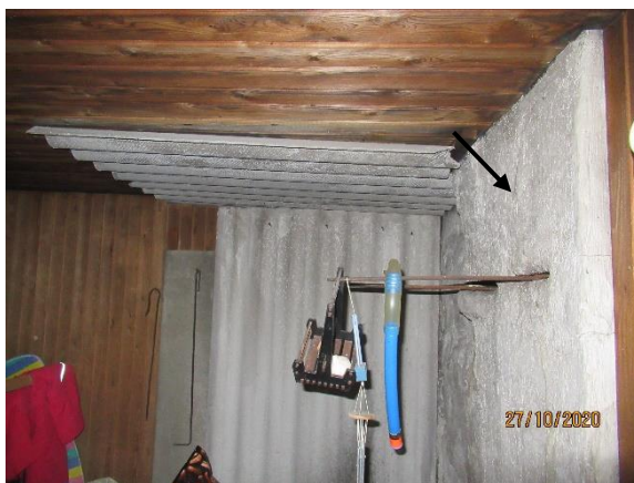
Näyte 2. Saunan hormin tasoite ei sisällä asbestia.
