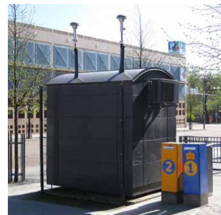
Oulun ilmanlaatua mitataan kolmella kiinteällä mittausasemalla, kuvassa keskustan mittausyksikkö.
