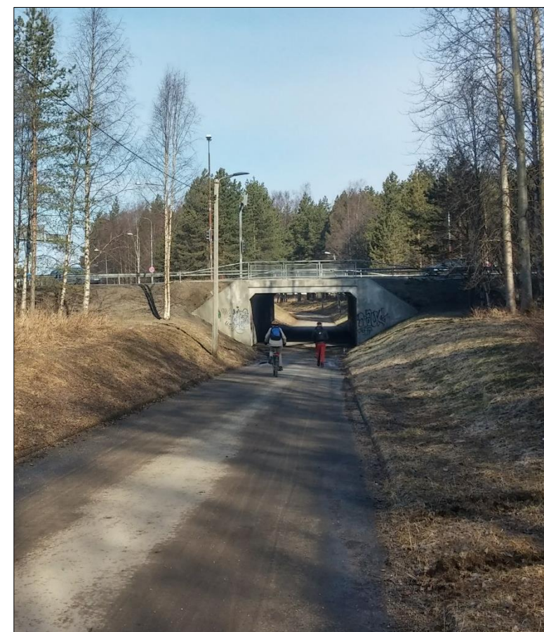
Kuva 9. Kemintien alittava alikulku Tervahovintien liittymässä.
