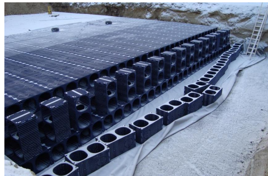
Kuva 20. Kasettiratkaisu esimerkkinä maanalaisista hulevesien hallintaratkaisusta.
