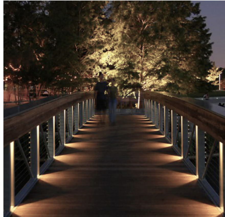
Esimerkkikuva 1. Kevyenliikenteensilta, matala, rakenteisiin huomaamattomasti asennettu valaistus. Taustalla maisemavalaihdusta.
