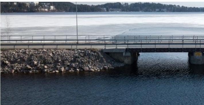
Kuva 28. Esimerkki sillan maatuen penkereestä, Vastavalo.net
