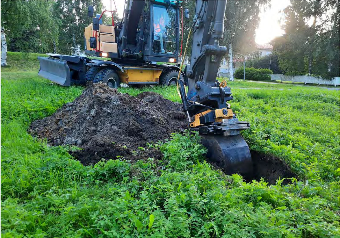
Kuva 1. Koekuopan 1 kaivu Tervaporvarin puistossa.
