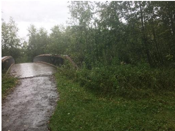
Kuva 8. Kutteripolun silta, pohjanlepakon ohituspaikka etualalla.
