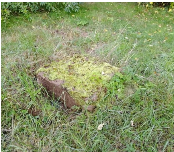
Kuva 31. Betonirakenteinen, mahdollisesti kaivonkansi.
