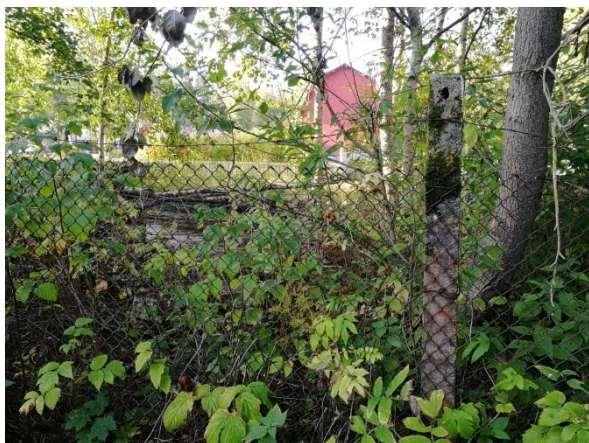
Kuva 29. Tontin eteläreunan metalliverkkoaita.
