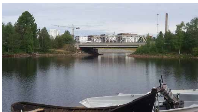
Kuva 24. Hietasaarentien silta kehystää näkymää Hartaanselältä kohti Toppilansalmea.
