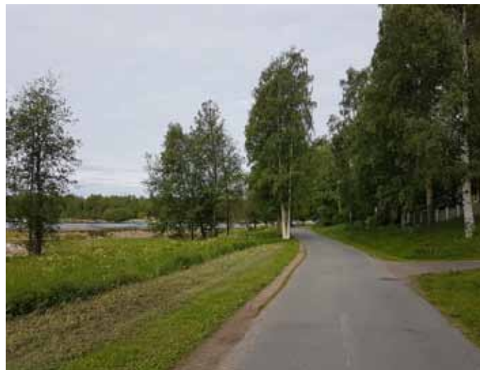
Kuva 16. Kevyen liikenteen seudullinen pääreitti Hartaanrannassa.
