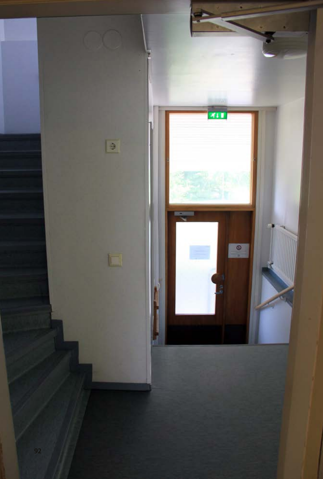
221. Tammiviilutettu ja rautalankalasilta varustettu ulko-ovi on 1950-luvun lopulta ja kunnostettu myöhempien peruskorjauksen yhteydessä. Helat ja lukitus on uusittu 2000-luvulla.
