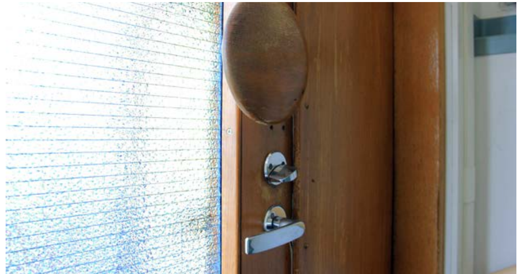
221. Tammiviilutettu ja rautalankalasilta varustettu ulko-ovi on 1950-luvun lopulta ja kunnostettu myöhempien peruskorjauksen yhteydessä. Helat ja lukitus on uusittu 2000-luvulla.
