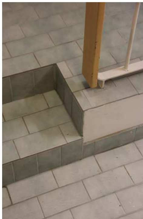
263. Kellarin lattia on päällystetty vaalealla lasitetulla keraamisella laattalla.
