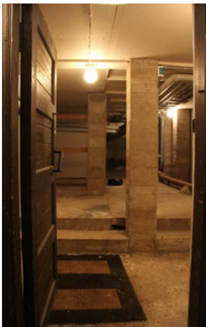
280. Näkymä kellarista kylmään ryömintätilaan, joka on osaksi betonoitu ja paloeristetty.
