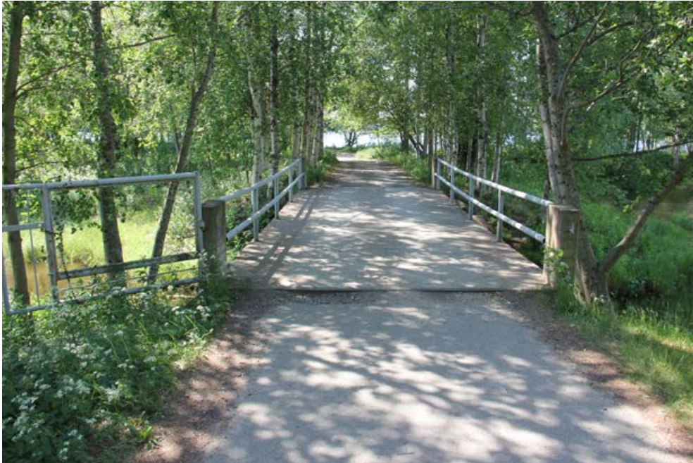
104. Tukkiisaaren ja rantatörmän välissä kulkee kapea uoma. Sen yli johtaa ajoneuvon kantava teräsbetonikantinen silta, joka on rakennettu Uiton talon tapaan vuonna 1938.
