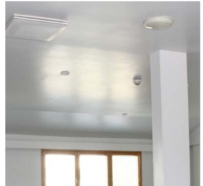
159. Kokoonmistilan alakatto on yhtenäinen levypinta. 1990-luvulla uusituissa katoissa ei ole listoituksia.
