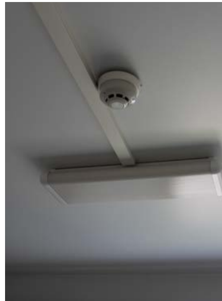
158. Ensimmäisen kerroksen asuinhuoneissa on suorat sisäkatot. Niihin on myöhemmin lisätty pinta-asennuksia.
