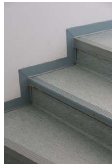
228. Porrasaskelmat on päällystetty vinyylimatolla. Ulkosärmässä on kumilista ja sivuilla muovilista.
