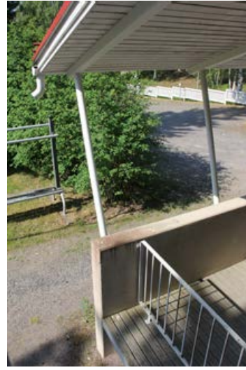
143. Rannan puolella katoksissa on peltikate. Porrastasanteen laita on varustettu teräskaitteella.
