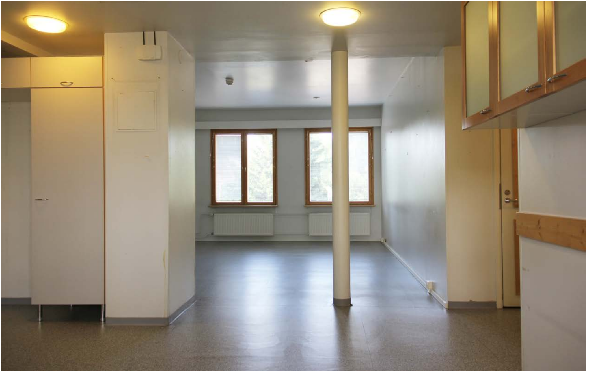
247. Ensimmäisen kerroksen kokoontumistila tupakeittiön suunnasta katsottuna. Vasemmalla on naulakkokomerot. Oikealla näkyvän seinän takana on saunaosasto. Kantavan seinälinjan paikalle on istutettu pyöreä teräspilari.
