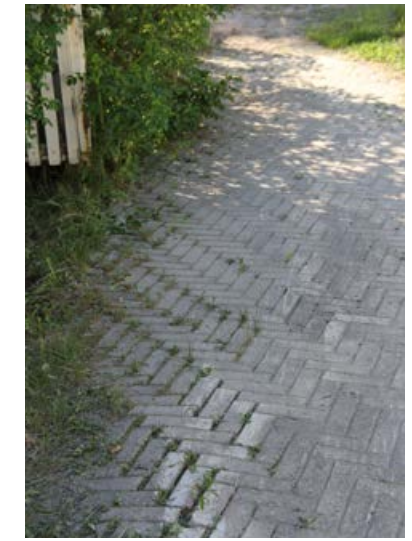
116. Koskitien puolella piha on päällystetty betonikivillä.
