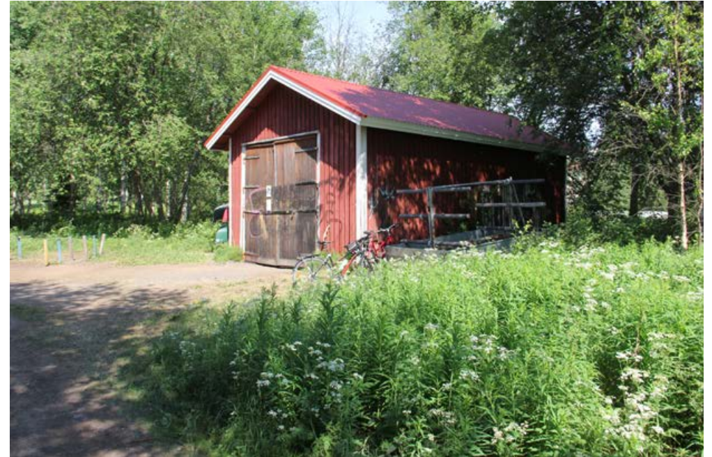
105. Vanha varistorakennus on Uiton talon lisäksi ainoa Tukkiisaaren erottelupaikalla säilynyt rakennus. Se toimii nykyisin melontaseuran kanoottivarastona.
