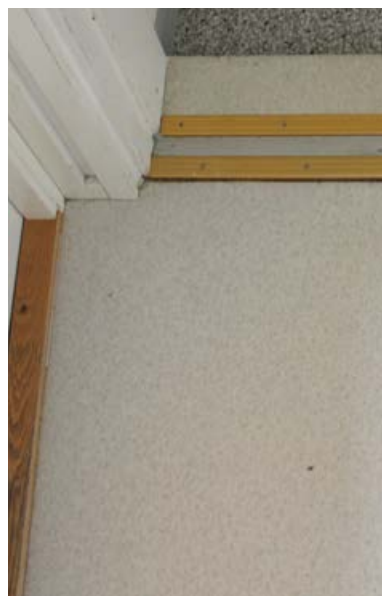
165. Käytävissä ja asuinhuoneissa on käytetty vaaleanharmaa vinyylimattoa.
