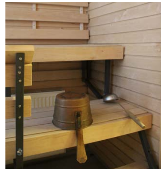
261. Saunassa on kokoontaitettavat lauteet.
