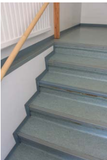
225. Porrashuoneen matto on 1990-luvulta.
