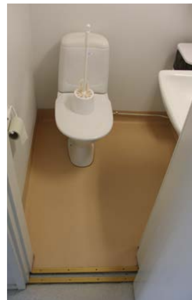
168. Vanhimmissa WC-tiloissa on käytetty ruskeaa muovimattoa
