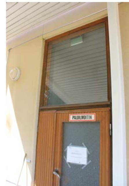
136. Oven yläpuolella olevaan ikkuna-aukkoa suurennettiin 1950-luvun muutoskorjauksessa.
