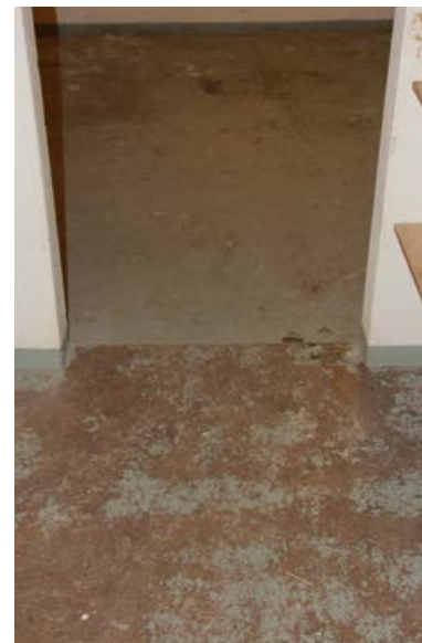
170. Itäpäädyn kellarissa on alkuperäinen maalattu betonilattia.
