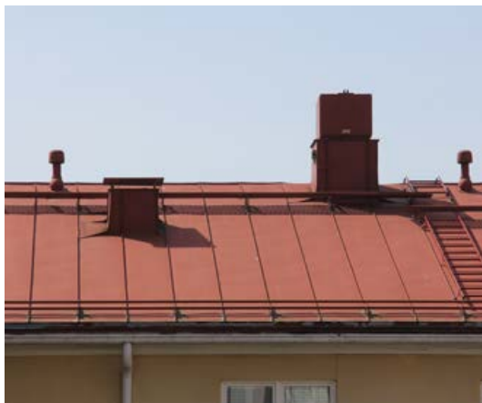
128. Katto Koskitien puolelta katsottuna. Yläpohjan tuuletusventtiilejä on harjalinjassa neljä. Korkeassa osassa on huippuimuri.
