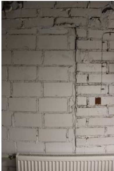
274. Lämmönjakuhuoneesta ryömintätilaan johtanut oviaukko on muurattu umpeen.
