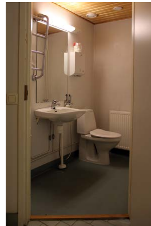
265. WC:n lattia on päällystetty muovimatolla. Alakatto on paneloitu.
