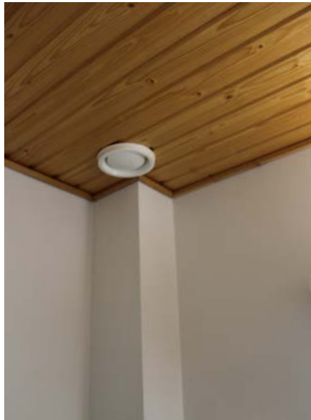
157. Saunoissa, wc:ssä ja pesutiloissa on paneloidut alakatot. Paneeli on lakattua mäntyä.
