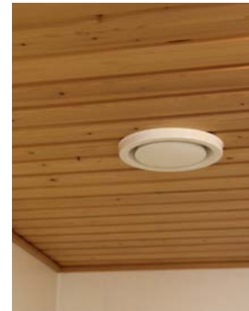
216. Poistoilmaventtiili WC:ssä
