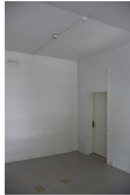
237. Asuinhuone H2 toisessa kerroksessa on muita huoneita korkeampi. Huonekorkeus on viite alkuperäisten miehistöhuoneiden muotoon.
