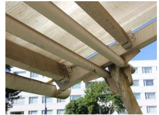
140. Teräsrunko kannattelee sisäänkäynnin valokatetta.
