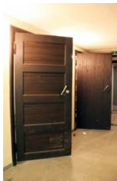
178. Alkuperäiset 1940-luvun ovet kellarin itäosassa.
