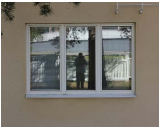
131. Ensimmäisen kerroksen vaakasuuntainen ikkuna-aukko on muodoiltaan alkuperäinen. Ikkuna on 1950-luvun mallia.
