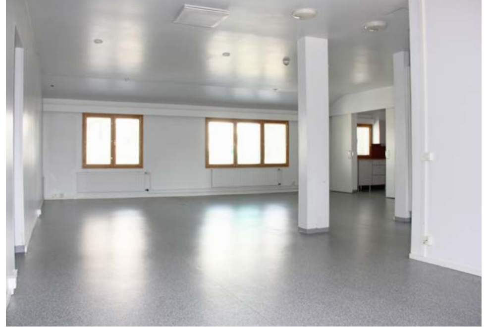
244. Toisen kerroksen kokoontumistila etelän puoleiselta seinustalta katsottuna. Purettu kantava seinälinja on korvattu pilareilla.
