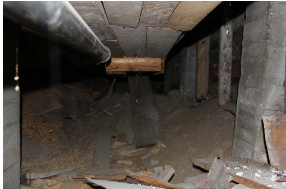
286. Noin kolmasosa rakennuksen alapuolisesta tilasta on edelleen kaivamatonta perusmaata. Vasemmalla näkyvä betonipilari tukee puurakenteista alapohjaa. Oikealla näkyy Koskitien puoleisen sokkelin betonipilareita.
