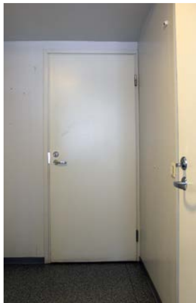
172. Asuinhuoneen huullettu laakaovi.
