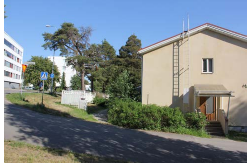
137. Esteetön sisäänkäynti on tehty Koskitien puolelle, jossa maa on ensimmäisen kerroksen tasalla.
