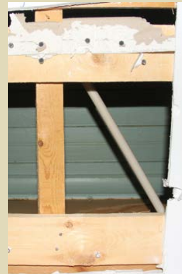
150. Alkuperäistä helmiponttipanelointia on säilynyt myöhempien alakattorakenteiden alla.
