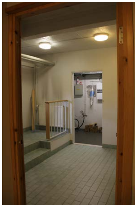
264. Näkymä pukuhuoneen ovelta. Vasemmalla näkyvät portaat johtavat ulko-ovelle. Perällä näkyy sähköpääkeskus.
