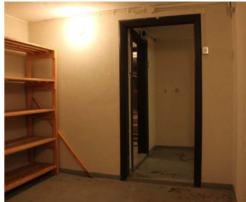
276. Kellarissa on kaksi erillistä varastohuonetta. Niiden välinen väliseinä on muurattu kahden tuuman tärytileistä.
