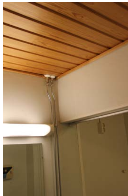
259. Vanha väliseinä pukuhuoneen ja suihkutilan väliltä on purettu. Sen yläosa on jätetty palkiksi.
