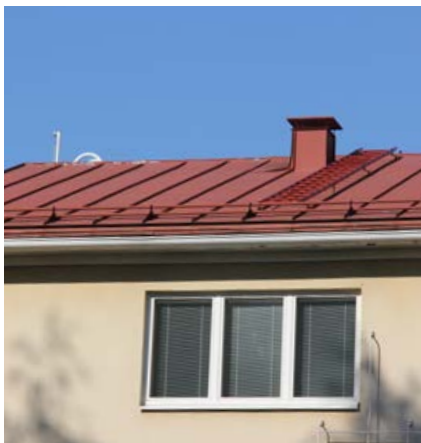
127. Vesikate uusittiin vuonna 2000. Samalla asennettiin uudet kattoturvatuotteet.
