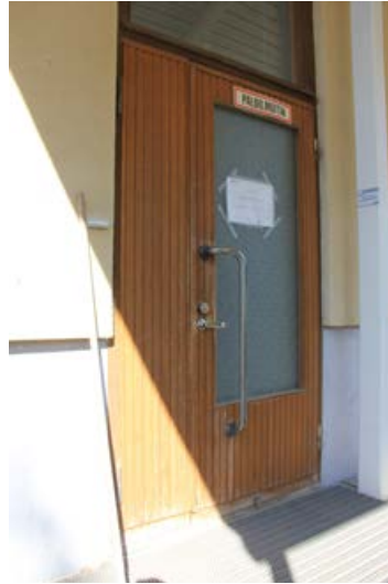
142. Vasikallinen ulko-ovi on vuodelta 1958 ja kunnostettu.
