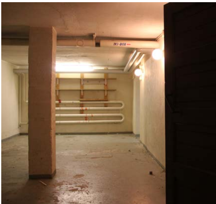
275. Kellarin keskiosaa on nykyisin avoin tila, josta kellarikomeroitten väliseinät on poistettu. Tilassa on rakennusta kannattelevia muurattuja harkkopilareita. Takaseinällä näkyy alkuperäinen putkipatteri.
