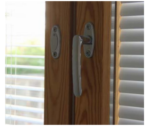
188. Sisemmässä ikkunassa on lämpölasia. Helat ovat tyypillisiä 1990-ikkunavarusteita.
