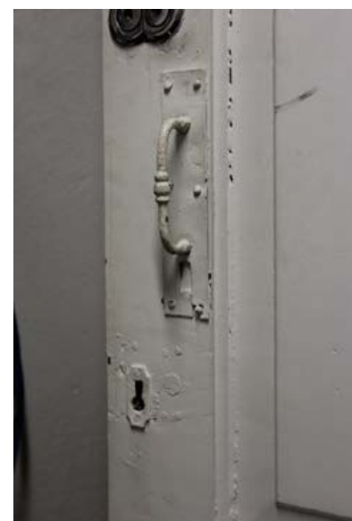
273. Sähköpääkeskuksen vanha ovi on yksi talon harvoista alkuperäisistä rakennusosista.
