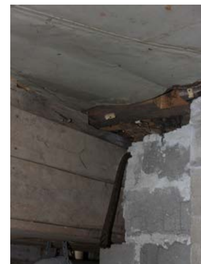
285. Kellarin alakattoa on vuorattu sinkkipeltilevyillä.
