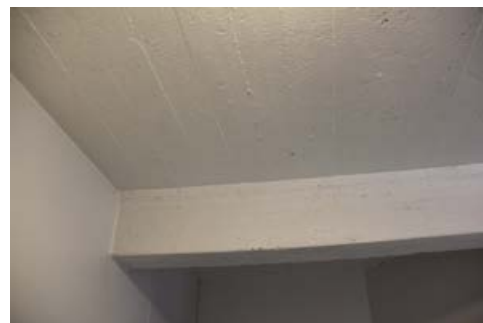
161. Kellarin länsiosan alakattona on alkuperäinen lautamuotittu valettu betonikatto, jonka alapalkit ovat näkyvillä.
