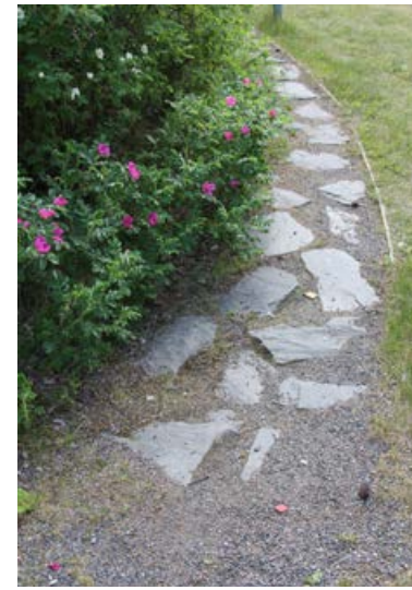
115. Liuskekivipintainen pihapolku jatkaa kivituhkalla päällystettyä pihaa.
