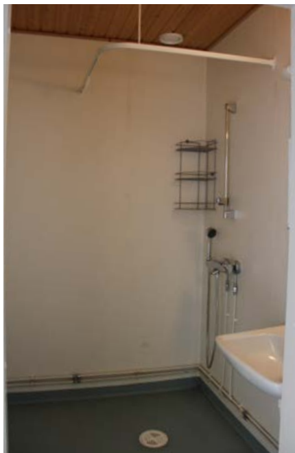
257. Toisen kerroksen käytävän päässä olevan suihkuhuoneen varustus on pelkistetty.
