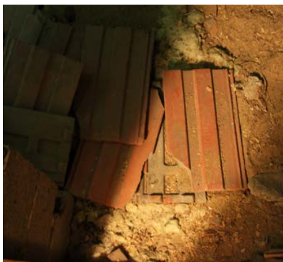
283. 1950-luvulla vesikaton eterniittikate vaihdettiin tiileen. Sementistä tehtyjä valssitiiliä on varastoitu kellarin ryömintätalassa.
