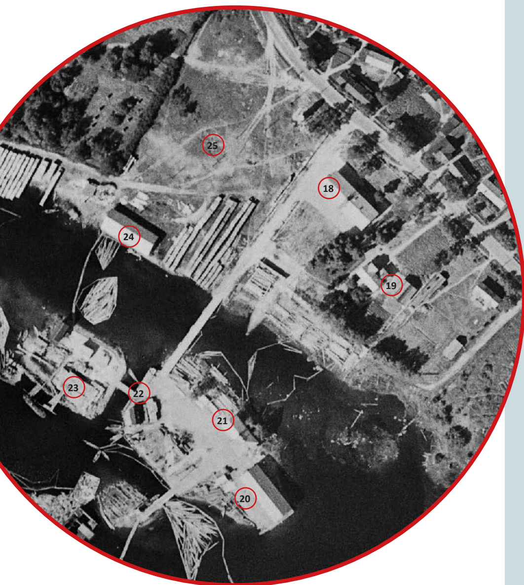
21. Osasuurennos vuoden 1939 ilmakuvasta Tukkiisaaren kohdalta. Syksyllä alkaa talvisota ja seuraavina sotakesinä erottelutyömaa on hiljainen. KUVA: Oulun kaupungin yhdyskunta- ja ympäristöpalvelut
