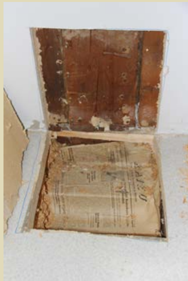
152. Pystyhirsirunko on tiivis ja tilkettä on tarvittu vähän. Tässä huoneessa sen sisäpuolelle on asennettu puukuitulevy ja kipsilevy.
