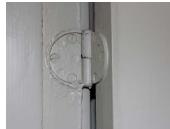
240. Toimiston väliovi on 1950-luvulta säilynyt laakaovi, jossa on aikakaudelle tyypilliset norjalaistyyppiset saranat.
