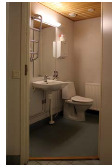
256. Kellarin saunaoasaston wc
