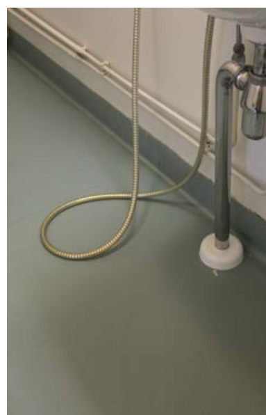
167. Märkätiloissa on käytetty siniharmaa muovimattoa.
