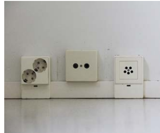
202. Lattialistaa on käytetty yleisesti johtokouruna.
