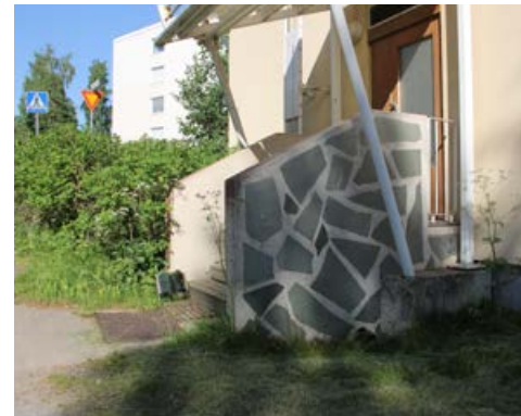
139. Porraskaiteet on tehty betonista ja verhoiltu luonnonkivillä.
