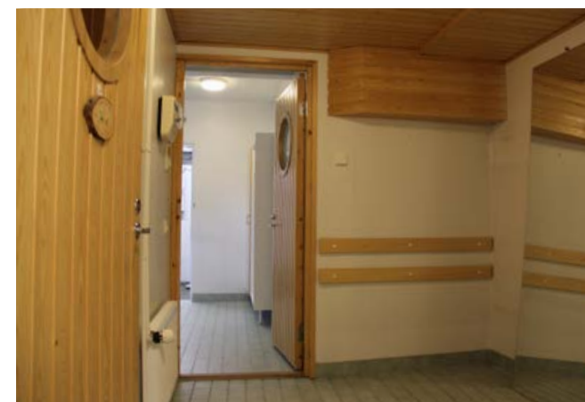
266. Kuvassa on saunan pukuhuone, jonka takana on sosiaalitila ja lämmönjakohuone. Pukuhuoneen kalusteet on poistettu. Vasemmalla on ovi löylyhuoneeseen.
