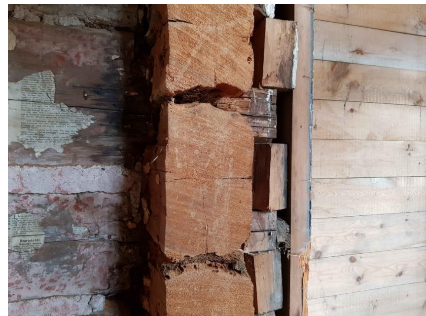
Hirsirakenteisen ja lautarakenteisen osan liitoskohta.
