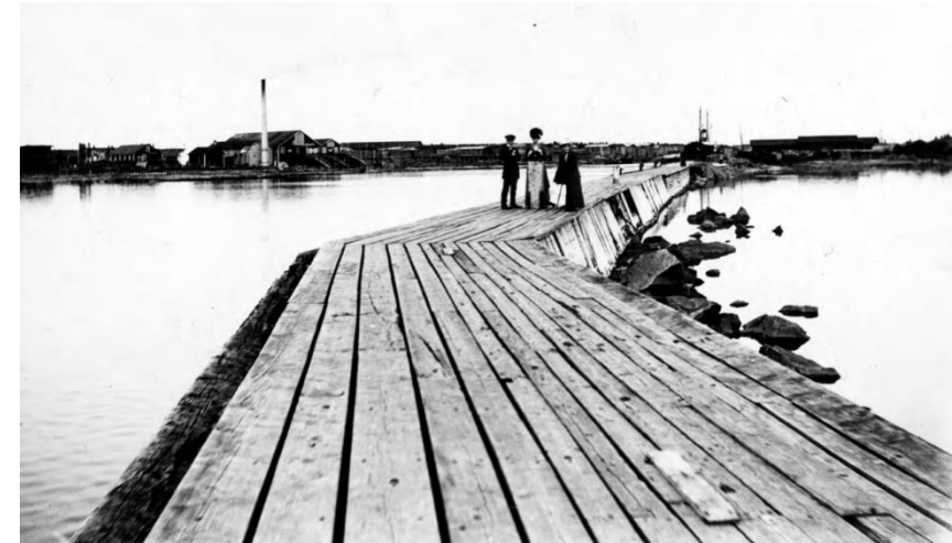
Toppilansalmi oli paalutettu molemmin puolin noin kahden kilometrin matkalta. Tämä rantalaituri eli möljä oli kaupunkilaisten suosima kävelypaikka kesäiltaisina. Kuvassa aallonmurtajasta vasemmalle salmen pohjoisrannalla näkyvät Toppilan sahan rakennukset. (Kuva Pohjamo 2011, 56. Alkuperäinen lähde Pohjois-Pohjanmaan museo).
