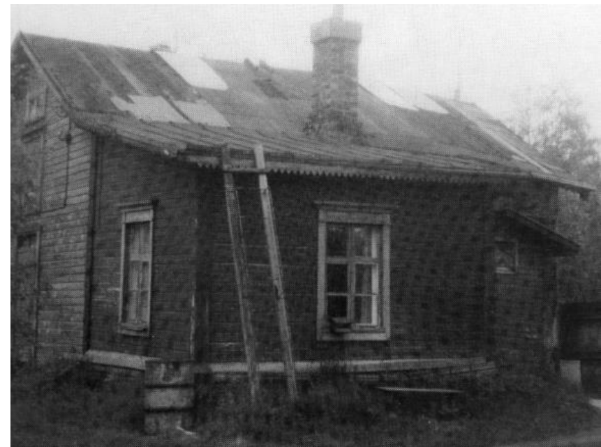
Saman tyyppinen sahalaitakuviainen koristelista on ollut Hannalan piharakennuksen räystäällä. (Kuva Toppilansalmi – Hietasaari. Rakennusinventointi 1992 1993, 31).
