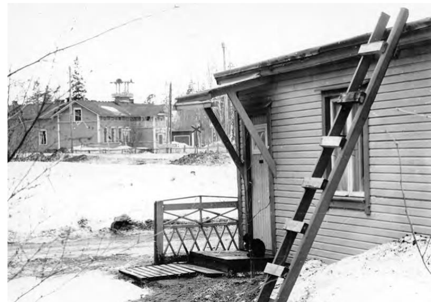
Vaakunakylän parakki vuonna 1981. Kuvassa taustalla näkyy Hietasaaren koulu ja sen takana Hannalan torni. (Kuva Pohjamo 2011, 179. Alkuperäinen lähde Oulun yliopiston arkkitehtuurin osaston arkkitehtuurin historian laboratorion arkisto).
