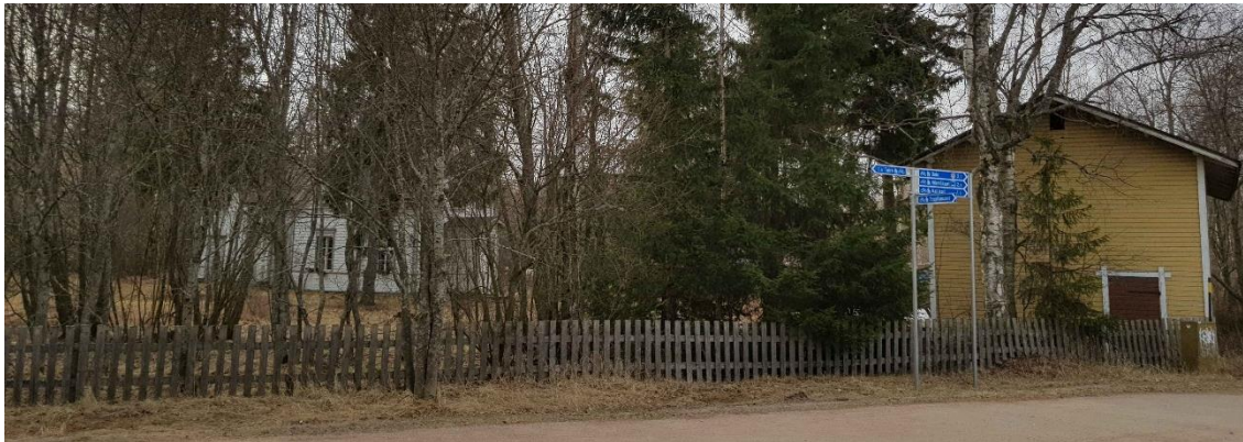
Hietasaarentielle huvila pilkistää puuston takaa. Tien varressa näkyy kaksikerroksinen aittarakennus.
