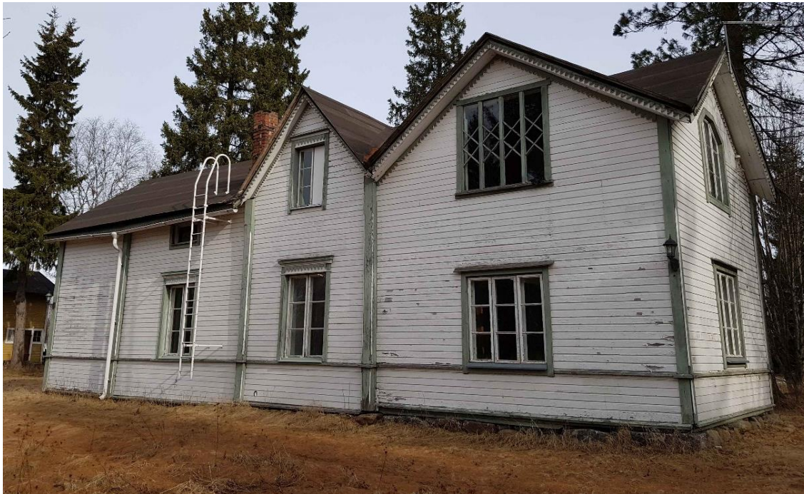
Huvila vuonna 2020, julkisivu etelään. Itäpään ikkunoiden vuorilaudat ja ulkoverhous on uusittu.
