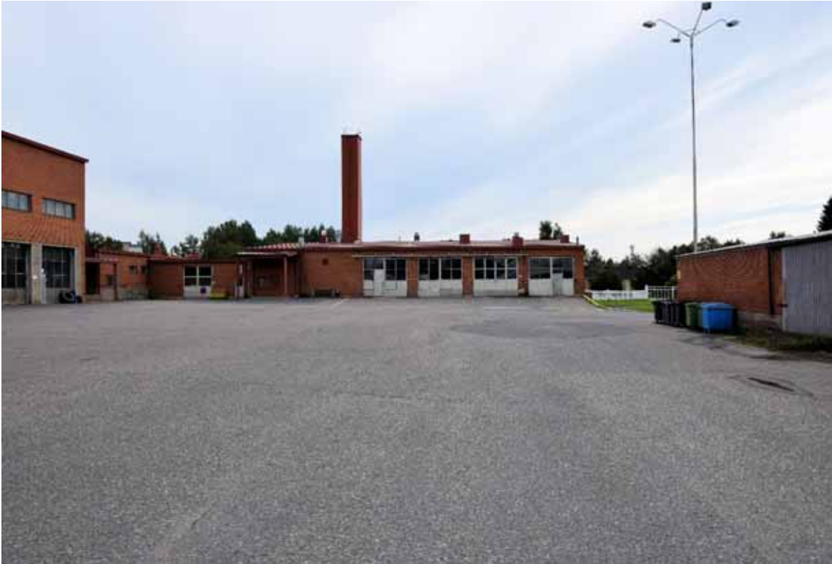
Huoltorakennuksen ensimmäinen kerros on yksityisessä hallinnassa, eikä sinne pääse valokuvaamaan.
