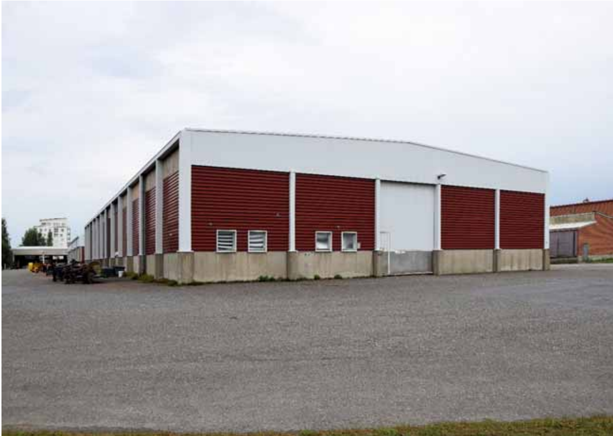
Julkisivut ja sisätilat varikon varastohalli ja auto- ja konehalli
