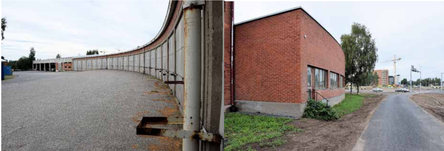
Vanhin autohalli, julkisivu pihan suuntaan ja kadun puolelle:
