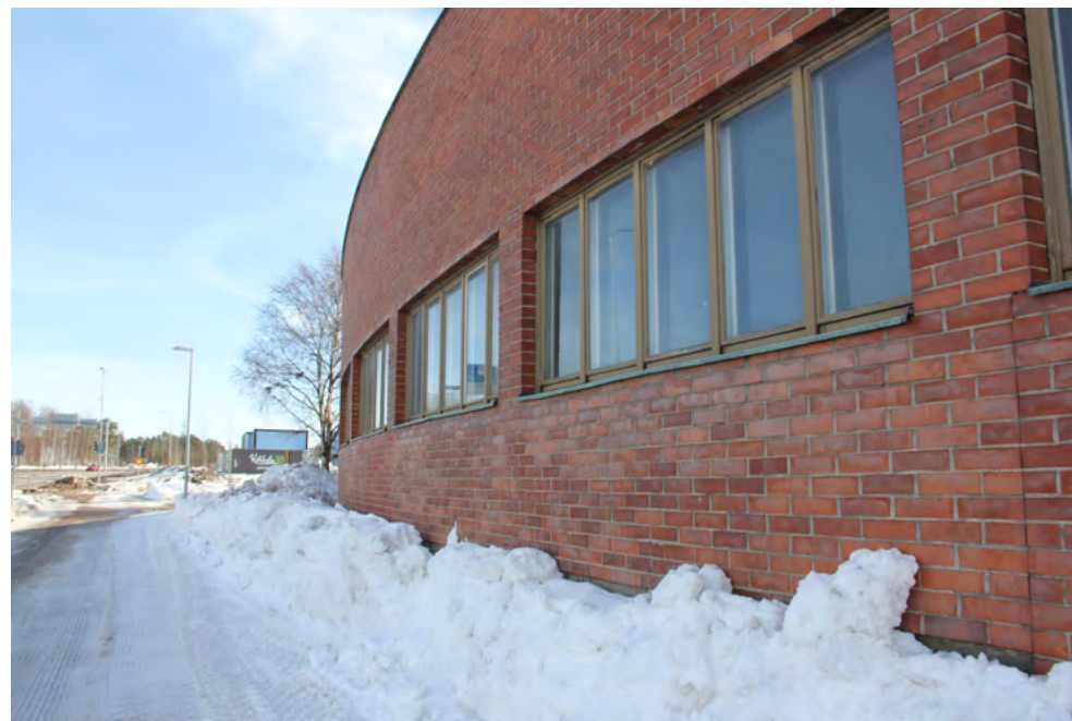
74. Laajennusosan julkisivuissa on 1970-luvulle tyypillinen tasalimitys.
