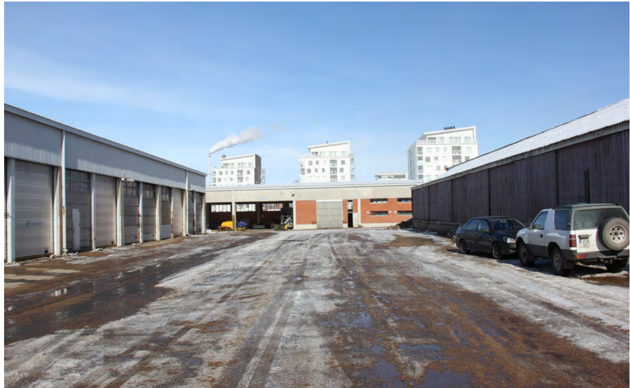
175. Tähän oli määrä tulla pistorata Toppilan satamasta. Oikeanpuoleiset varastorakennukset mitoitettiin rautatiekuljetusten mukaisesti.
