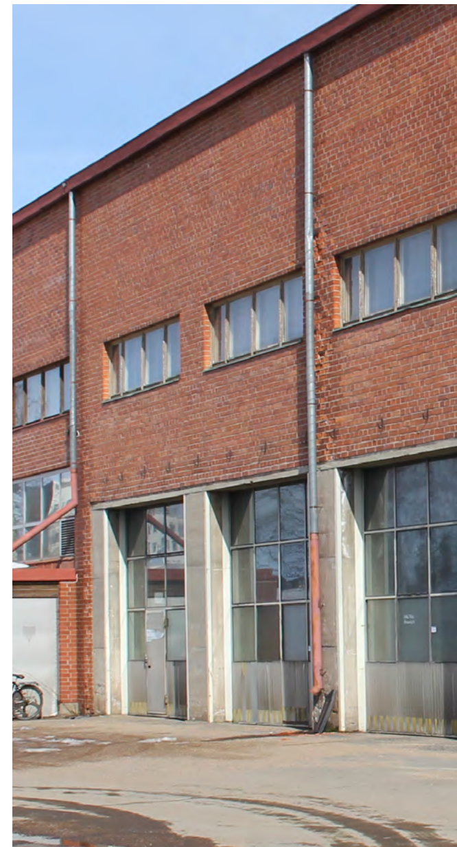
93. Pihan puolella syöksyt johtavat veden ajopihan kuivatusjärjestelmään.
