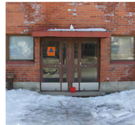
83. Käynti kadulta uuden korjaushallin tiloihin.
