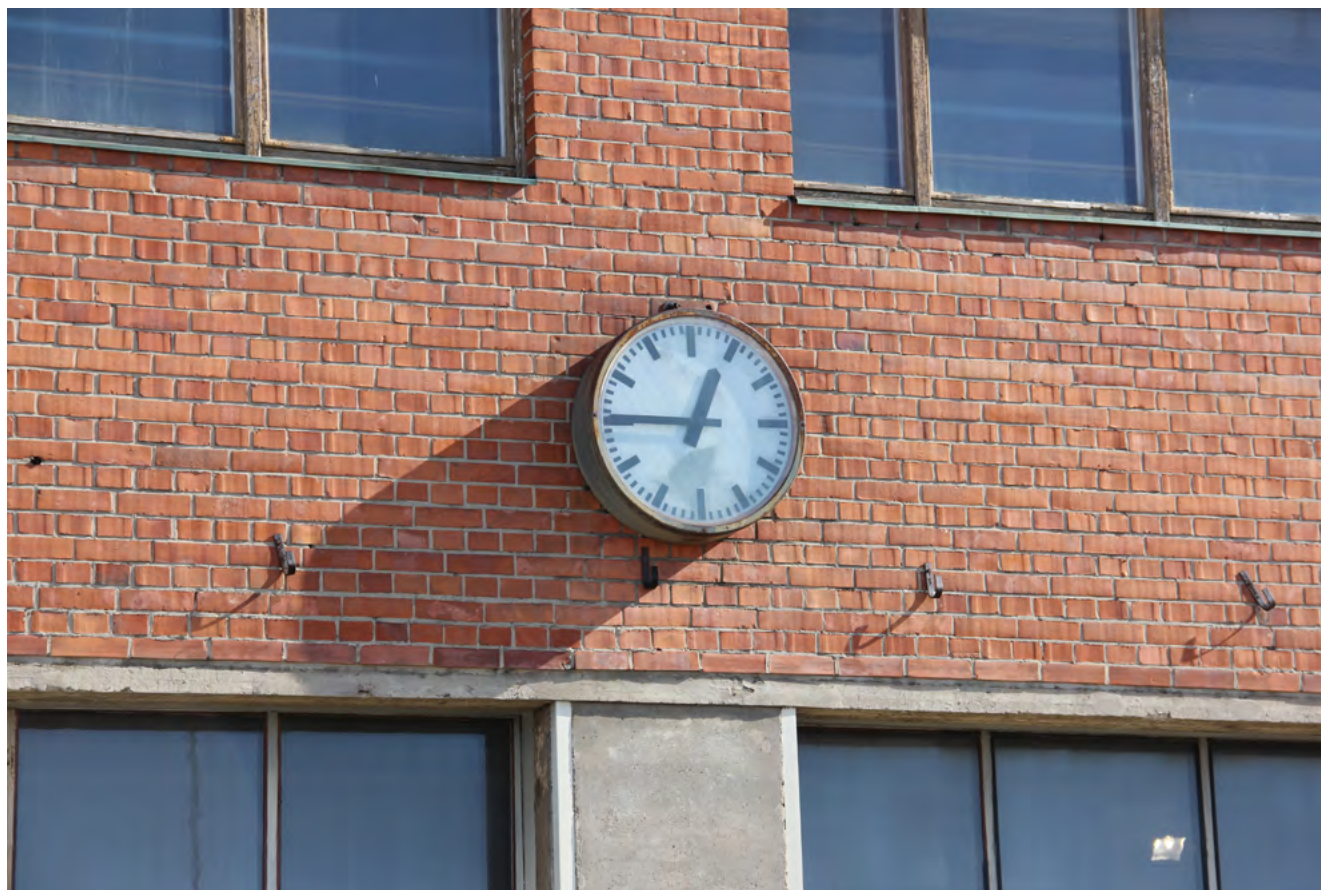
72. Varikon vanhemmassa korjaamohallissa on teräsbetonista valettu pilari-palkki-runko. Punatiilestä muurattujen julkisivujen keveys muodostuu siroista nauhaikkunoista. Detaljiikkaa edustavat myös kupariset ikkunapellit.
