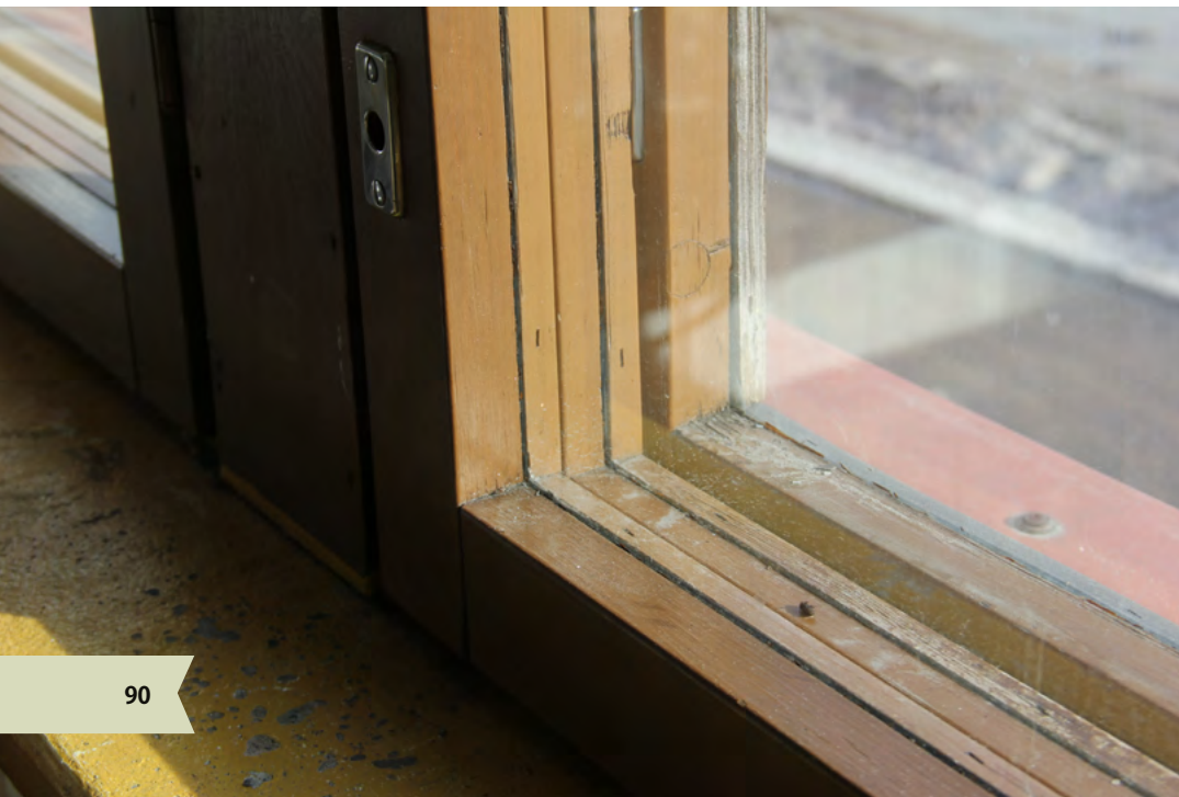
151. Laajennusosan ikkunat ovat kolmilasisia MSK-ikkunoita.
