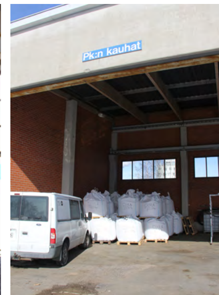
173. Konekatos tehtiin suurille koneille ja painaville laitteille. Katosta käytetään myös lyhytaikaisessa varastoinnissa.
