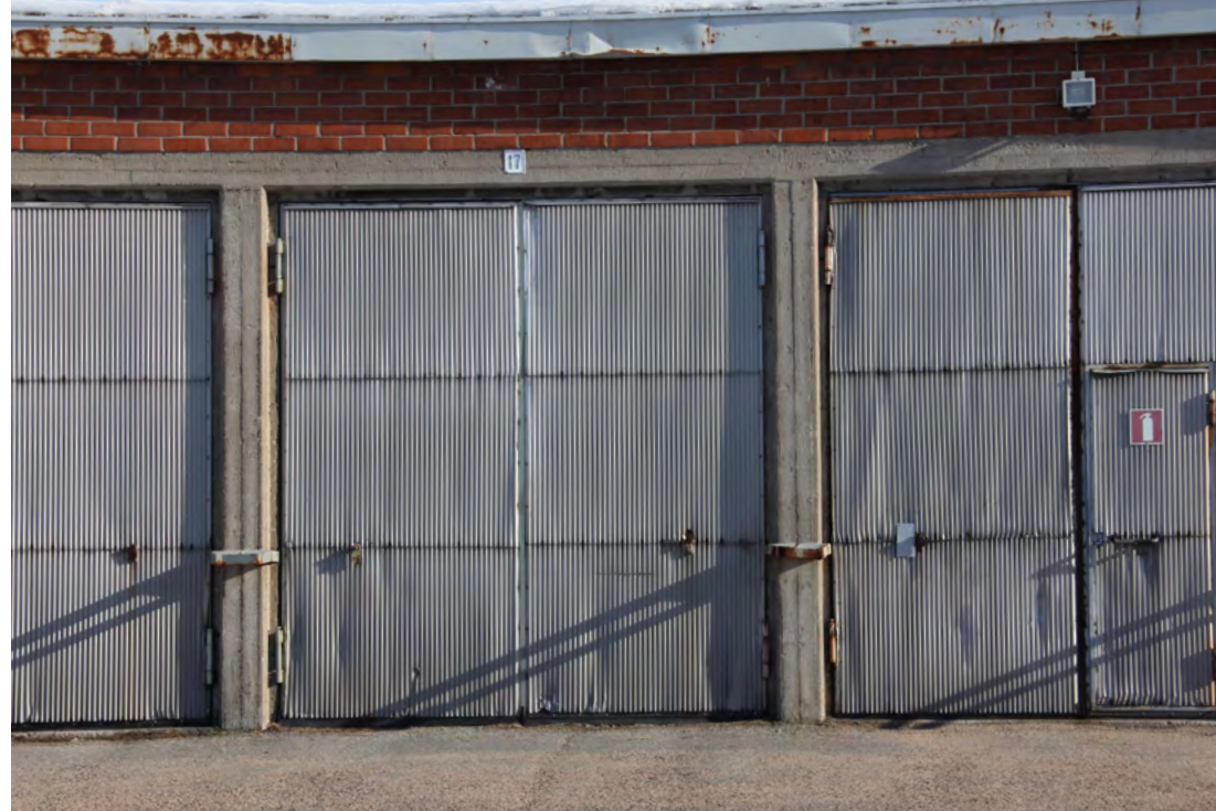
169. Autohalliin poimulevystä tehdyt teräsrunkoiset pariovet.
