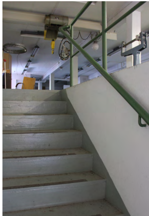
130. Kerrosten väliseen tavaroiden siirtoon käytettiin sähkövinssiä.
