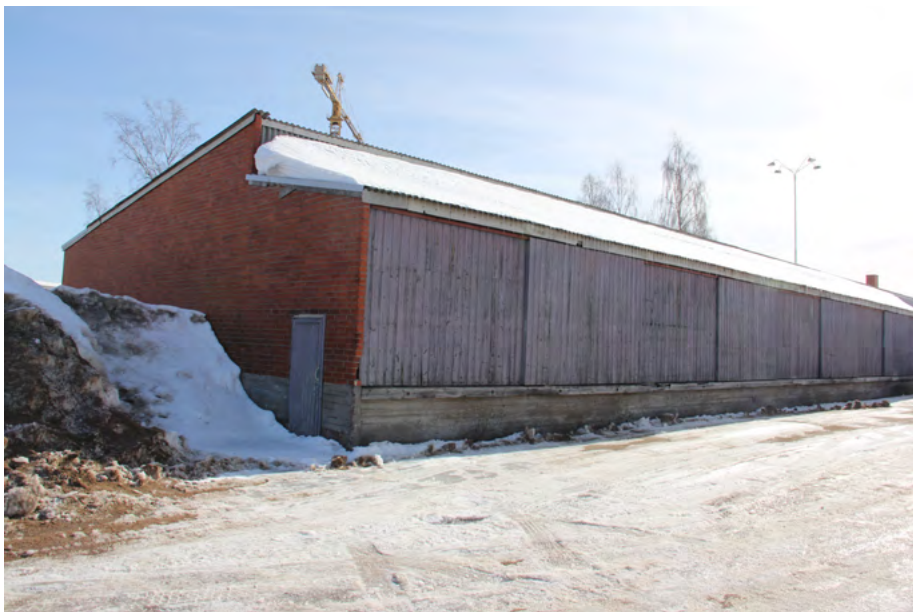
176. Suunnitellun radan puolelle tehtiin lastauslaiturit ja sivuille avautuvat liukuovet.
