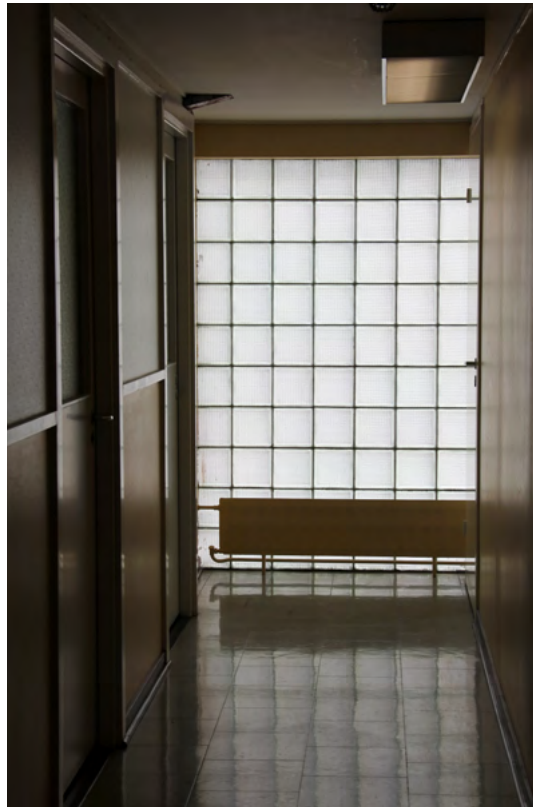
111. Lasitiiliseinä toimiston käytävän päätteellä.
