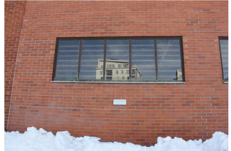
87. Autosuojan laajennuksen ikkunat vuodelta 1982.
