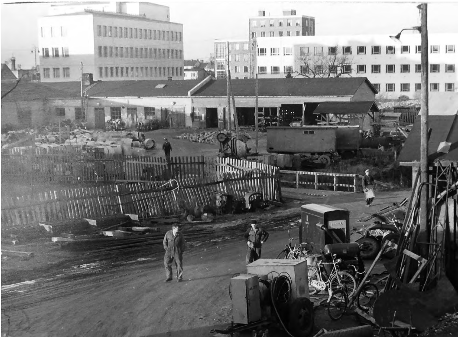
12. Etu-Lyöty'n korjaamon maisemaa. Edessä on betonivalimo ja takana kuutiokivihakkaamo. Taustalla näkyvät Teknillinen oppilaitos, Diakonissalaitos ja Keskuskansakoulu.
