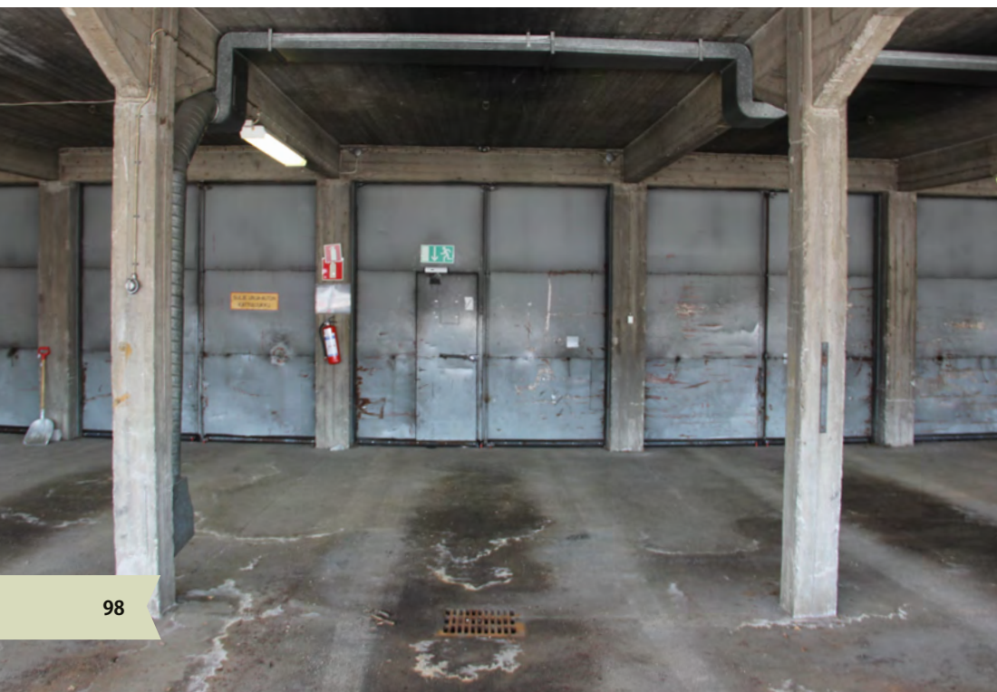
168. Hallin ovet sisäpuolelta.
