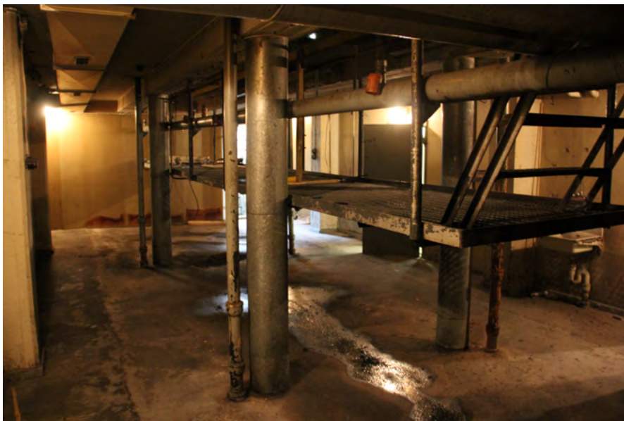
98. Kellarin rasvamonttu on säilynyt alkuperäisenä. Alapuolista huoltosiltää ei enää käytetä.
