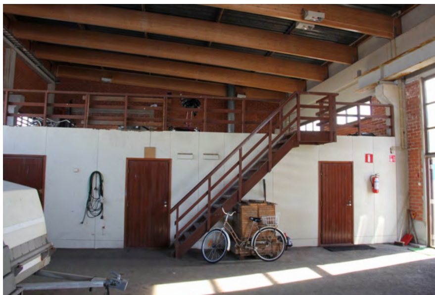
172. Lämpimät toimistotilat on rakennettu konekatoksen sisään. Toimiston yläpuolella on varastoparvi.
