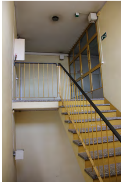
160. Vesihuollon toimistoihin johtava rappukäytävä.
