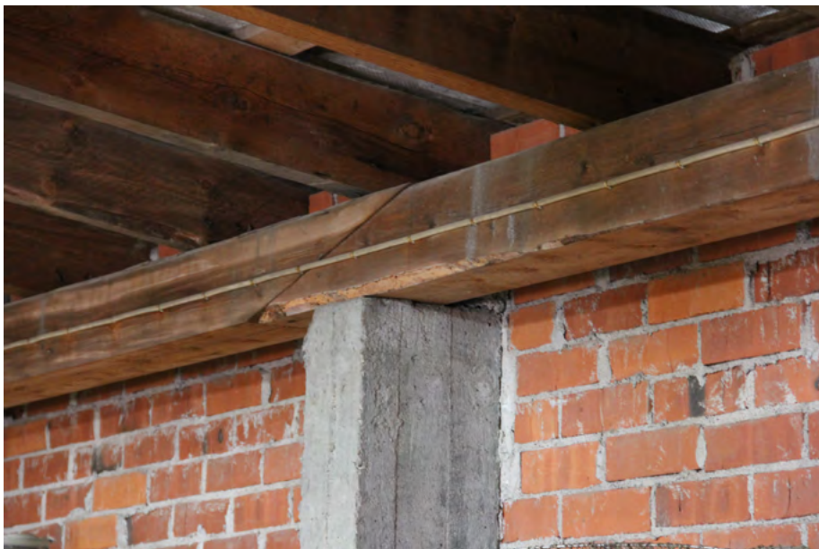
178. Betonipilarit kannattelevat puista vesikattorakennetta.
