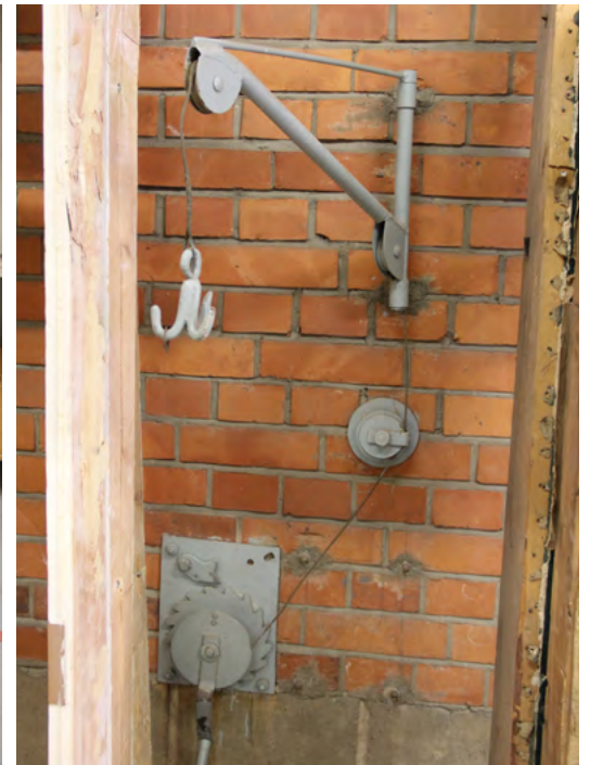
132. Alkuperäinen käsikäyttöinen vinssi.
