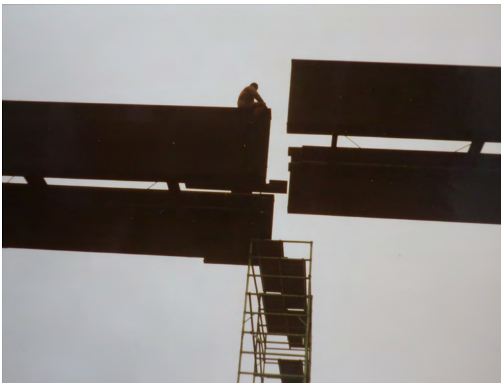
53. Ratapihan ylittävä Kiskopolun silta valmistettiin Tuiran varikon konepajalla vuonna 1981. Varikon väki vastasi myös siltaelementtien asentamisesta. KUVA: Kaupunginvarikon arkisto
