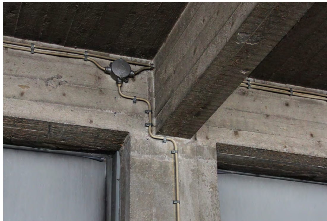
170. Paikalla valettua teräsbetonirunkoa.
