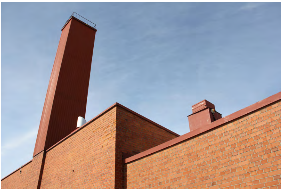
73. Vanhimman osan muurauksessa on käytetty ristilimitystä.
