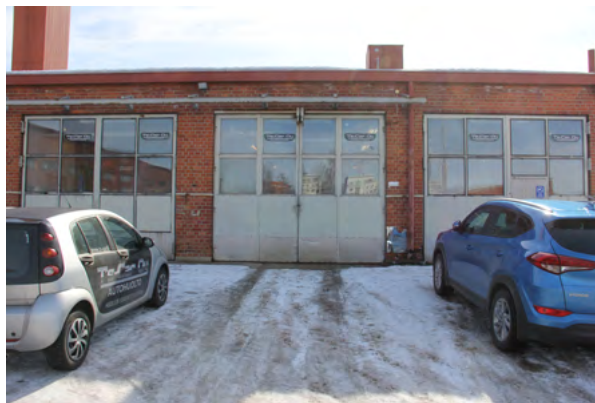
84. Käynti kadulta uuden korjaushallin tiloihin.
