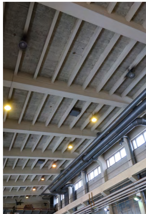
141. Kattoruoteiden väleissä on Toja-levyt.
