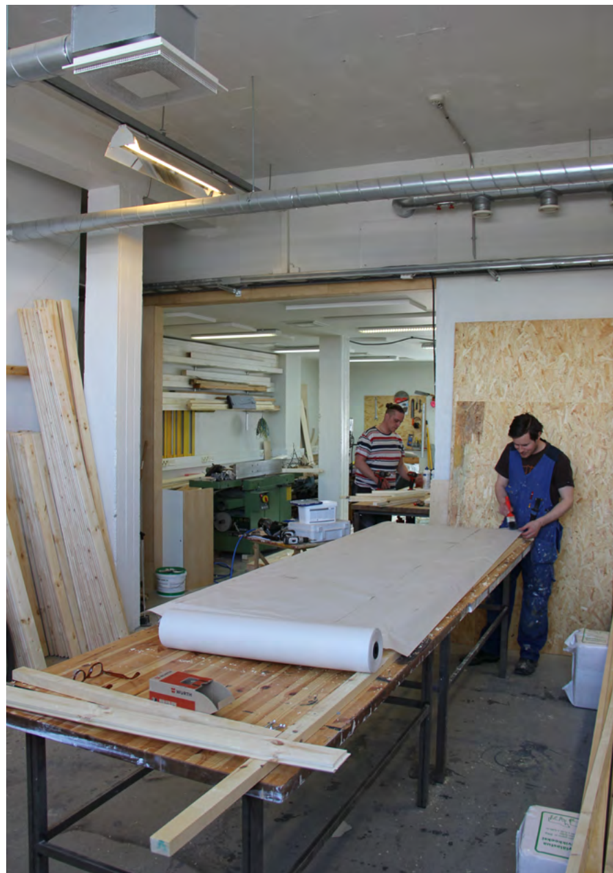
102. Pylväs-palkki-runko on mahdollistanut tilamuutokset. Kahdesta suunnasta tuleva luonnonvalo toteutuu alkuperäisen suunnitelman mukaisesti.
