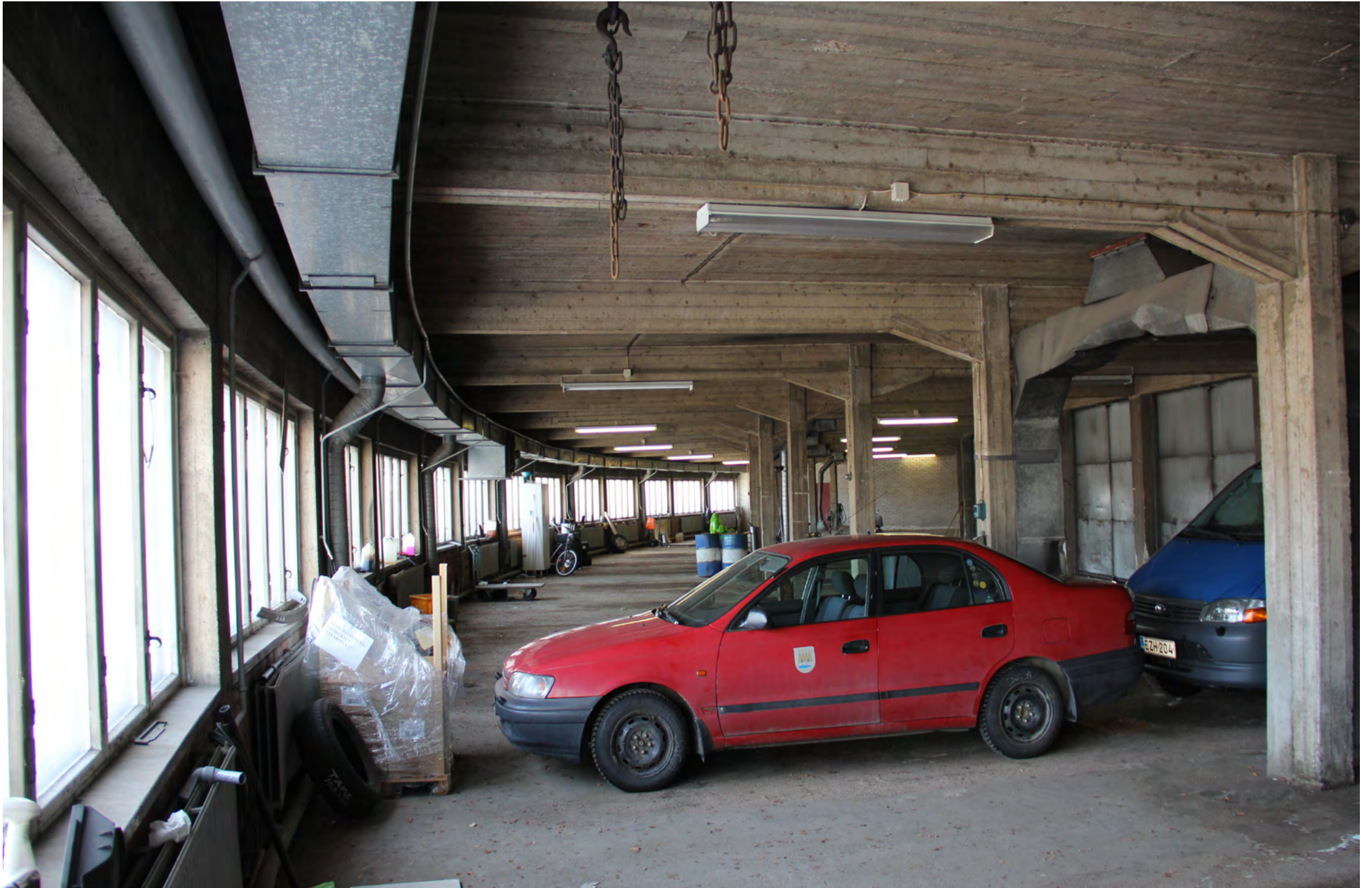
171. Autohalli pohjosipäästä nähtynä.
