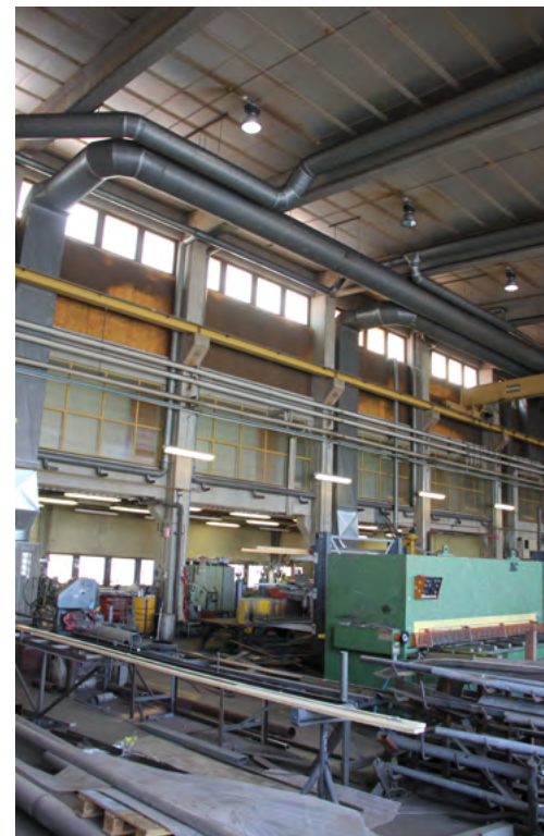
146. Uudempi korjaamohalli. Taustalla toimistoparvi.
