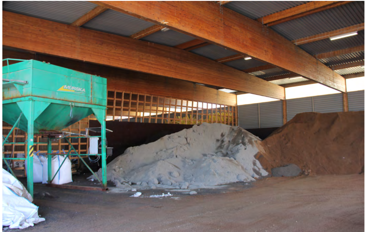
180. Varastohallin järeitä liimapuurakenteita.
