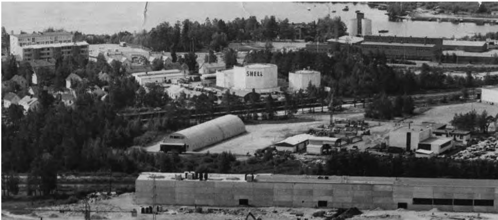
49. Kaupungin varikko pohjoisen suunnalta otetussa ilmakuvassa taustalla. Kuvassa varikon ensimmäinen ja toinen rakennusvaihe ovat toteutuneet. Tontin perällä on vuonna 1963 valmistunut hiekkasiilo.
