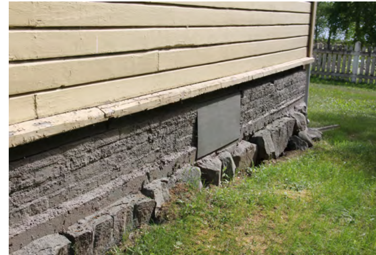
188. Lohkareista tehtyä perustusta on jatkettu muuraamalla.
