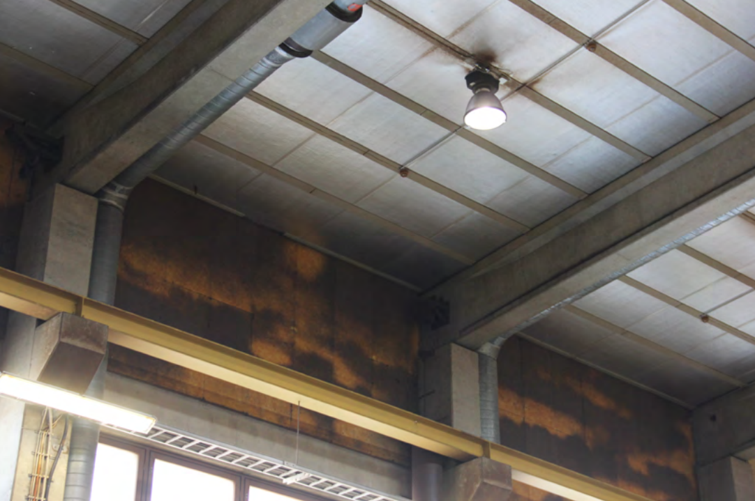
149. Uudemman korjaamohallin järeitä betonisia runkorakenteita.
