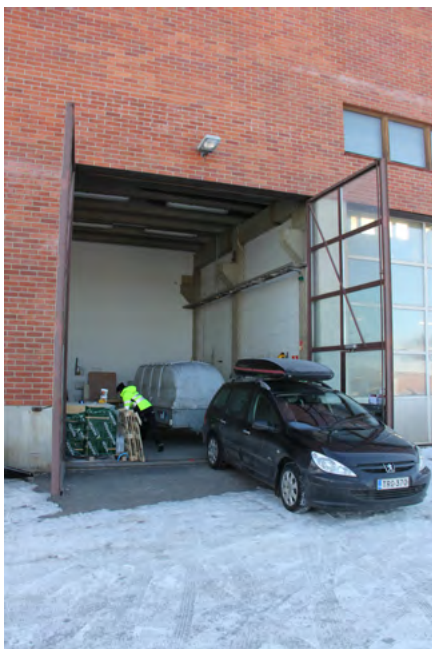
77. Vesihuollon hallin suuri pariovi.
