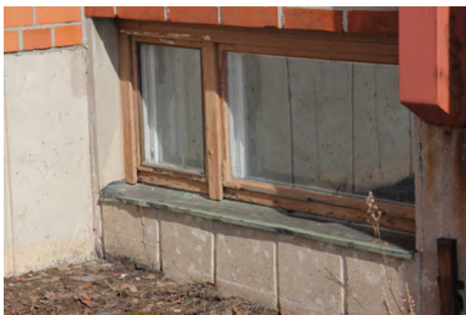
88. Alkuperäisiä puuikkunoita ja niiden kupariset ikkunapellit.
