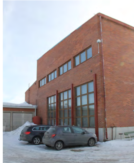
86. Vesihuollon päätyjulkisivun suuret ikkunat.
