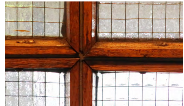
135. Rautalankalasi on kiinnitetty metallirunkoon siroin tammillistoin.
