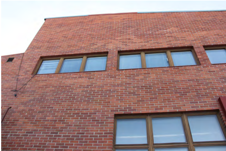
85. Alkuperäiset ikkunat korjaamon katujulkisivulla.
