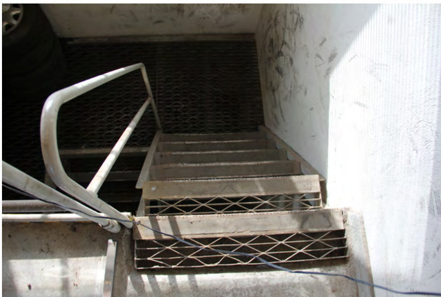
97. Huoltohallista kellariin johtavat alkuperäiset teräsportaat.
