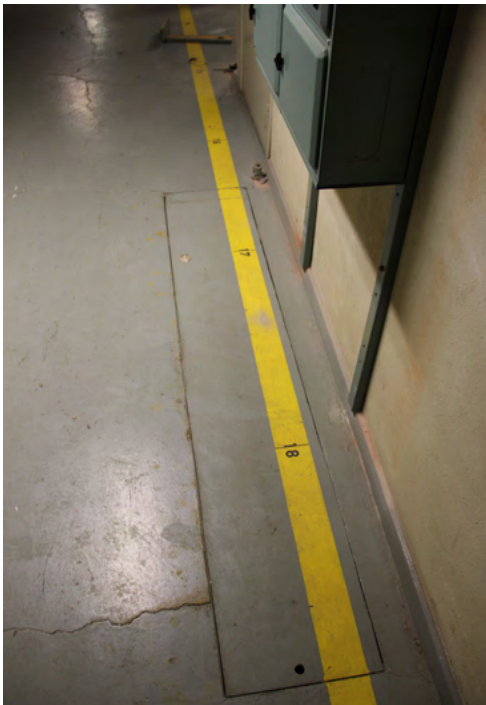
129. Varastopaikkojen numerointia lattiasa.
