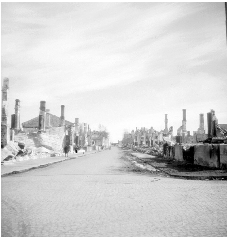
Kuva 6. Pommituksien vaurioita Isokadun ja Kajaaninkadun kulmauksessa v.1945.
