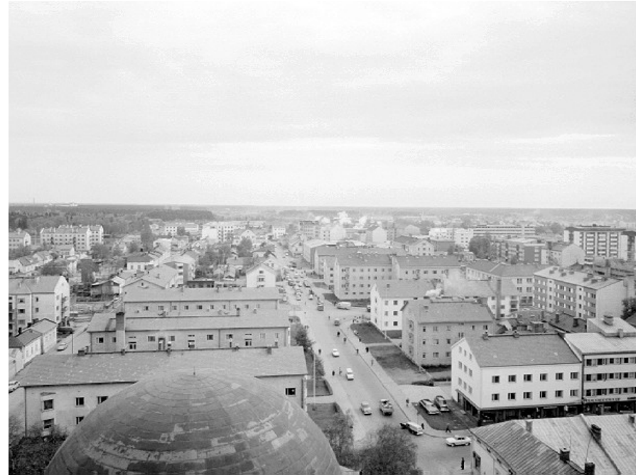
Kuva 7. Näkymä tuomiokirkontornista Kajaaninkatua asemalle päin v.1962.
