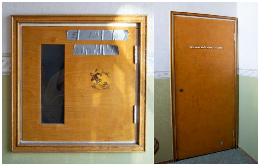
Kuvat 30 ja 31. Säilyneitä rakennusosia porrashuoneessa: pikapalopostin luukku ja ovi.
