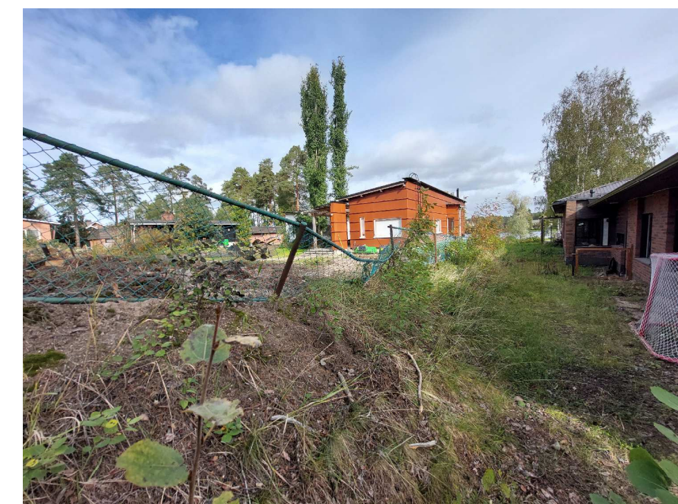
Kuva 7 Huonokuntoinen metalliaita tontin koillisrajalla.
