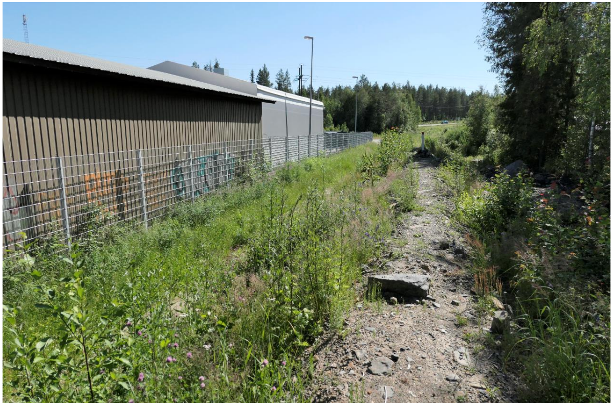
Kuva 19. Sähköaseman vieressä esiintyy joutomaan kasvillisuutta.
