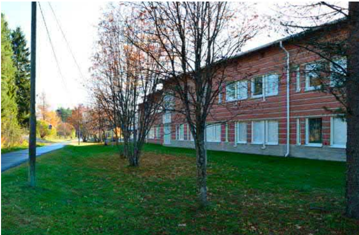
v Julkisivu pohjoiseen. Vasemalla kevyen liikenteen väylä. Pohjoisjulkisivu on rakennuksen selkäpuoli.
