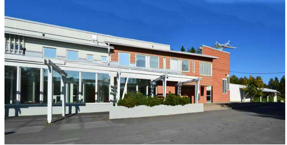
^Julkisivu etelään. Vasemmalta viherhuone, aulatilat, korkea porrashuone leijoineen ja pyöräkatos. Aiemmin betonipintaiset istutuslaatikot on maalattu. Matalalla katolla erottuu kattomateriaalin vaihto konesaumapellistä bitumikermikatteeseen. Seinäpintojen paneloinnit on ennallistettu kattotyön yhteydessä.
