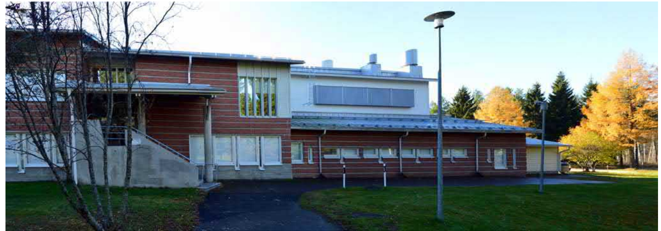
v Julkisivu pohjoiseen. IV-konehuoneen laajennus on tehty 2. kerrokseen. Sen kohdalla panelointi on yksinkertainen. Laajennus on toteutettu huomaamattomasti. Matalan osan peltikatto on alkuperäinen.
