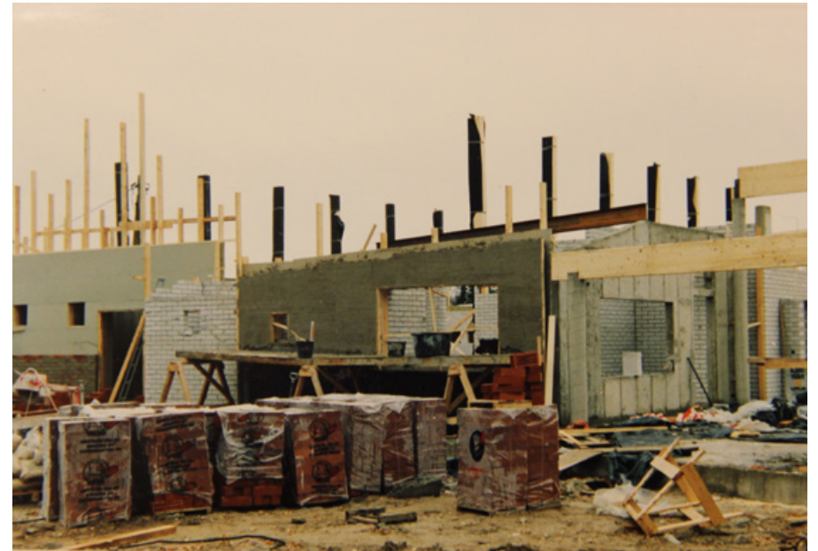
Syksyllä 1990 C-osan monimuotoinen runko nousi puisena, betonisena ja muurattuna. Vasemmalla näkyy käsityösalin runko. Oikealla on sama työvaihe rakennuksen takaa kuvattuna. Kuvan edessä on ruokala ja taustalla liikuntasalin pilaristoa.
