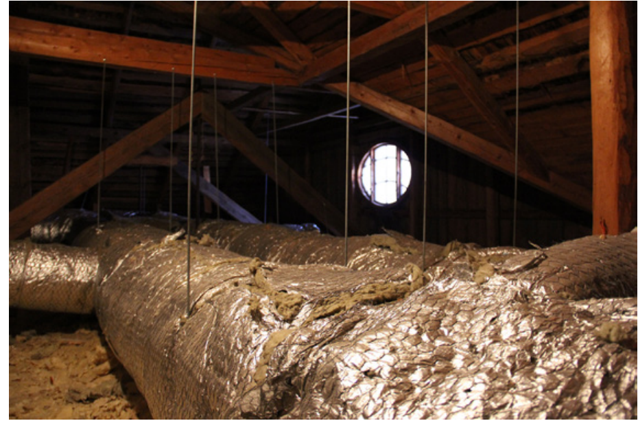
Ullakko on täytetty ilmanvaihtoputkilla. Alkuperäiset "ruotsalaiset kattotuolit" ovat kuitenkin näkyvillä.
