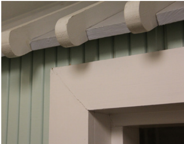
Detailji peruskorjauksessa lisätyn komeron katosta.
