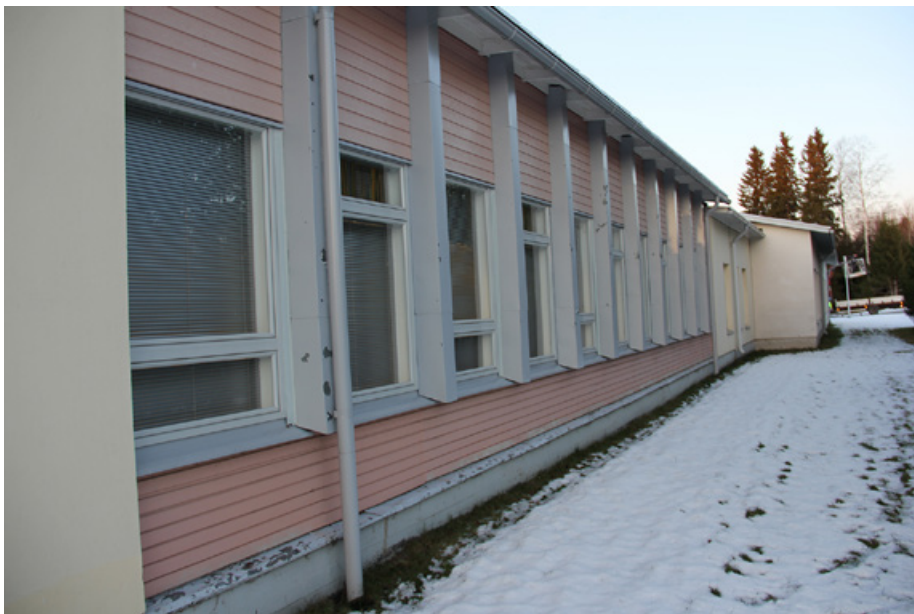
Alkuperäinen julkisivu on rapattu ja maalattu uusilla sävyillä. Räystäät ja sadevesijärjestelmä on lisätty 2007.
