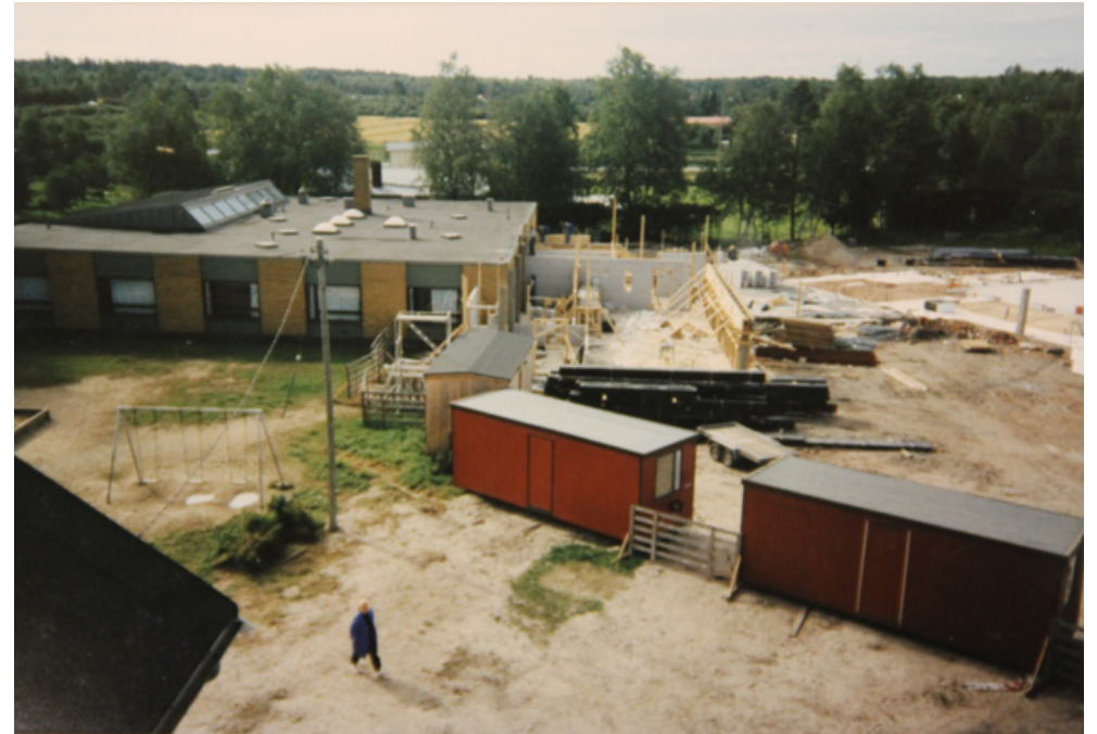
Laajennuksen rakentaminen aloitettiin kesällä 1990. Kuva on otettu puukoulun katolta Hailuodontien suuntaan. KUVA: Salonpään koulun arkisto
