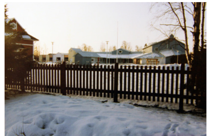
Kuvassa juuri valmistunut laajennus Keskipiirintieltä katsottuna. Vasemmalla näkyy B-osan julkisivuun lisätty valkoinen porttiaihe.
