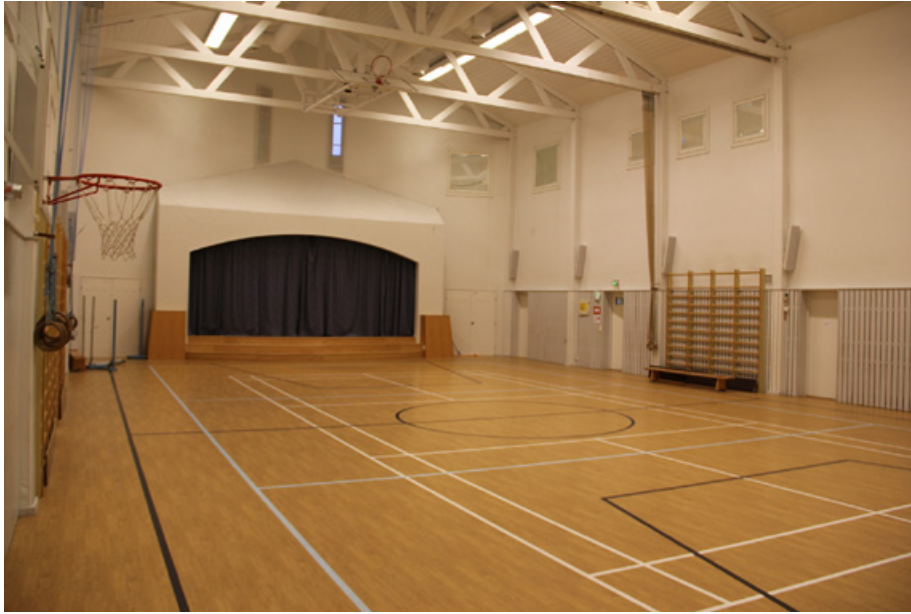
Juhlasalin katto nousee loivasti näyttämöä kohti. Kattotuolit on jätetty näkyviin. Lattiamateriaali on uusittu.
