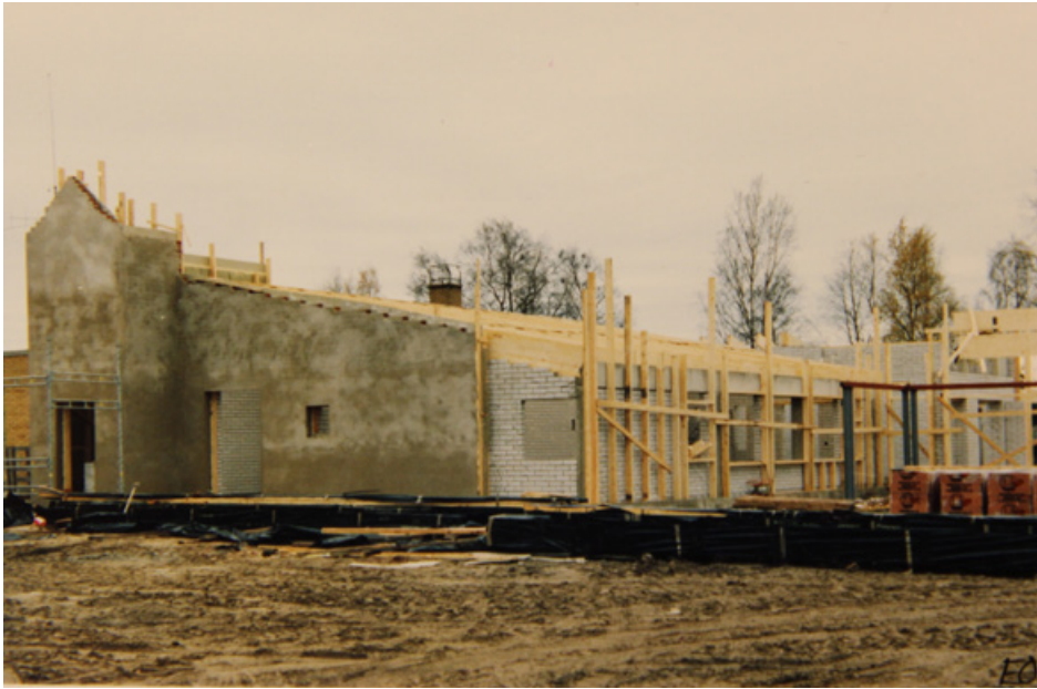
Syksyllä 1990 C-osan monimuotoinen runko nousi puisena, betonisena ja muurattuna. Vasemmalla näkyy käsityösalin runko. Oikealla on sama työvaihe rakennuksen takaa kuvattuna. Kuvan edessä on ruokala ja taustalla liikuntasalin pilaristoa.
