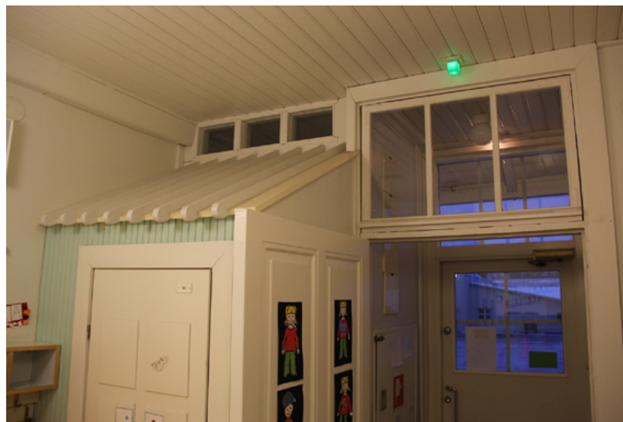
Sisäänkäynneissä on säilynyt alkuperäisiä rakennusosia. Vasemmalla on yksi käytävään lisätyistä wc-komeroista.
