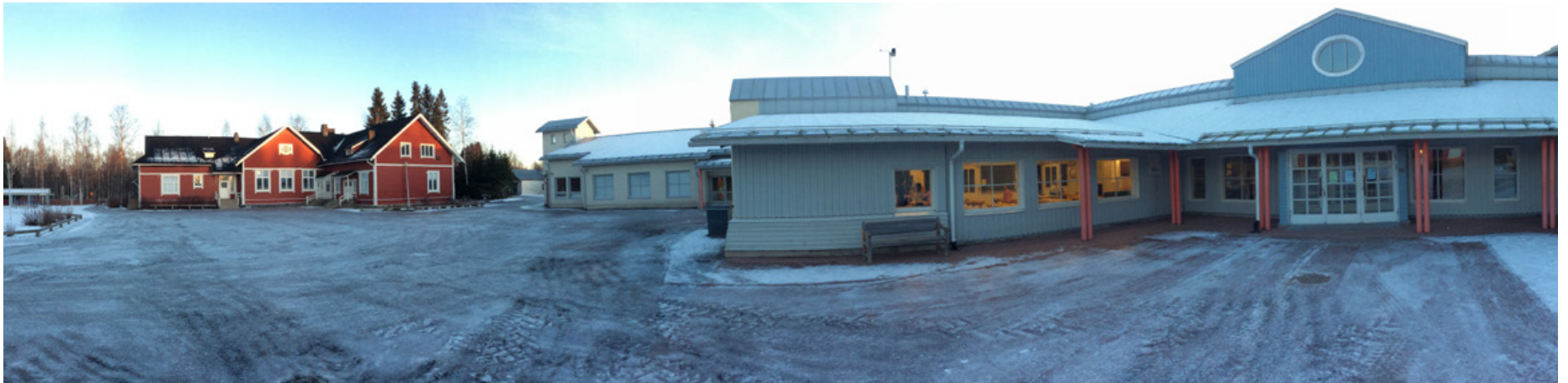
Panoraamakuvasa esiintyvät Salompään koulun kaikki viisi rakennusvaihetta. Taka-alalle jää vuonna 1971 valmistunut moderni B-osa, joka on sulautettu osaksi myöhempiä laajennuksia.
