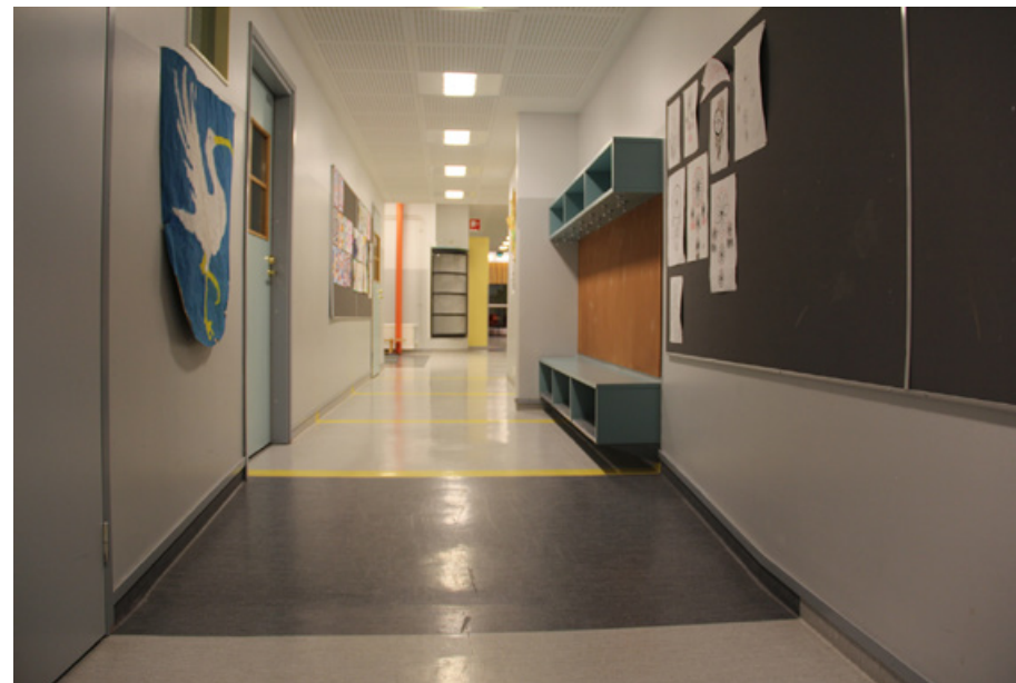
B-osa on perustettu matalalle. Laajennuksiin noustaan loivia rampeja pitkin.
