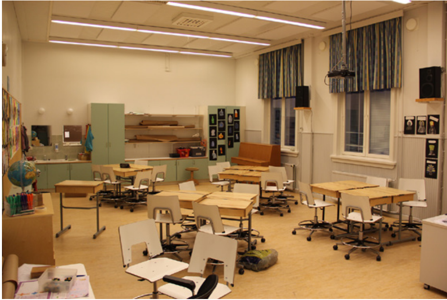
Suurin luokkahuone on korkea ja valoisa tila. Alkuperäinen puukatto on peittynyt akustiikkalevyjen ja tekniikan alle.
