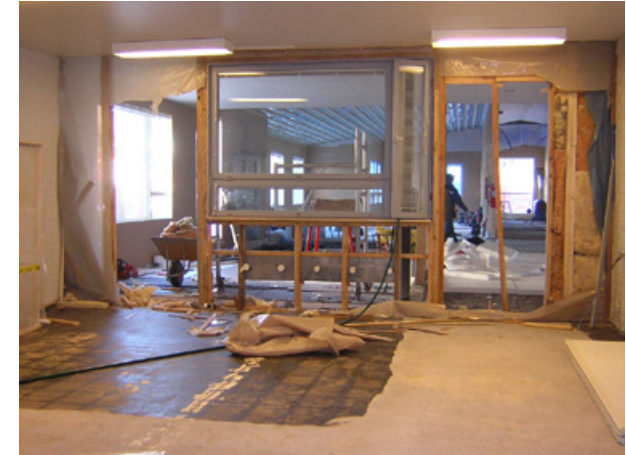
Kuvassa liittymäkohta B-osan suunnasta D-osan käytävään. Keskellä on B-osan alkuperäinen ikkunaruuhi. Lattian korkoeroa ei ole vielä luiskattu.
