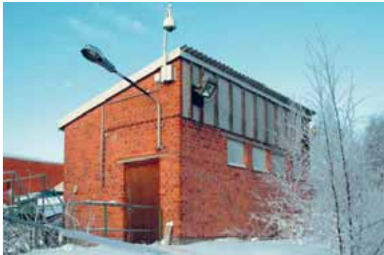
Alvar Aallon vuonna 1952 suunnittelema palautuspumppuasema Laanilan tehdasalueella. (Kuva: Arkkitehtitoimisto Jorma Teppo Oy)
