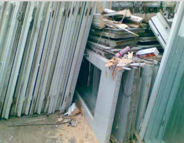
Modernin arkkitehtuurin arvot ovat myös rakennusosissa ja pelkistetyissä detaljeissa, joita helposti taitamattomalla korjauksella tuhoetaan. (Kuva: Helena Hirviniemi)
