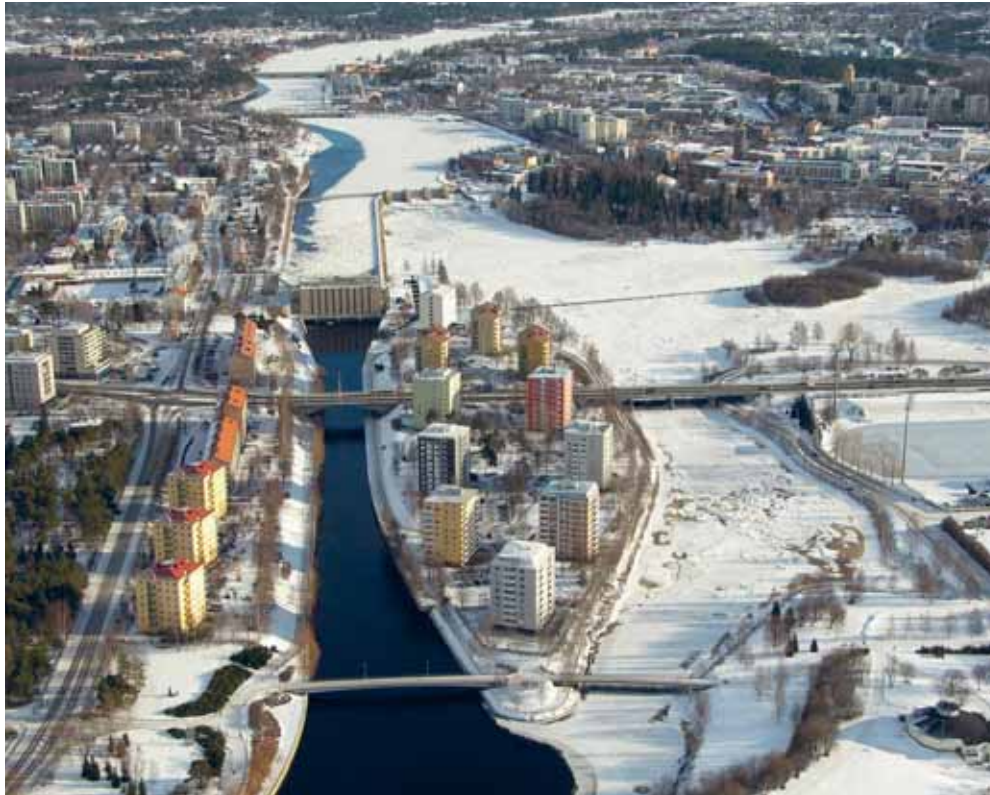
Toivoniemestä tuli saari, kun voimalaitoksen laskukanava kaivettiin erottamaan se Tuirasta. Voimalaitoksen rakentamisen yhteydessä syntyneitä maamassoja käytettiin saaren laajentamiseen. (Kuva: Oulun kaupungin konsernipalveluiden kuva-arkisto)
