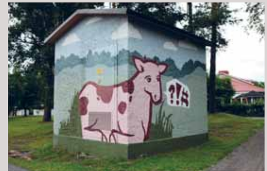
Arkiympäristön yksityiskohtia. Oulussa sähkömuuntamot piristävät katumaisemaa. (Kuvat: Pauliina Rautio)
