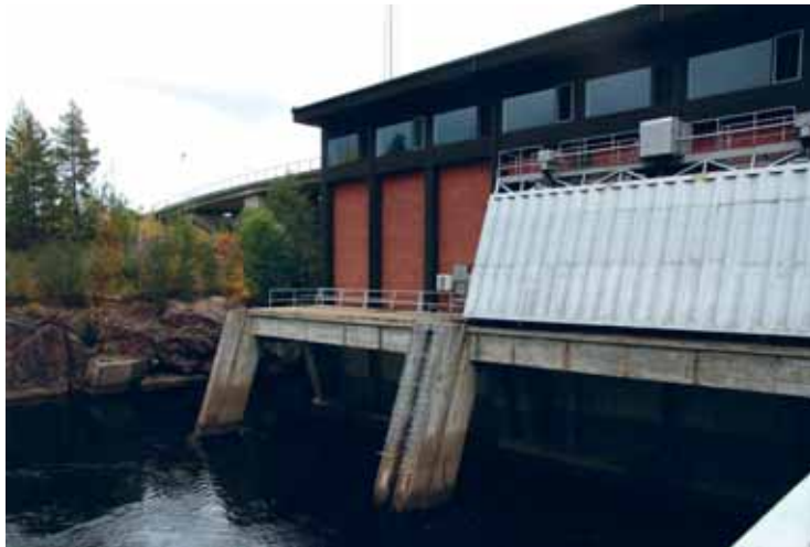
lijoen voimalaitokset muuttivat radikaalisti li-jokivarren maisemaa. Yli-lin alueelle valmistui neljä voimalaitosta 1960-luvulla. Kuvassa oleva Haapakosken voimalaitos valmistui 1963.
