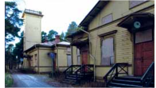
Vaikka moni Tuiranpuiston rakennuksista on kunnostettu ja käytössä, osa rakennuksista odottaa vielä korjausta.
