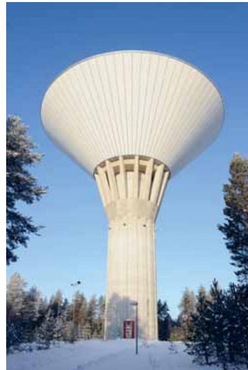
Puolivälinkankaalla erityisiä arvoja on maamerkinä toimivalta vesitorni, joka näkyy kauas Oulun siluettissa. (Kuva: Oulun konsernipalveluiden kuva-arkisto)
