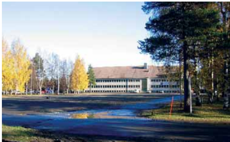
Hiukkavaaran kasarmien rakentamispäätös tehtiin vuonna 1952. Alueen asemakaavan laati puolustusministeriössä arkkitehti Vilho Noko, ja kasarmi rakentui pääosin vuosina 1952-1971. Nykyisin kasarmi toiminnot ovat väistyneet ja Hiukkavaaraan suunnitellaan uutta asuinalueita. (Kuva: Saira Palviainen)
