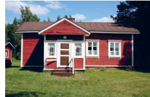
1920-luvun alussa valmistuneen Hietalan rakentaja työskenteli Varjakan sahalla. (Kuva: Anneli Salmela)
