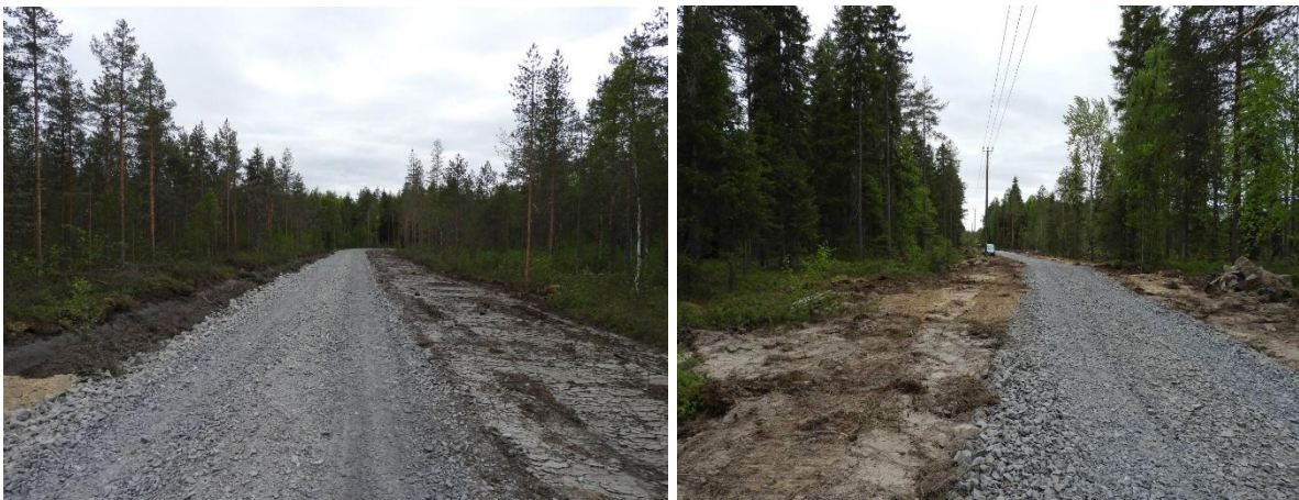
Kuva 15. Uutta tierakennetta Myllykorven ja Leppisuon välisellä alueella.
