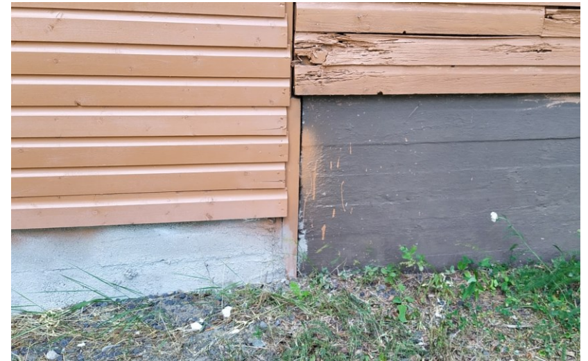
Kuva 36. Uudemman rakennusosan ja autotallin (vasemmalla) maan- varainen alapohja.
