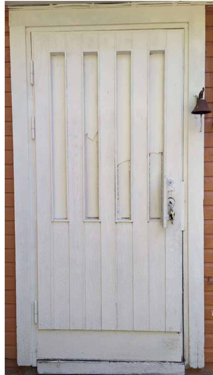
Kuva 40. Rakennuksen ulko-ovi sijaitsee laajennusosassa.
