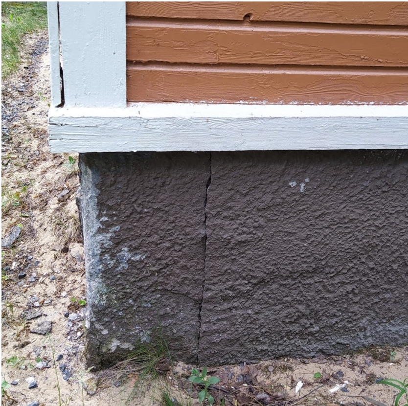
Kuva 35. Vanhemman rakennusosan pilarianturaperustus.
