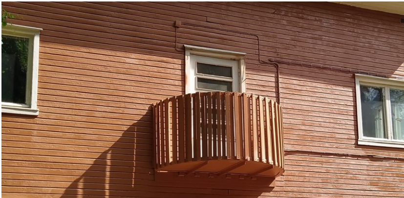
Kuva 37. Rakennuksen uusittu parveke.
