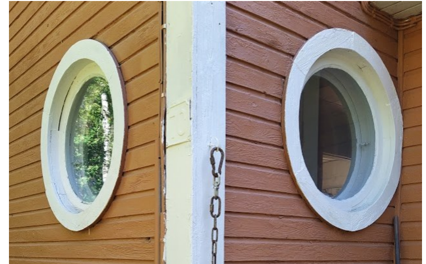
Kuva 38. Rakennuksen alkuperäisen osan pyöreät ikkunat.
