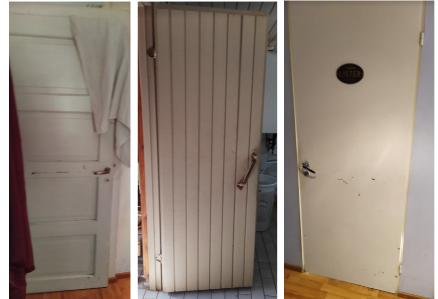
Kuvat 54, 55 ja 56. Rakennuksen väliovia.
