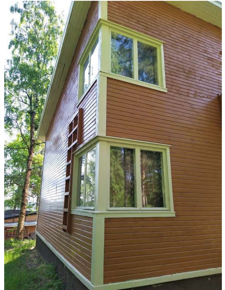
Kuva 13. Rakennuksen alkuperäisen osan kulmaikkunat.
