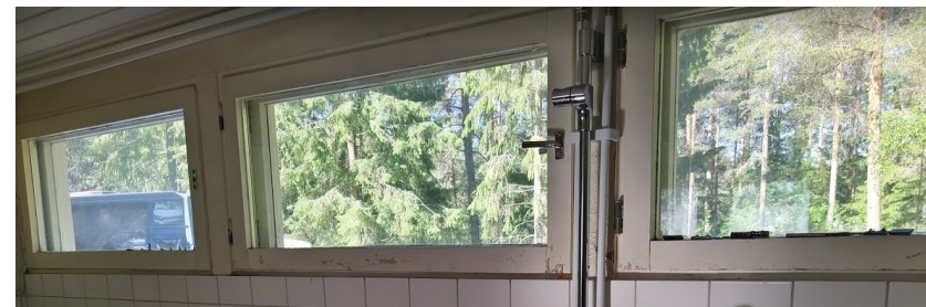
Kuva 59. Laajennusosassa peseytymistilan ikkunat.
