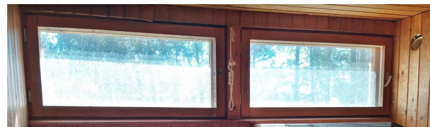
Kuva 60. Laajennusosassa saunan ikkunat.
