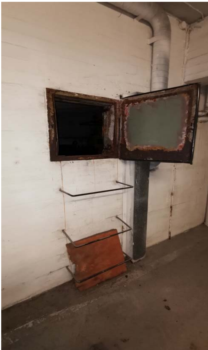
Kuva 2. Käyntiluukku öljysäiliöhuoneeseen autohallin puolelta
