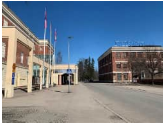
Kuva 1. Näkymä taidemuseosta Kasarmintien varrella. Pylväikkö ulottuu lähes ajoradan reunaan ja ihmiset kulkevat usein katoksen alta.
