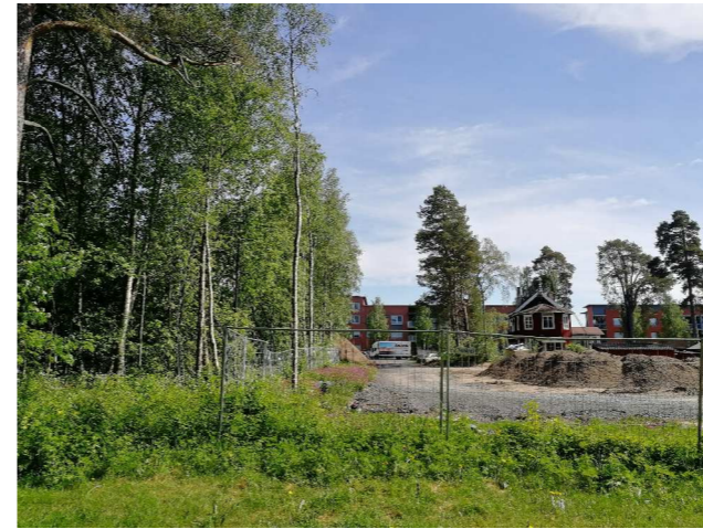
Kuva 3 Työmaa-alue luoteisreunalta kuvattuna. Taustalla huvila ja huvilapihapiiriin männnyt. Kasvillisuus on poistettu työmaa-alueelta.
