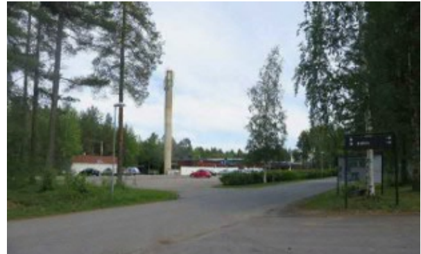
Kuva 41. Huoltorakennuksen piippu erottuu selvästi heti piha-alueelle saavuttaessa.
