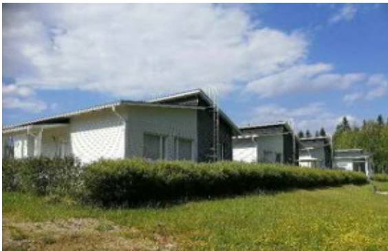
Kuva 54. Uutta rakentamista pohjoisosassa.
