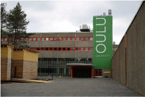
Kuva 54. Oulun yliopiston uusi pääsisäänkäynti.
