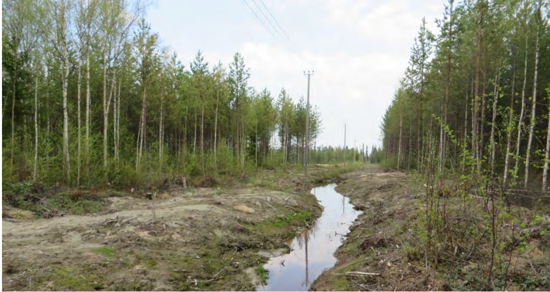
Kuva 15. Uusi voimajohto, oja ja viemäriinjan kaivualue jakavat metsäalueen kahteen osaan.
