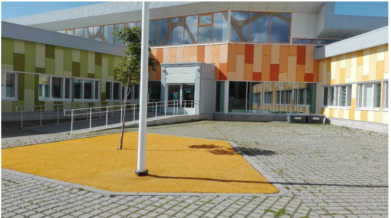
Kuva 10, Pohjois-Ritaharjun koulun pääsisäänkäynti
