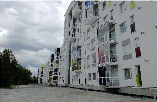
Kuva 59. Väri-ilottelua uudessa rakentamisessa.
