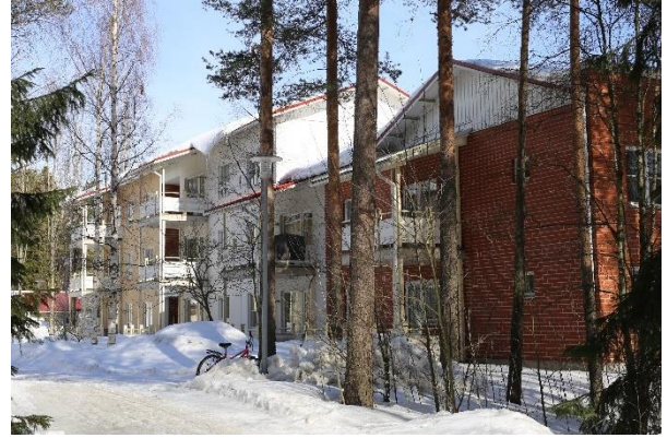
Kuva 61. Asuinrakennuksia Kaitoväylän varrella.
