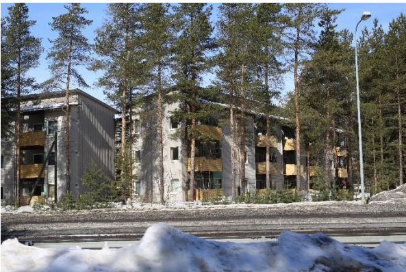
Kuva 60. Puurakentamista Kaijonharjun keskuk- sessä.
