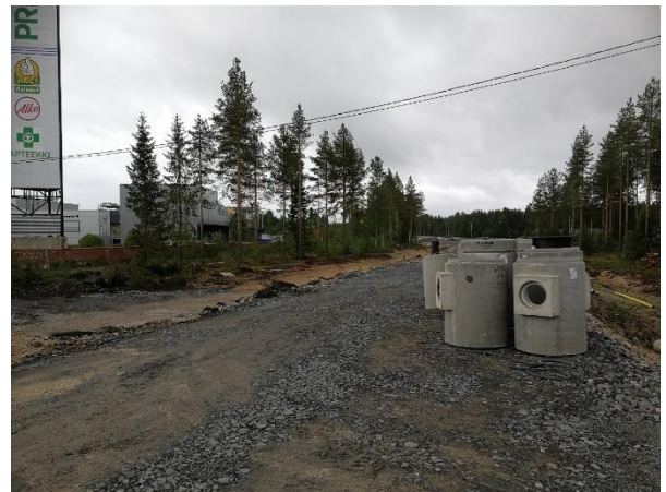
Kuva 19. Tietyömaata moottoritien ja Prismän välisellä alueella.
