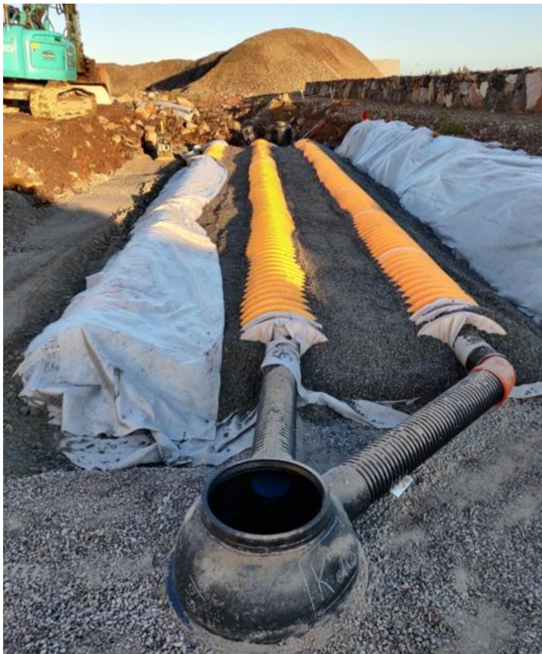
Kuva 7 Hulevesitunneli. Kuva: Viacon Oy.
