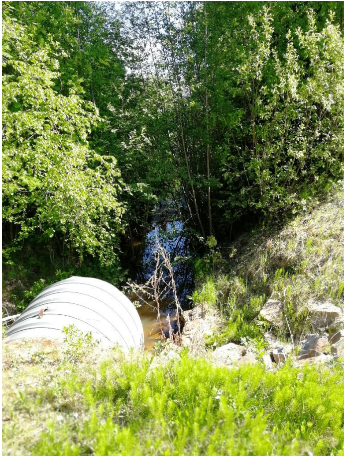
Kuva 6 Virtaoja, Limingantien länsipuolella.
