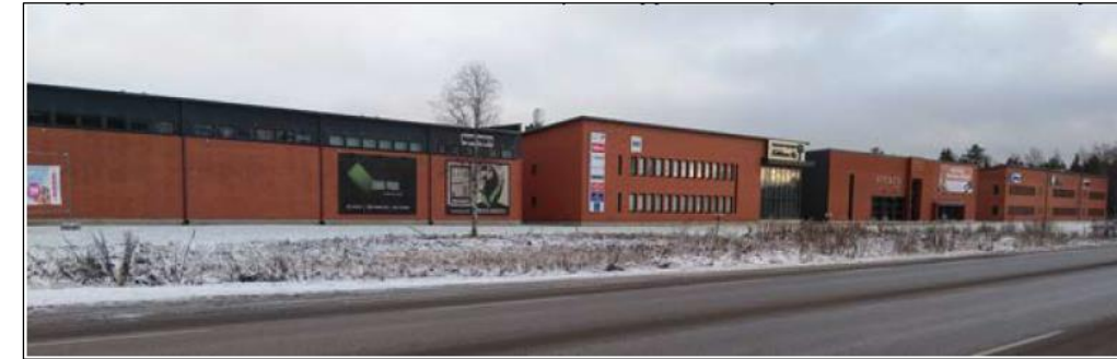
Kuva 41. Kaupunkikuvallisesti hyvä esimerkki onnistuneesta toteutuksesta Vaalantien varressa.
