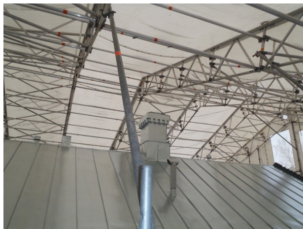
Sääsuojausta arvorakennuksen vesikatokorjauksessa
