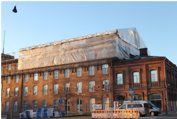
Sääsuojausta vesikatto- ja julkisivukorjauksissa
