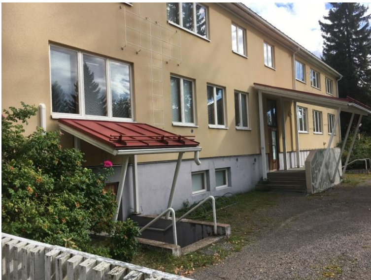
Kuva 8. Mahdollisena päiväpiilona tarkasteltu Uiton talo. Lepakkohavainto pihalla vuonna 2018, mutta ei sen jälkeen. Nykyisin talossa toimii Tuiran kuntoutuskoti.
