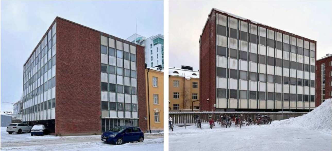
Kuva 3 Vasemmanpuoleisessa kuvassa on esitetty Kauppurienkatu 33:n julkisivu Kauppurienkadulle päin ja oikealla julkisivu luoteeseen. Valokuvat ovat laaditusta rakennushistoriaselvityksestä © Kallinen, 2022.
