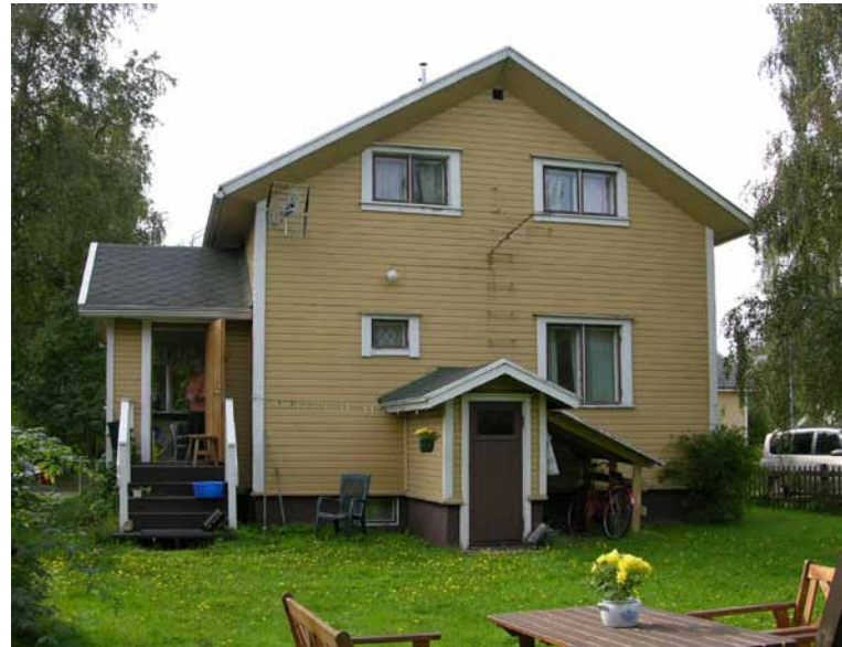
Kuva 169. Alkuperäispiirustusten mukainen ikkunajako on säilynyt.
