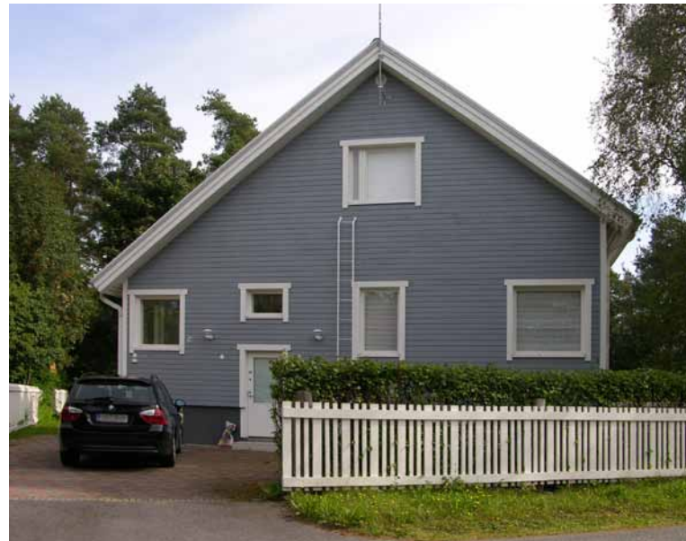
Kuva 175. Talotyyppi on yksi Karjasillan suurimpia. Rakennuksen hahmo on säilynyt, mutta ikkunajako on muuttunut.
