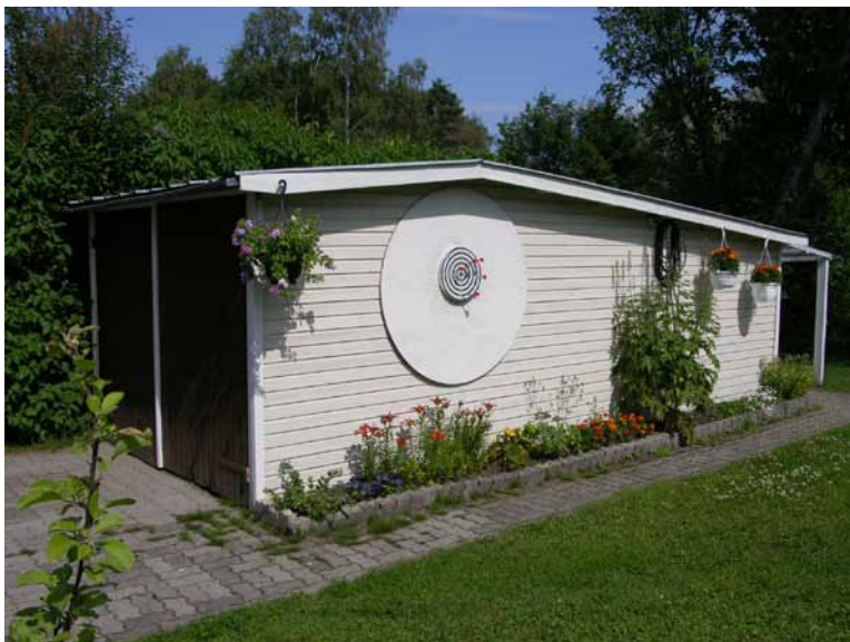
Kuva 235. Autotalli tyyppi 1, jossa harja on rakennuksen pitkällä sivulla.
