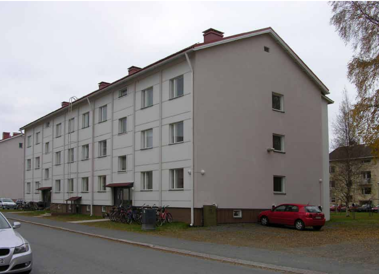
Kuva 222. Rakennus aikaansa edellä: rakennuksessa on alkuunkin ollut levyverhottu katujulkisivu, mikä ei ole jälleerakennuskaudelle tyypillistä. Rakennuksen on suunnitellut August Rönkönharju.
