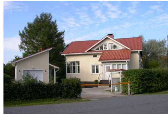
Kuva 125. Laajennusten myötä rakennuksen hahmo on muuttanut.
