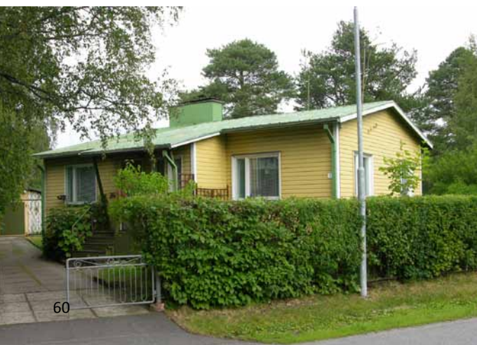
Kuva 110. Ruotsalaistalolle tyypillinen laajennus 50-luvulta: alkuperäinen avokuisti on muutettu huoneeksi ja talon keskelle on rakennettu uusi avokuisti.
