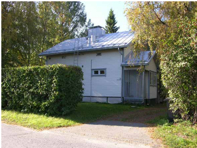
Kuva 189. Rakennusaika ja talotyyppi ovat tunnistettavissa. Rakennuksessa on säilynyt myös kellarin sisäänkäynnille tyyppillinen rimoitus.
