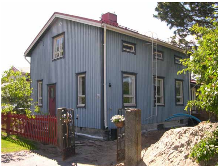
Kuvat 140-141. Paalasen talotyypissä laajennukset sijoittuvat yleensä pihan puolelle talon pätyyn. Kuvan rakennuksen laajennus on 1950-luvulta.
