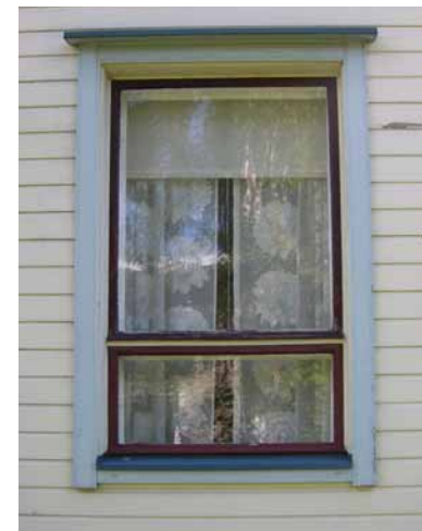
Kuvat 7-9. Alkuperäisiä ikkunoita ja ovi.
