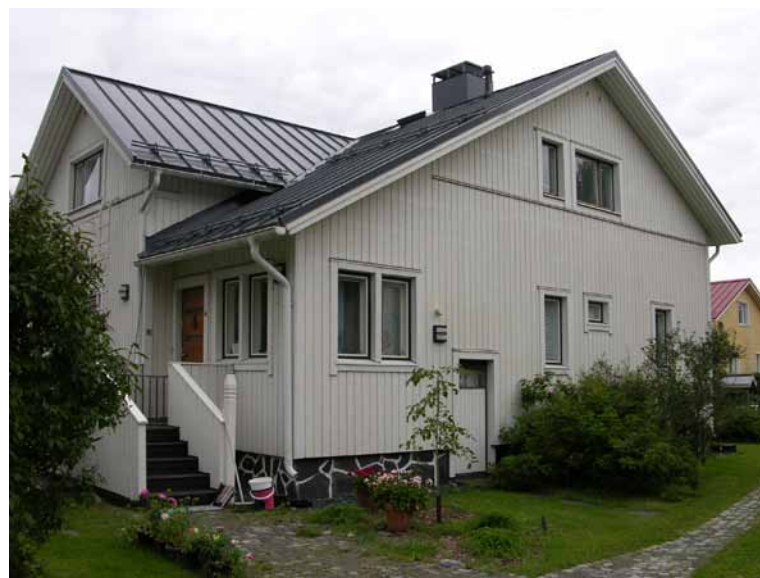
Kuva 184. Iso laajennus, joka muuttaa rakennuksen hahmoa.
