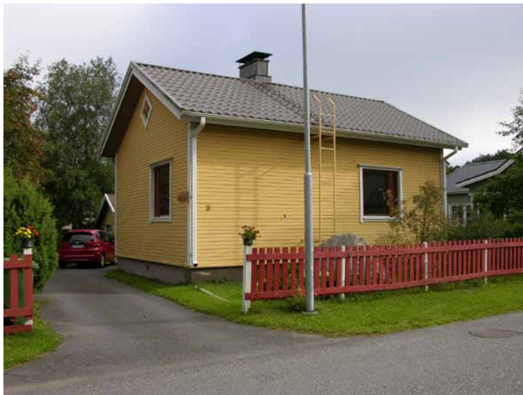
Kuva 114. Asevelitalon hahmo on kadulle päin säilynyt. Ikkunat on vaihdettu, mutta ullakon vinoneliöikkuna on säilynyt.
