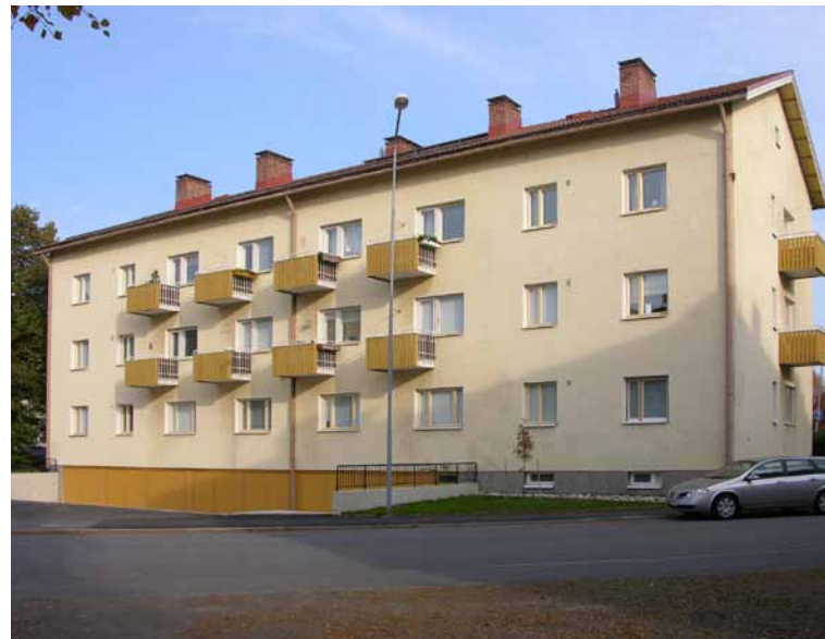
Kuva 215. Tyypillinen jälleenrakennuskauden kerrostalo: vaaleankeltainen rappaus, pienet ulokeparvekkeet ja kellarikerroksen autotallit. Rakennus on Kulutusosuuskuntien liiton asunto-osaston suunnittelema.
