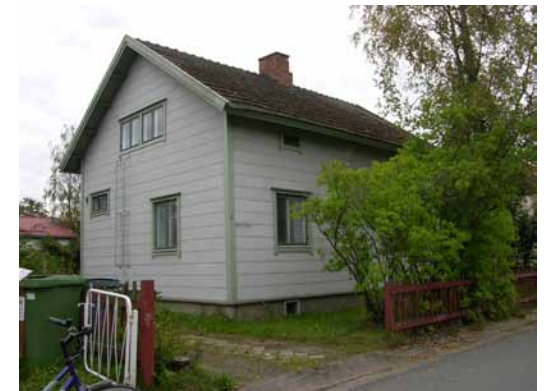
Kuva 128. Talotyyppi on helposti tunnistettavissa, vaikka julkisivu on pinnoitettu asbestisementtilevyillä.
