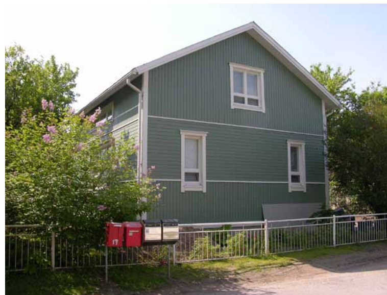
Kuva 143. Rakennuksen hahmo on säilynyt, mutta kenttälaudoitus ei edusta jälleenrakennuskauden tyyliä.
