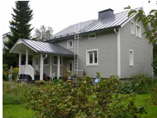
Kuva 177. Kuistia on laajennettu.
