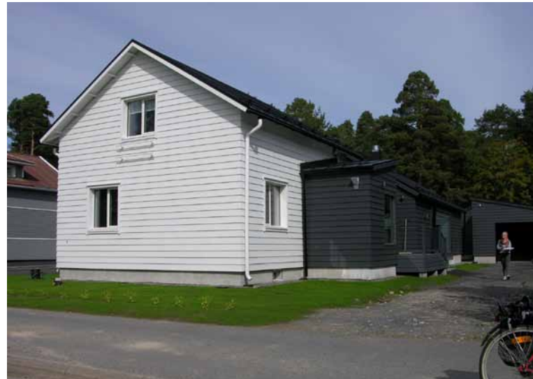
Kuva 170. Rakennuksen verhous on vaihdettu entistä leveämpään paneeliin ja taloa laajennettu moderneilla siivellä ja kuistilla.
