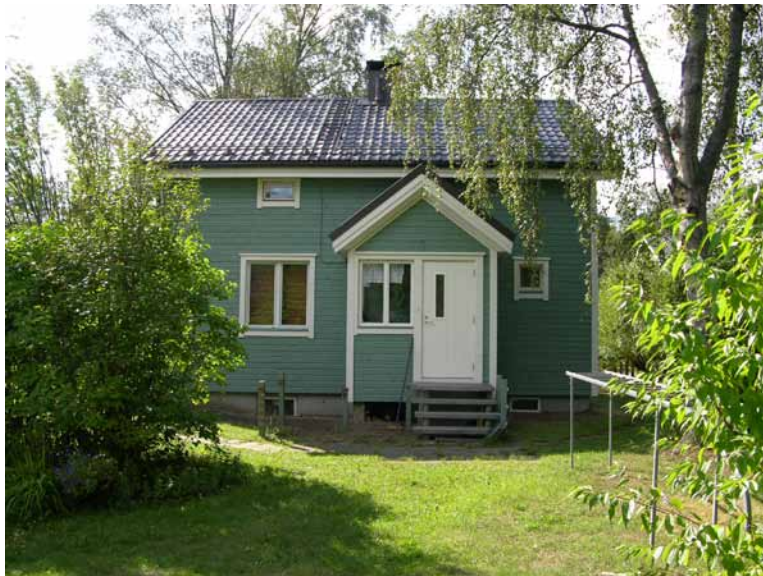
Kuva 129. Rakennuksen hahmo on säilynyt lähes alkuperäispiirustusten mukaisena. Kuisti on rakennettu umpinaiseksi ja pihajulkisivussa on uusi ikkuna.
