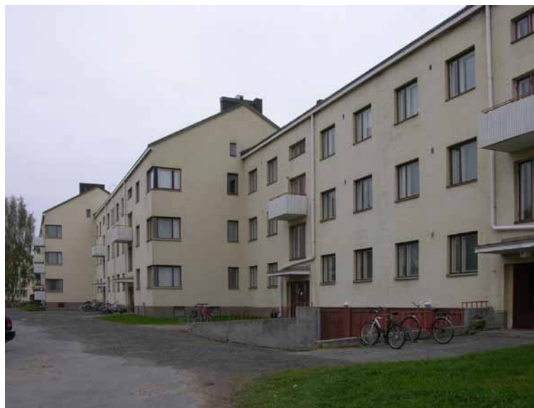
Kuva 220. Ketokadun polveileva kerrostalo. Rakennus muodostuu kolmesta kahden porrashuoneen lamellista. Rakennuksen on suunnitellut rakennusmestari August Rönköharju.
