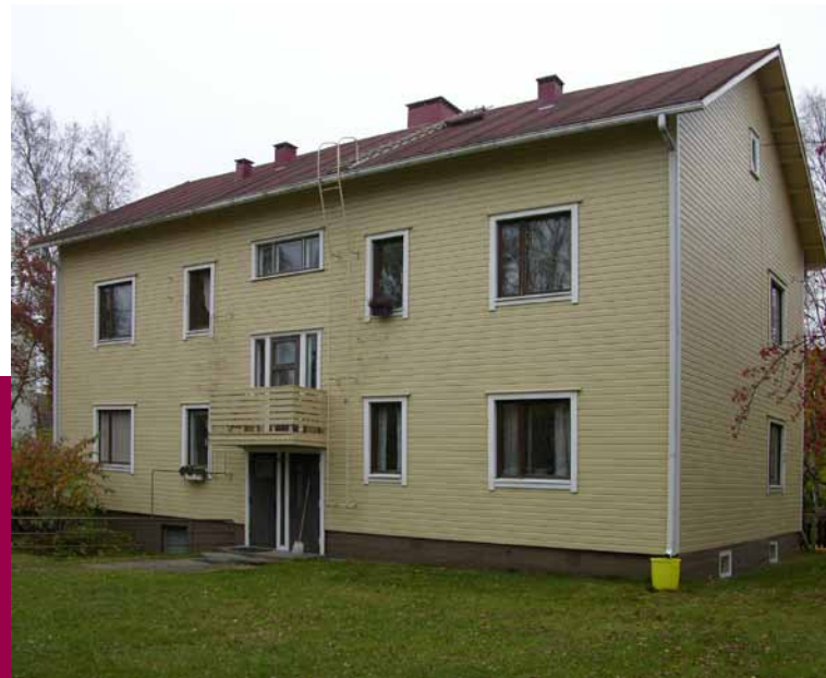
Kuva 206. Pienimmissä puukerrostaloissa on vain yksi porrashuone. Rakennuksen hahmo on säilynyt, mutta tummat ikkunanpuitteet eivät edusta jälleenrakennuskauden tyyliä. Rakennuksen on suunnitellut rakennusmestari August Rönköharju.
