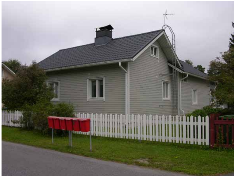
Kuva 134. Päärakennus on säilynyt yksikerroksisena, laajennus on tehty siipeen pihan puolelle.
