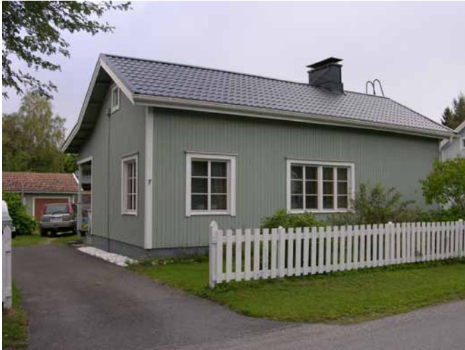
Kuva 116. Asevelitalon suunnitteluperiaatteisiin kuului laajennettavuus: ensin rakennettiin vain kaikkein välttämättömin, aikojen saatossa rakennusta saattoi laajentaa.
