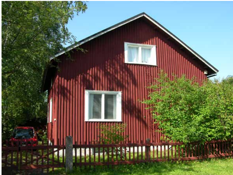
Kuva 159. Jälleenrakennuskauden ilme on säilynyt: punamullan värinen julkisivu on verhottu pystyrimalaudoituksella. Ikkunoiden vuorilaudat ovat talotyyppin mukaisesti sivuilta leveät.
