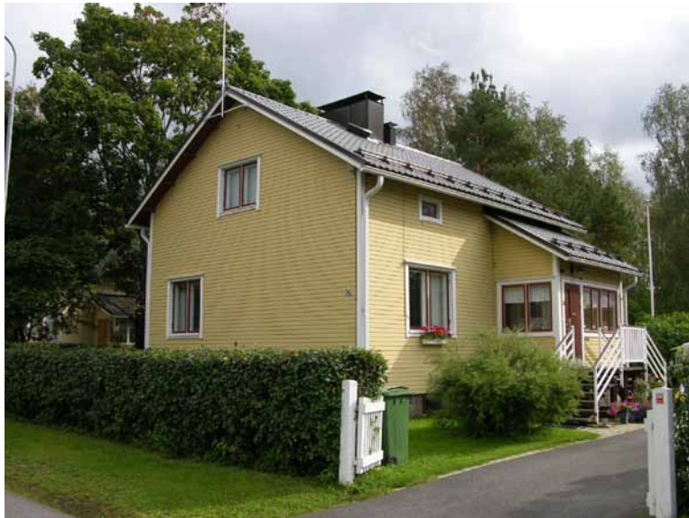
Kuva 168. Rakennuksessa on ensimmäisten piirustusten mukainen pulpettikattoinen kuisti.
