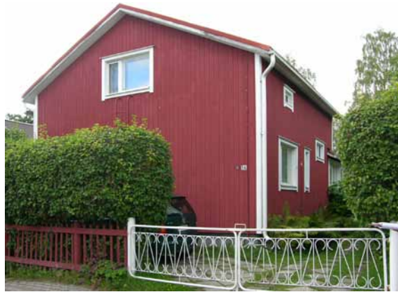
Kuva 120. 1950-luvun laajennus on muuttanut rakennuksen hahmoa, mutta jälleerakennuskauden tyyli on säilynyt.
