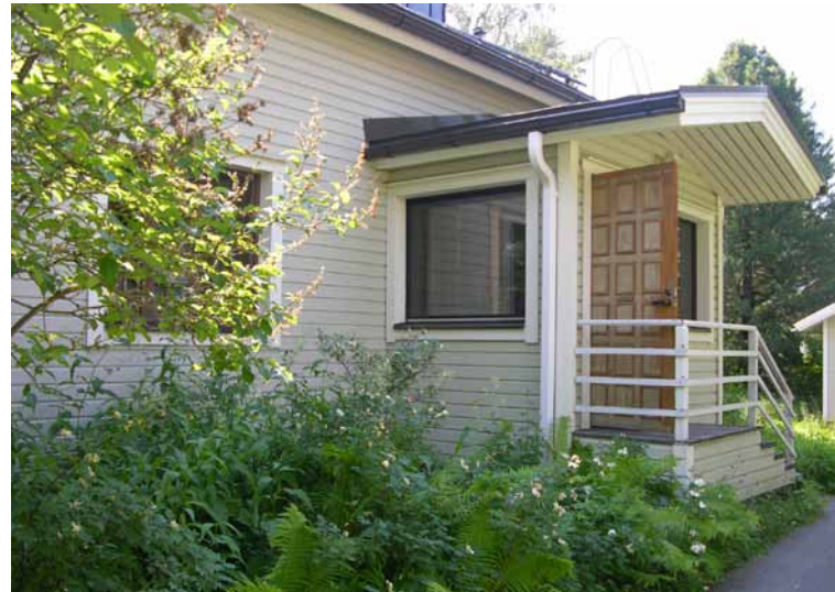
Kuva 112. Ruotsalaistalojen tavallinen kuistilaajennus 1980-luvulta. Portaiden päällä oleva katos "leijuu" ilman nurkkapilareita.
