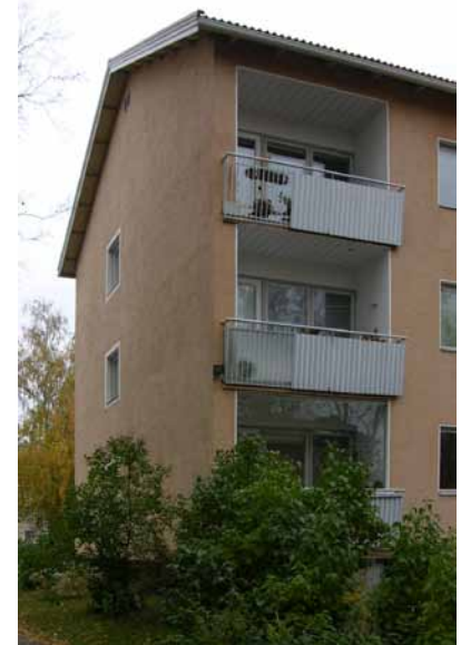
Kuvat 217-218. Ulkoneua ja sisäänvedetty parveketyyppi.
