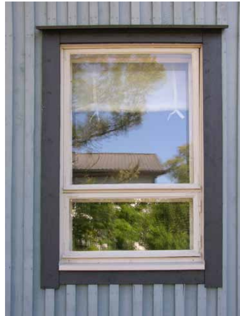
Kuvat 262-263. Paalasan talotyypin ikkunamalli: vasemmalla alkuperäinen ja oikealla puitejako säilyttäneen uusittu ikkuna.
