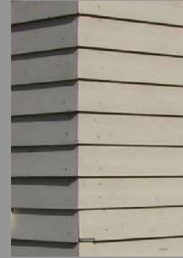
Kuvat 14-15. Lapin rakennus Oy:n talotyypissä on alkuaan ollut vino-vuorilaudoitus ilman nurkkalautoja. Myös muutamia terastirapattuja taloja löytyy Karjasillalta.
