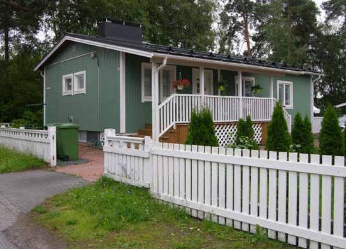
Kuva 108. Iso laajennus: taloa on pidennetty, vanha avokuisti on muutettu lämpimäksi tilaksi ja eteen on tehty uusi suuri avokuisti.
