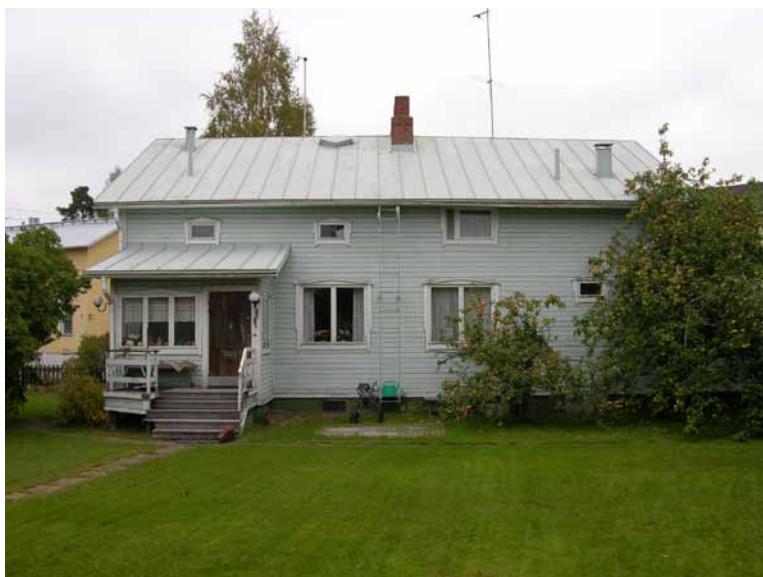
Kuva 172. Talotyyppi on hyvin tunnistettavissa. Ainoastaan koristeelliset vuorilaudat ja ullakon yksi suurennettu ikkuna edustavat myöhempää aikaa.
