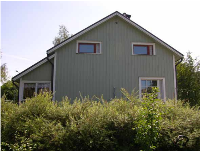
Kuva 167. Rakennuksen ikkunoiden koko ja sijainti ovat säilyneet, mutta ikkunajako on muuttunut. Alkuaan talotyyppissä on ollut keskeltä pystyjaettuja kaksipuitteisia ikkunoita.
