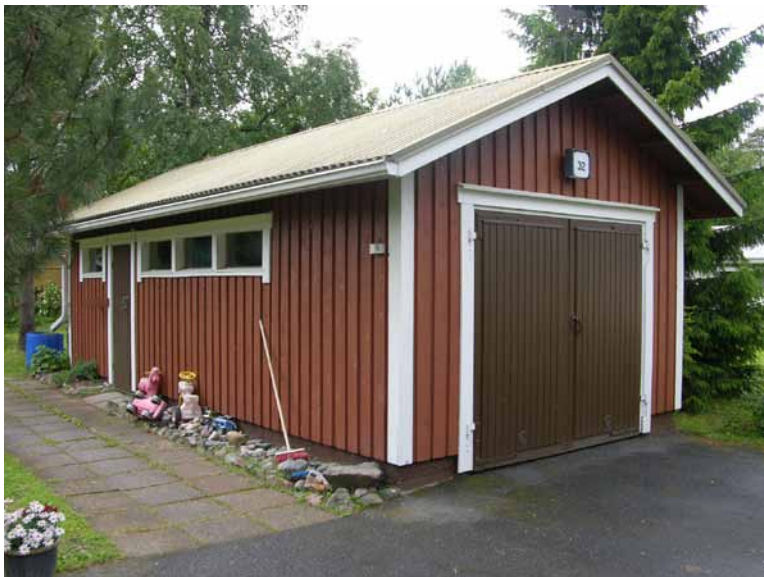
Kuva 236. Autotalli ja varasto, tyyppi E 1980-luvulta.
