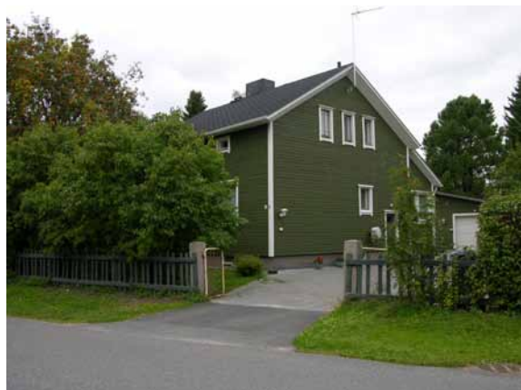
Kuva 179 (vas). Rakennuksen hahmo on säilynyt. Kenttälaudoitus julkisivussa ei edusta jälleenrakennuskauden tyyliä.
