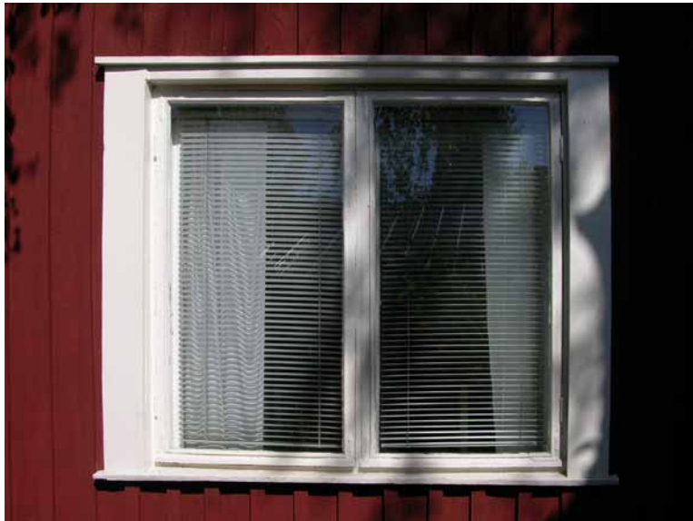
Kuva 261. Alkuperäinen kaksijakoinen sisään-ulos -aukeava ikkuna.
