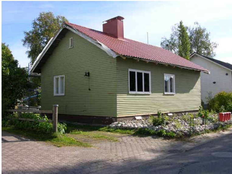
Kuva 151. Rakennuksen hahmo, ikkunat ja verhous ovat säilyneet alkuperäispiirustusten mukaisena. Talotyypissä ei ole alkuaan ollut nurkkalautoja.
