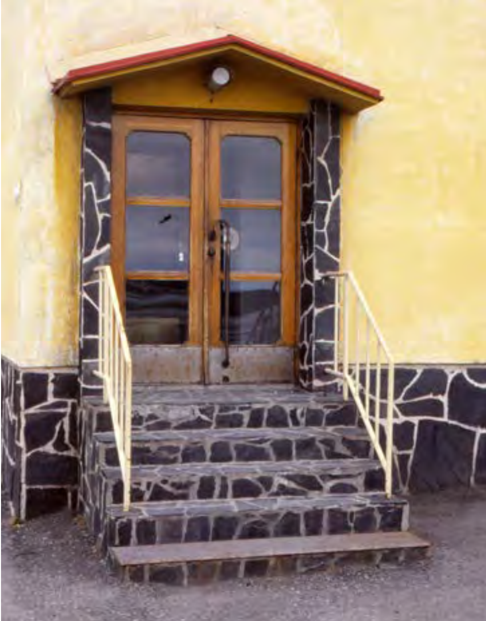
53. Juhlasaliivin sisäänkäynti. Peruskorjauksen yhteydessä ovi korjattiin, mutta se päädyttiin uusimaan teräsprofiilirakenteiseksi vuonna 1996.
