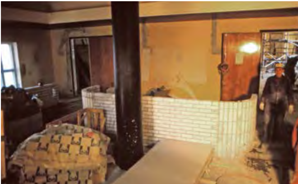
50. Juhlasaliin lämpöön toteutettiin peruskorjauksessa uusia kaidarakenteita kahi-tiilestä, jotka vii-meisteltiin ylitasoittamalla valkoiseksi.
