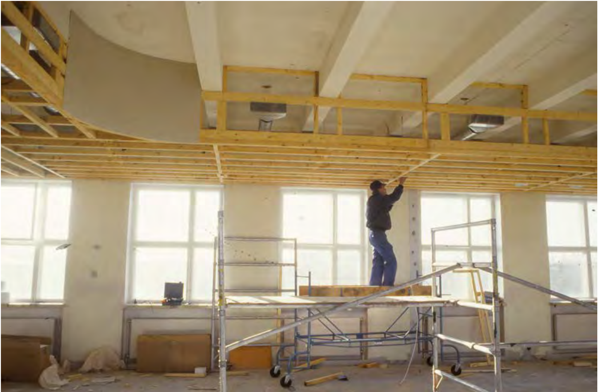
56. Sisätiloihin toteutetaan kipsilevystä alaslaskukattoja.
