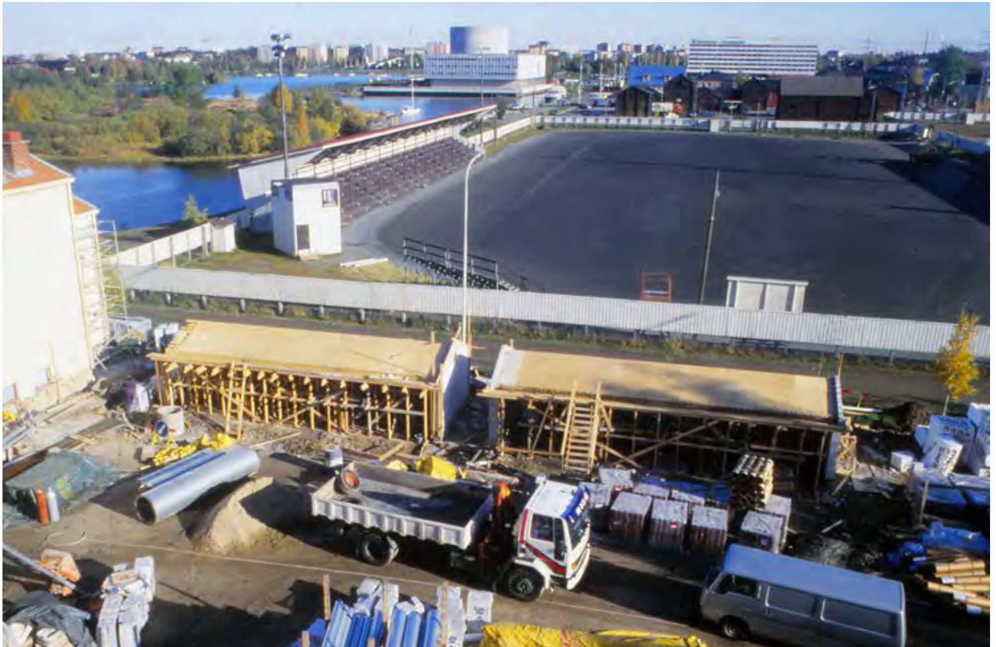
47. Koulun piha-alue myllerryksessä kesällä 1986. Koulun vieressä oli vielä tuolloin pesäpallostadion katsomorakennelmineen.
