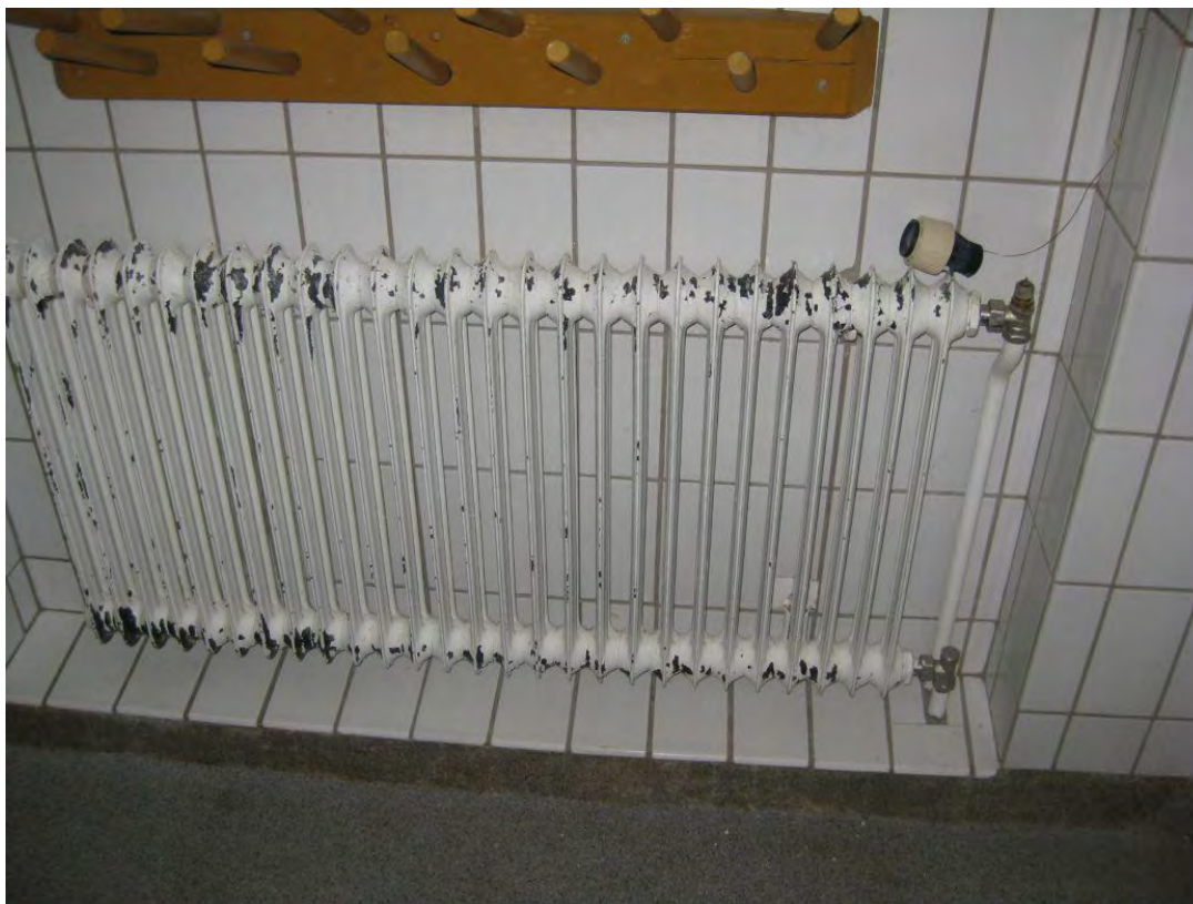
kuva 1: keittiön valurautainen ripapatteri.
