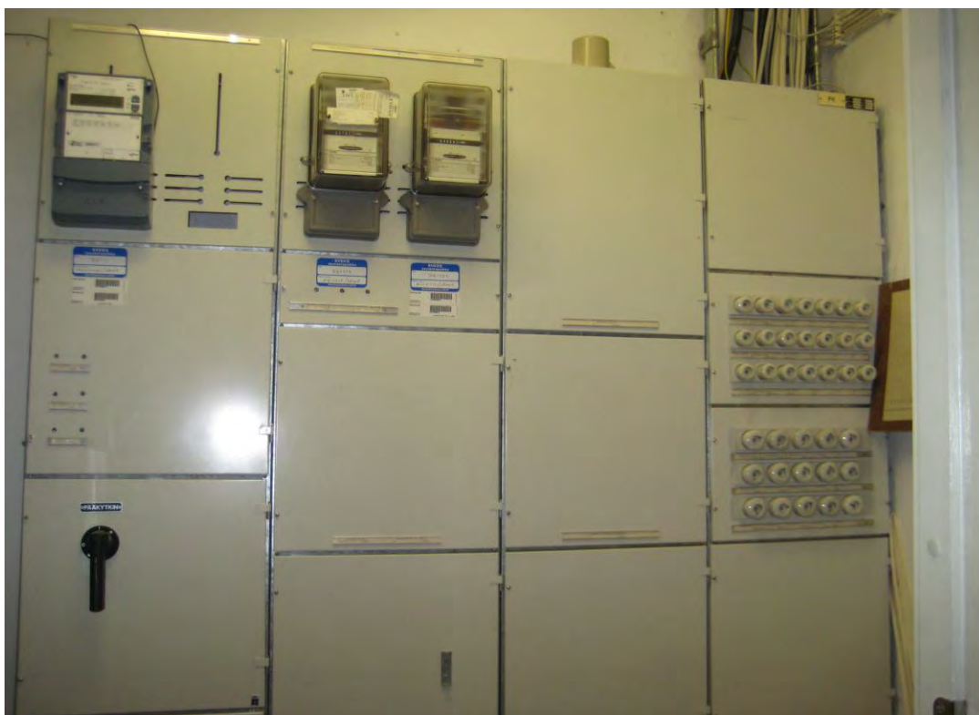
Kuva 2: Kiinteistön pääkeskus.
