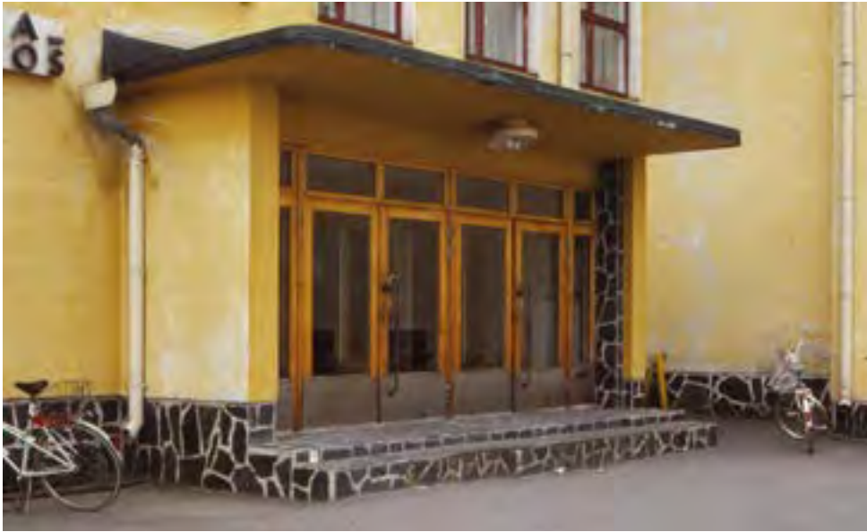
49. Alkuperäinen pääsisäänkäynti katosrakennelmineen. Peruskorjauksen yhteydessä ovet korjattiin, mutta ne päädyttiin uusimaan teräsprofiilirakenteisiksi vuonna 1996.
