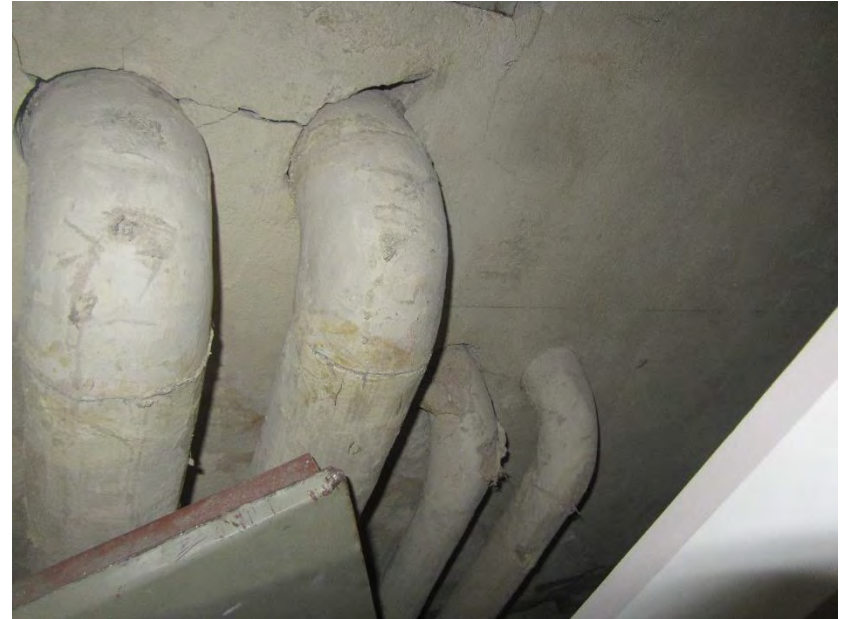
Kuva 2. Kuva kanaalin 3 luukulta.
