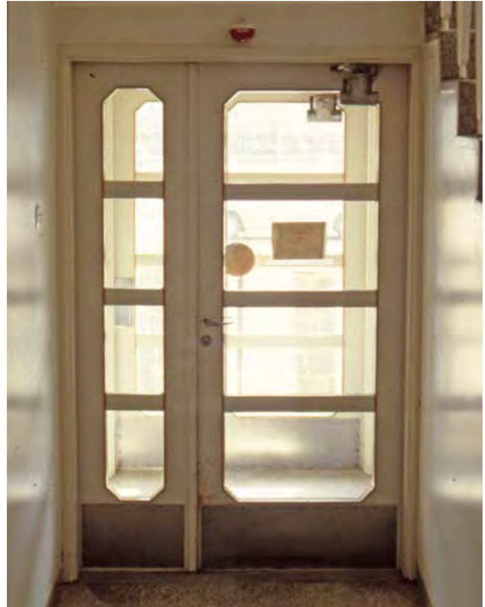
51. Ulko-ovet ja tuulikaappiovet uusittiin peruskorjauksen yhteydessä. Kuvassa alkuperäinen keittiön ja talonmiehen asuntoon johtava sisäänkäynti. Ikkuna-aukoituksen viistetyt kulmat toistuvat rakennuksen sisäovissa.
