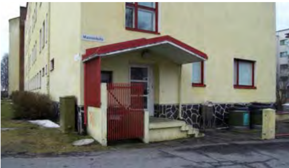
64. Alkuperäinen sisäänkäynti keittiötiloihin ja talonmiehen asuntoon palvelee edelleen samassa tarkoituksessa. Katos, portaat ja kaidarakennelma ovat kaikki uusia rakenteita peruskorjauksen ajoilta.
