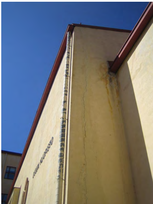
Kuva 19: Julkisivuissa nähtävissä monessa kohdassa vesikourujen vuodoista aiheutuneita vaurioita. Syöksytörvien maalaukset ovat osin huonossa kunnossa.
