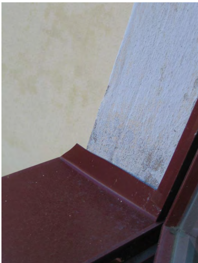
Kuva 15: Ikkunoiden maalipinnoissa on jonkun verran paikallista korjaustarvetta.
