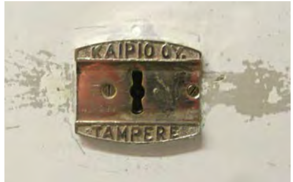
91. Alkuperäisenä säilyneen betoniholvin lukituksesta vastasi tamperelainen Kaipio Oy.
