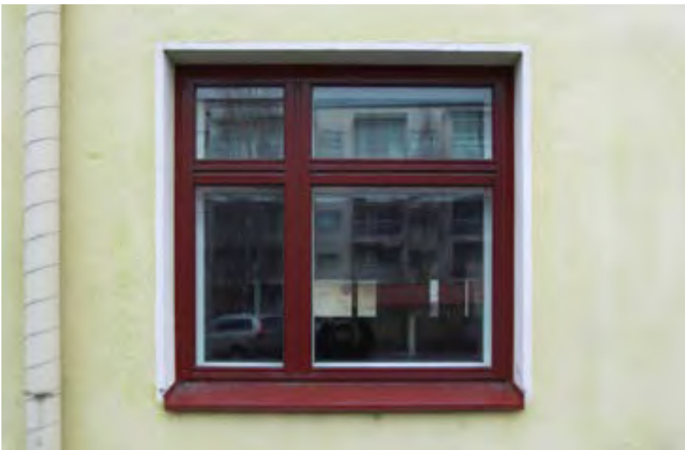
65. Rakennuksen ikkunat on uusittu vuonna 1996. Ikkunoiden uloimmat puitteet ovat alumiinia. Alkuperäinen puitejako säilytettiin. Ikkunat ovat hyväkuntoiset.
