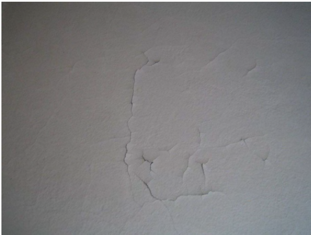
Kuva 21: Liikuntasaliosan kellarin seinissä paikallista maalipinnan hilseilyä.
