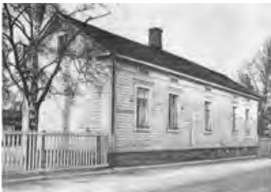
Hervan suunnittelema koulu Oulun kauppa-koululla oli Yrjö Hervasin suunnittelema ja rakennuttama. Sen rakensi Al. O. Kallio. Vuosi 1877-80.
