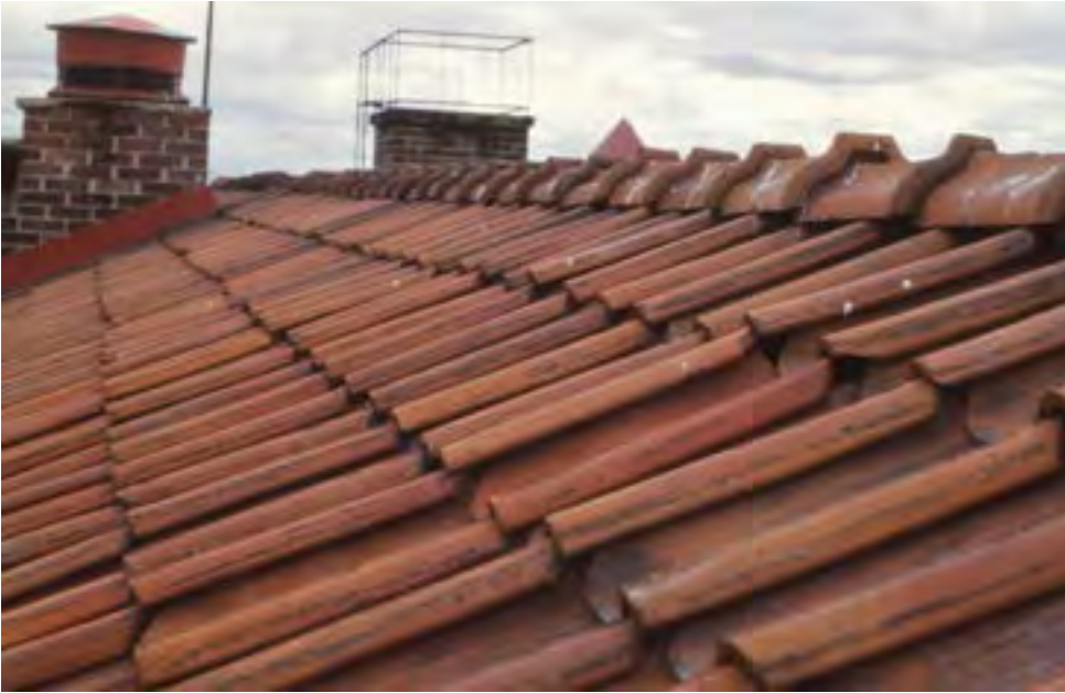
60. Kouluviiven savitiilikateen vaurioituneet tiilet uusittiin ehjiin. Juhlasaliiviin vuosina 1976-77 uusittu Minerit -vesikatemateriaali säilytettiin myös.
