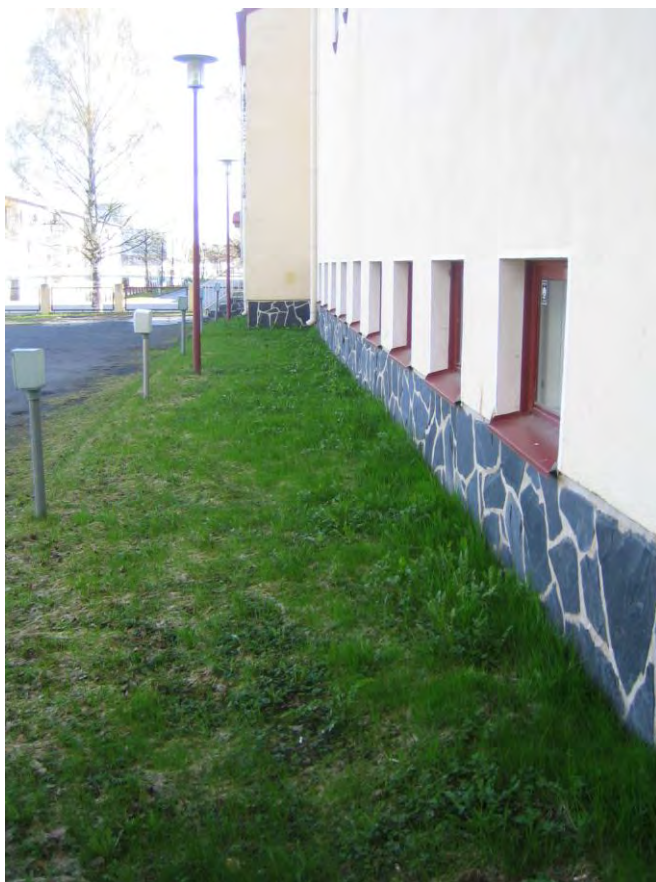
Kuva 1: Nurmetus on sokkelissa kiinni ja maanpinnan kallistukset sokkelinvieressä ovat hyvin loivat.
