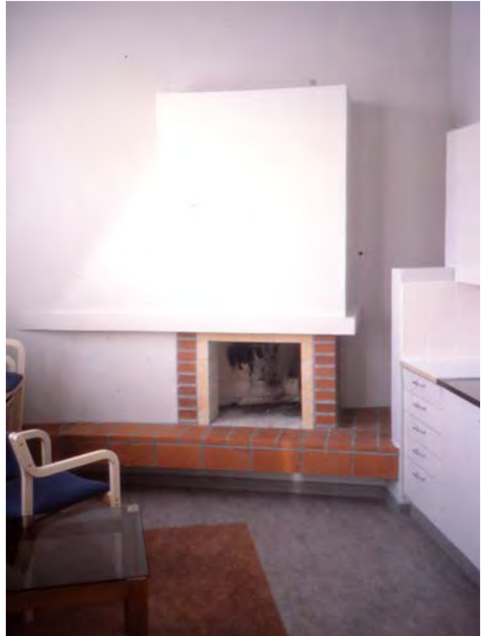
62. Peruskorjauksen yhteydessä toteutettiin ensimmäisessä kerroksessa sijaitsevaan taukotilaan avotakka.
