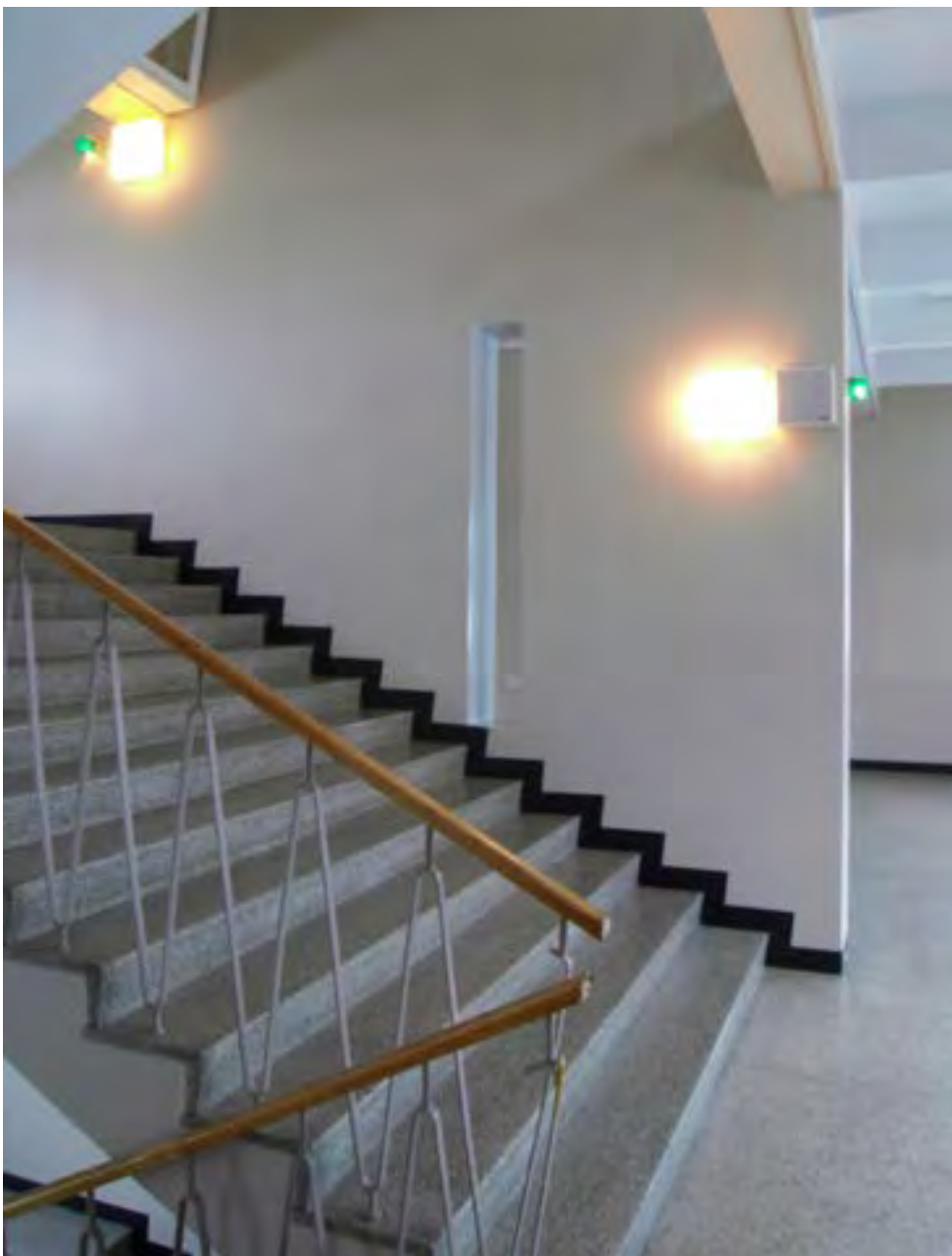
72. Sisäportaiden kaiderakenne on alkuperäinen, mutta puista käsijohdetta korotettiin määräysten mukaiseksi. Seinään tehty valoaukko on toteutettu 1986-87.
