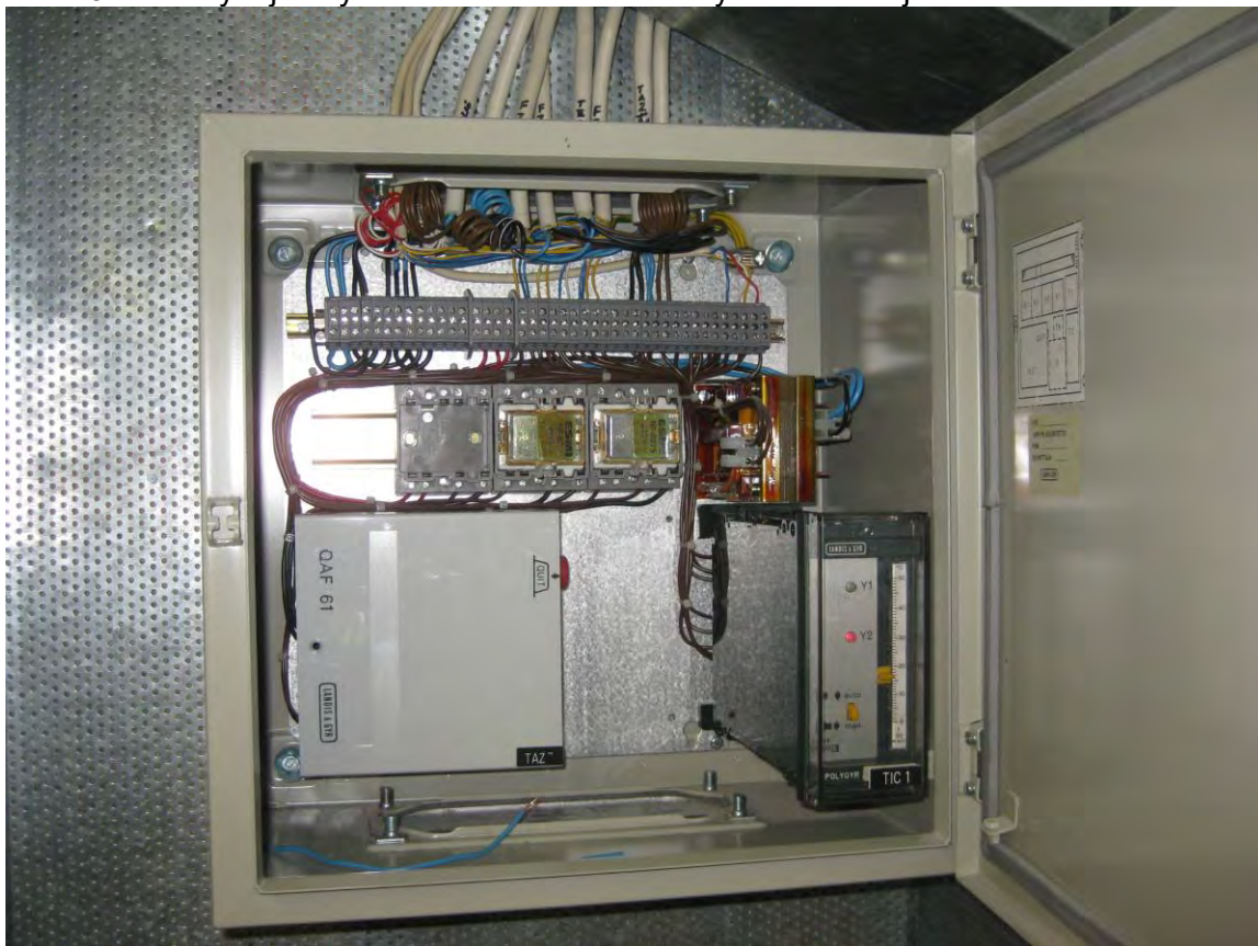
Kuva 4: IV-laitteiston säätökeskus.
