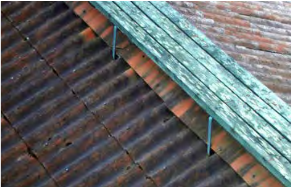
43. Juhlasaliiven Minerit -vesikate ja puurakenteinen kattosilta.
