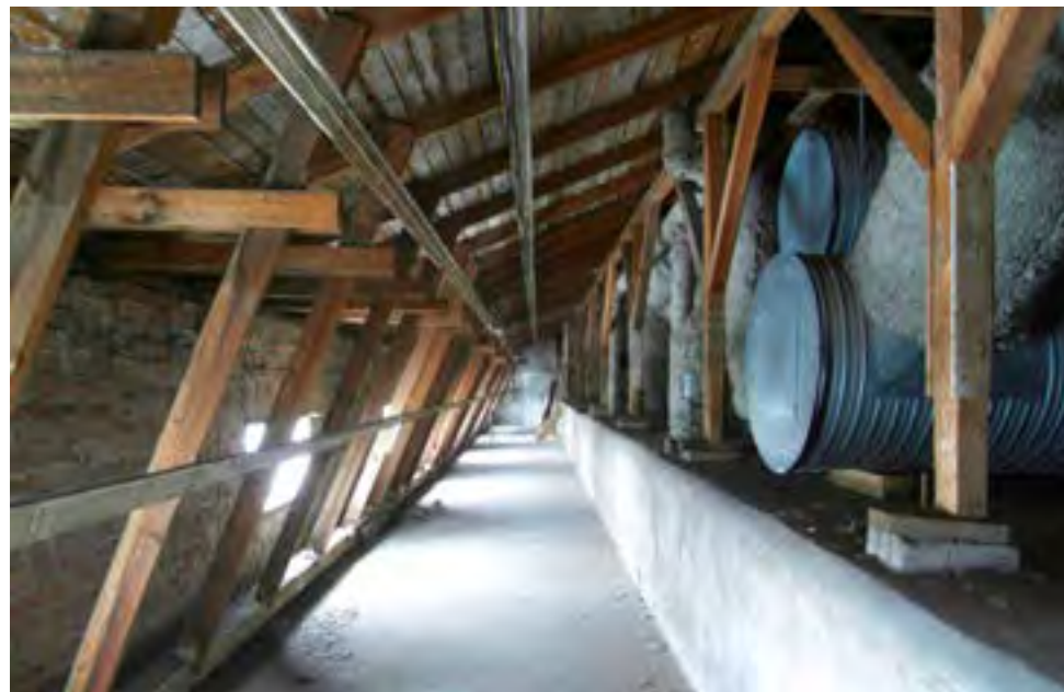
74. Koulusiiven ullakko on siistissä kunnossa. Vesikaton puurakenteet ovat kuivat ja hyväkuntoiset.
