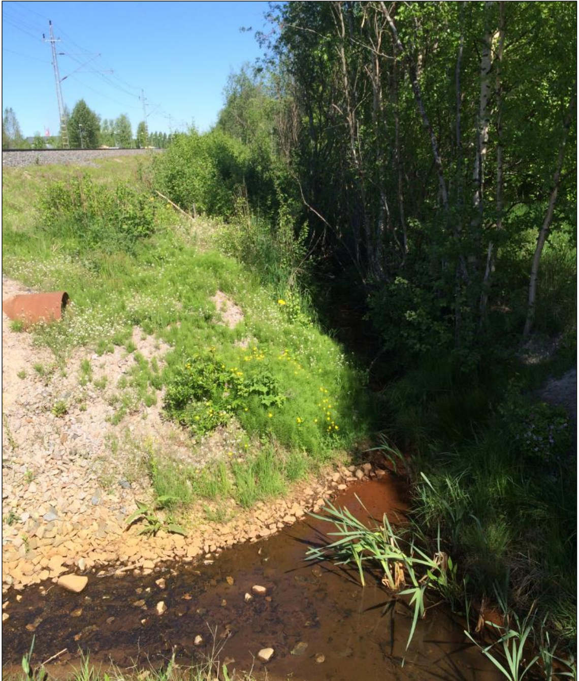
Kuva 13 Näkymä pohjoisen suuntaan radan itäpuolella km:n 747+038 rummun luota.
