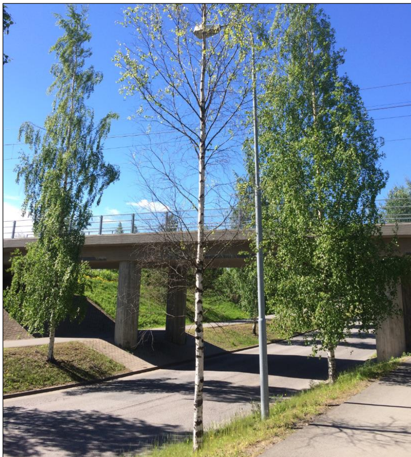
Kuva 5 Perkkiöntie siltapaikka radan itäpuolelta kuvattuna.
