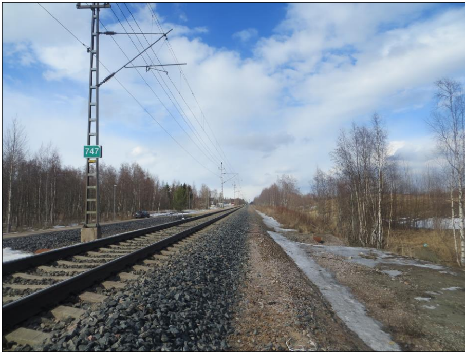
Kuva 2 Maankäyttö Perkkiöntien pohjoispuolella. Uusi raide sijoittuu nykyisen raiteen oikealle puolelle. Puiden takana näkyy radan ja Toukolankaaren välinen meluvalli.
