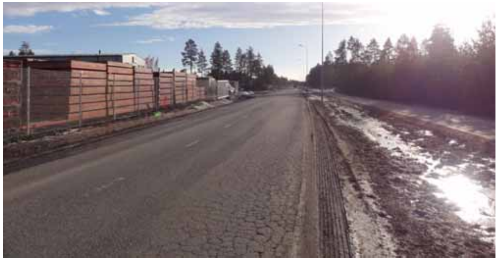
Kuva 14: Näkymä Virpiväylältä. Kadun kunto on syytä tarkistaa.
