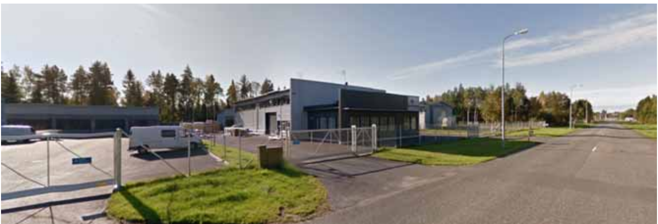
Kuva 45: Kuvassa on Laakeritiellä Ruskon teollisuusalueella olemassa olevaa uutta yritysrakentamista. Kuva on ote Google Maps –palvelusta.
