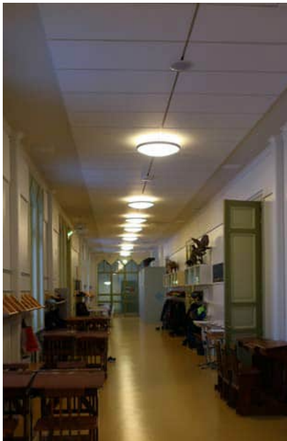
126. Valaisimet ja akustiikkalevyt jäsentävät käytävän alakattoa. Ilmanvaihtotekniikka on upotettu alakattoon sekä sivuseiniin.
