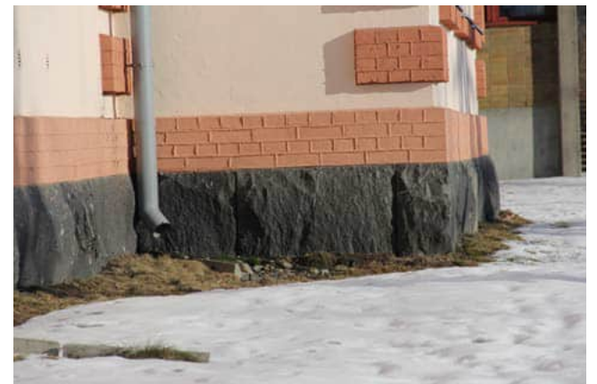
98. Kivijalan ja rapatun julkisivun välissä on muurattu tiilivyöhyke.
