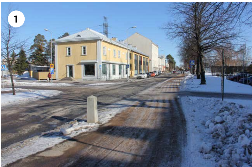
7. Näkymä Merikoskenkadulta koulun suuntaan. Koskitien vasemmalla puolella on ensin Osuuskaupan talo (1925) ja sen takana Säästöpankin talo (1938). Niiden välissä on 2000-luvun täydennysrakentamista.
