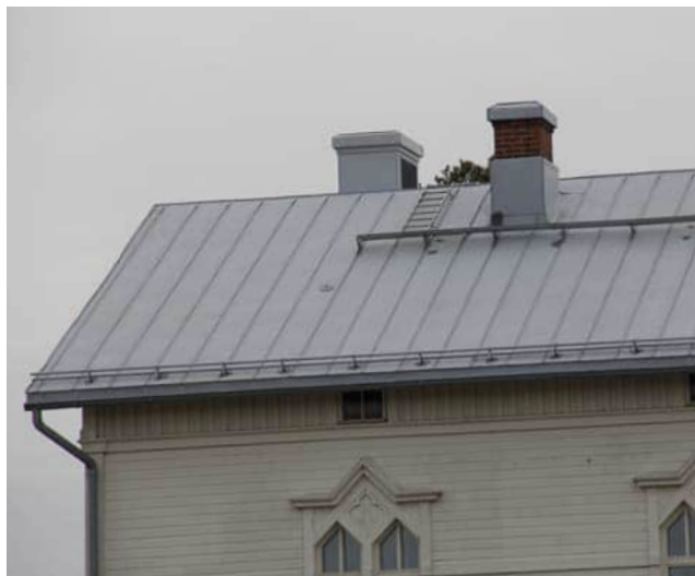
102. Alkuperäisten savupiippujen joukkoon on lisätty vasemmalla näkyvä ilmanvaihtokoneen poistohormi. Se on muotoiltu savupiipun muotoiseksi.
