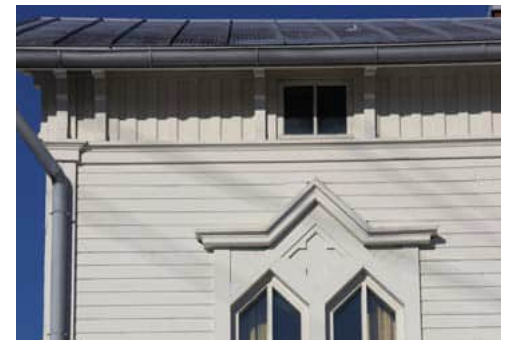
147. Toisen kerroksen ikkuna sekä sen yläpuolella ullakon haukkaikkuna.
