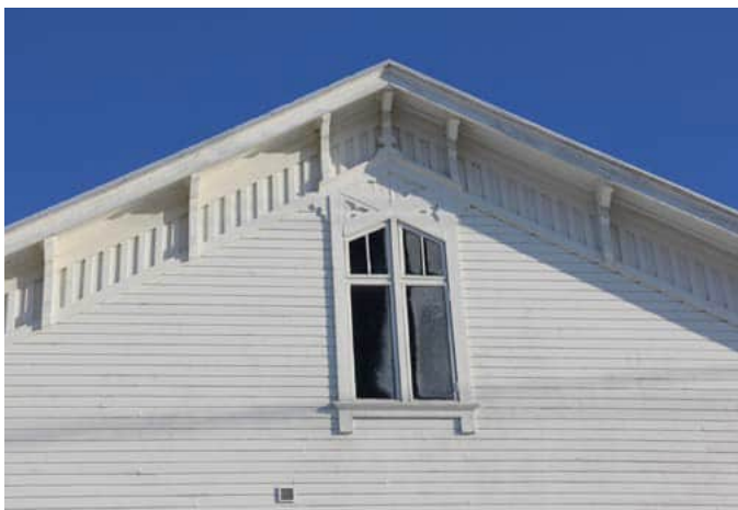
91. Päätyjulkisivun vaakalaudoitus päättyy koristeelliseen räystäslinjaan.
