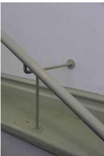
186. Pelkistetty metalliputkikaide.
