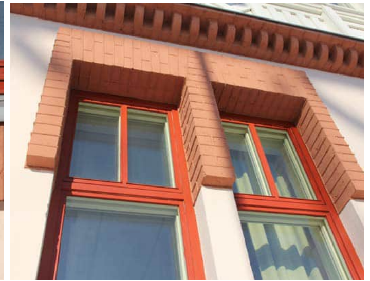
114. Keskirisaliitissa ikkuna-aukkoa on korostettu muuratulla kehyksellä.
