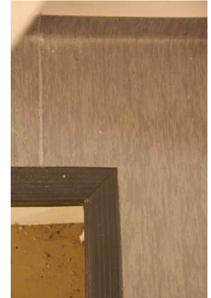
132. Ullakkohuoneen vinyylimatto on harmaa.
