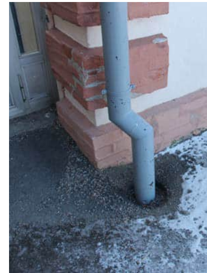
100. Pihan puolella sadevesi kerätään suoraan huulevesijärjestelmään.
