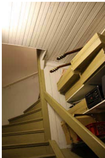
188. Ullakon porrashuone on verhoiltu helmiponttipaneelilla.
