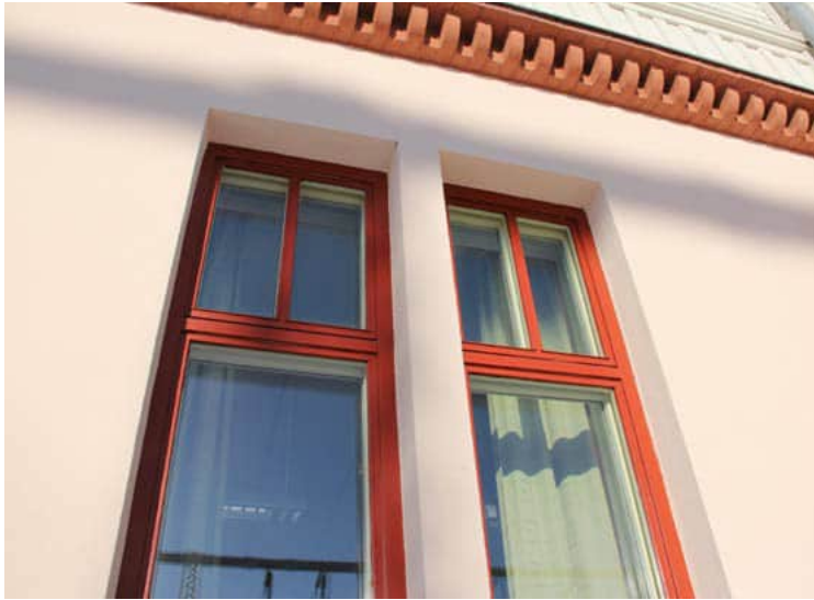
113. Ensimmäisen kerroksen koristeeton ikkuna-aukko.
