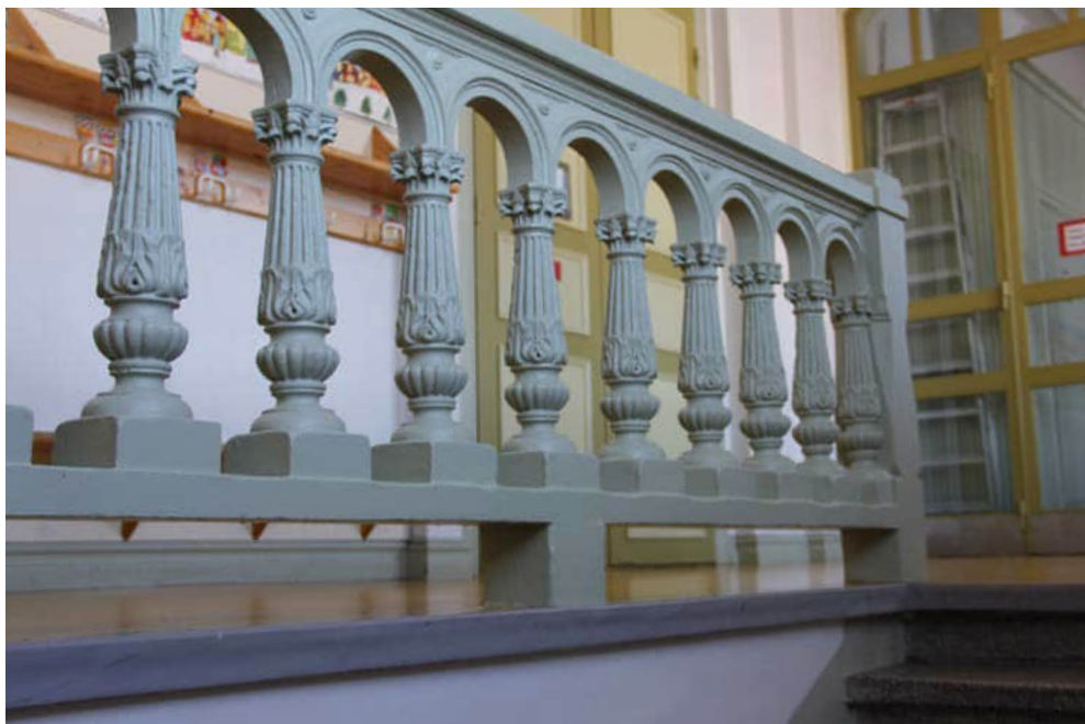
183. Toisen kerroksen kaide on tyyliltään uusrenessanssia.
