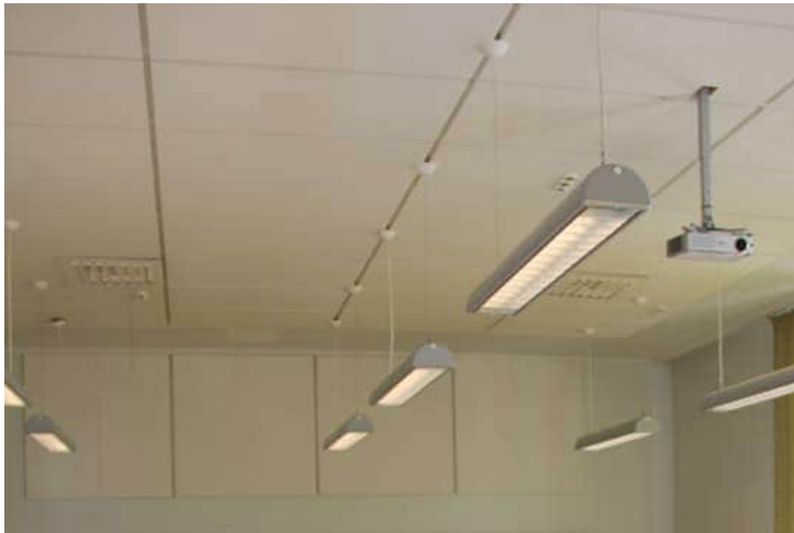
123. Luokkahuoneiden alakattoihin on kiinnitetty vaaleat akustiikkalevyt. Ripustukset on tehty pääosin levyjen saumoihin.
