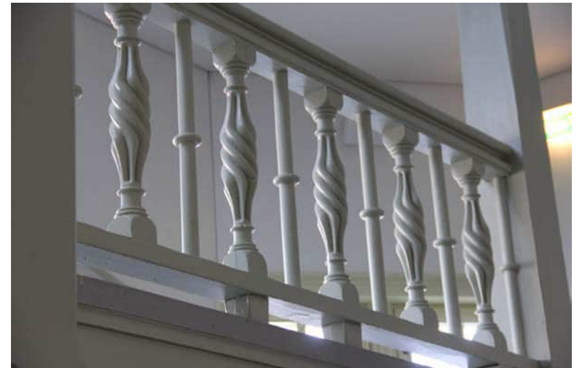
172. Pääportaan kierteinen kaidepuu on uusgotiikalle tunnusomainen koristemuoto.
