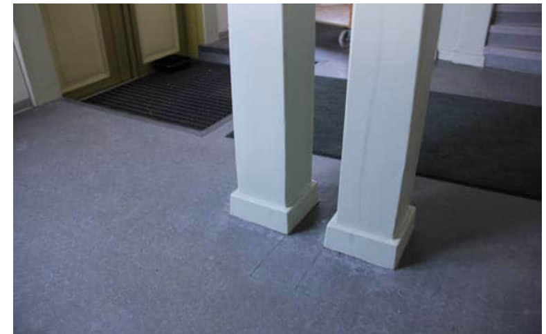
133. Porrashuoneen lattia on pinnoitettu kulutusta kestäväällä kolikkomatolla.
