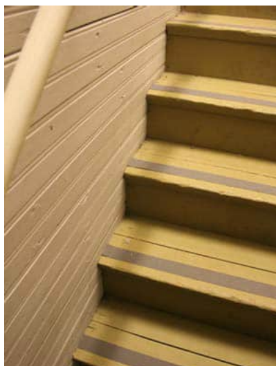
187. Ullakon portaat on tehty puusta.
