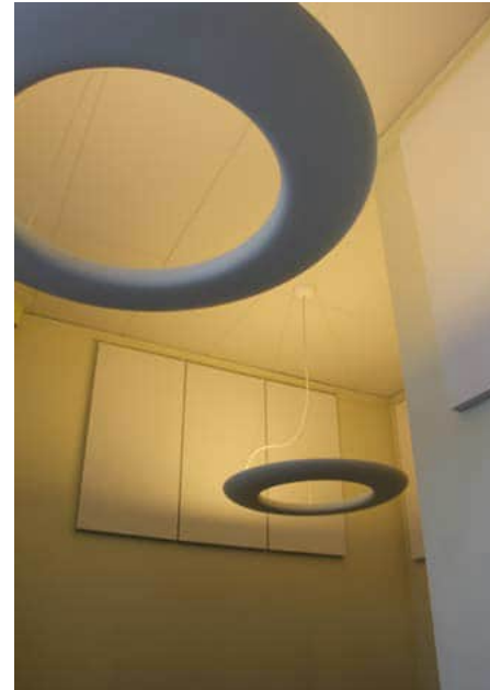
150. Soittuhuoneen epäsuoraa valoa antavat kattovalaisimet
