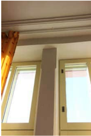
143. Ikkunat on ryhmitelty pareittain, siten, että kahden karmen välissä on pilari. Kuvassa ensimmäisen kerroksen luokkahuoneen ikkuna.
