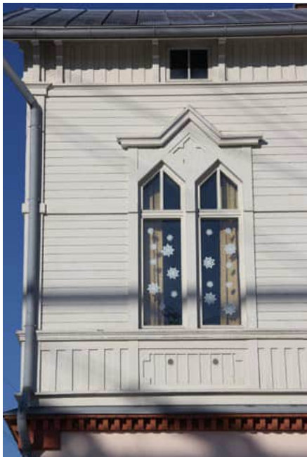
118. Toisen kerroksen jyrkkäkulmaisella frontonilla ja ruusukkeella koristeltu ikkuna.
