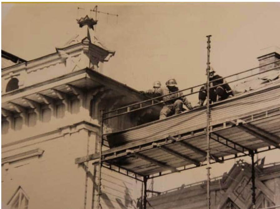
60. Koulun katon korjaustyömalla syntyi tulipalo. KUVA: Tuiran koulun arkisto
