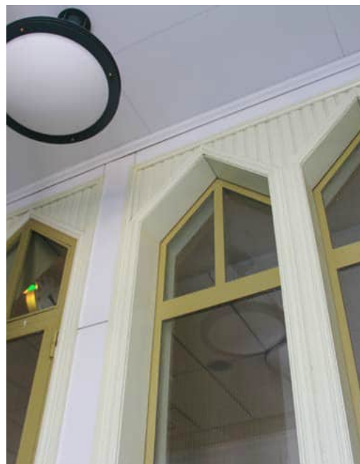
174. Porrashuoneen väliovi ja sisäikkunat toimivat palokatkona käytävän suuntaan. Osastointi on tehty vuonna 1977.
