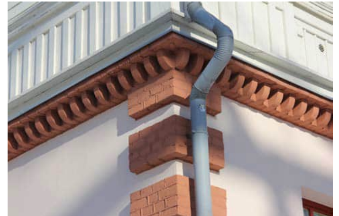
97. Ulkonurkan rustikapilasteri päättyy muototiilestä muurattuun kerroslistaan.
