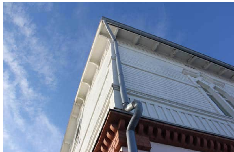
103. Avoräystäitä kannattaa kattotuolien vasat sekä puiset konsolit.
