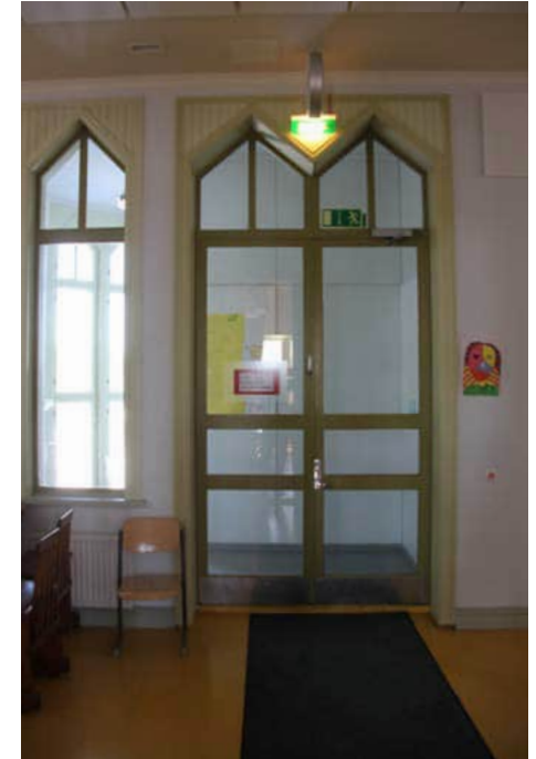
193. Pääportaaseen johtavat osastoivat ovet rakennuksen toisessa kerroksessa.
