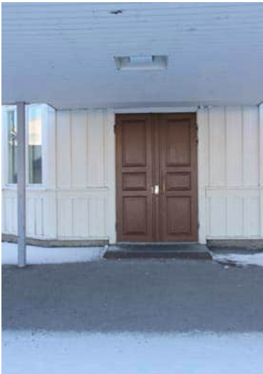
109. Pääovi on sadekatoksen puristuksessa.
