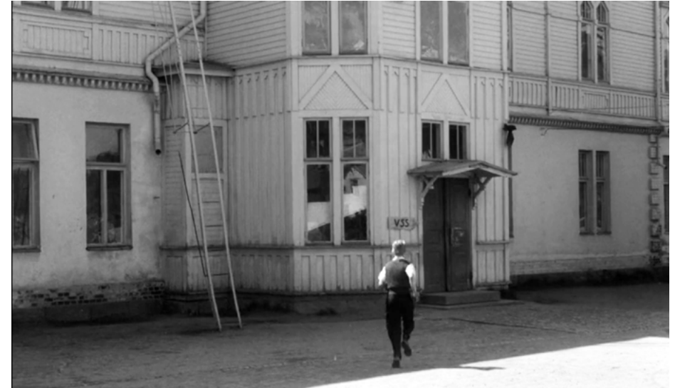
49. Tuiran kansakoulu toimi toisen maailmansodan aikana saksalaisten majoituspaikkana. Tätä ajanjaksoa kuvattiin autenttisisä ympäristössä elokuvassa Pojat, joka sai ensi-illan vuonna 1962. Kuvassa näkyy alkuperäinen sisäänkäyntikatos sekä pieni komero porrashuoneen vasemmalla puolella. KUVA: Kuvakaappaus elokuvasta "Pojat", Ohjaaja Mikko Niskanen, Suomen Filmiteollisuus 1962. Lähde: Elonet.fi, Kansallinen audiovisuaalinen instituutti KAVI.
