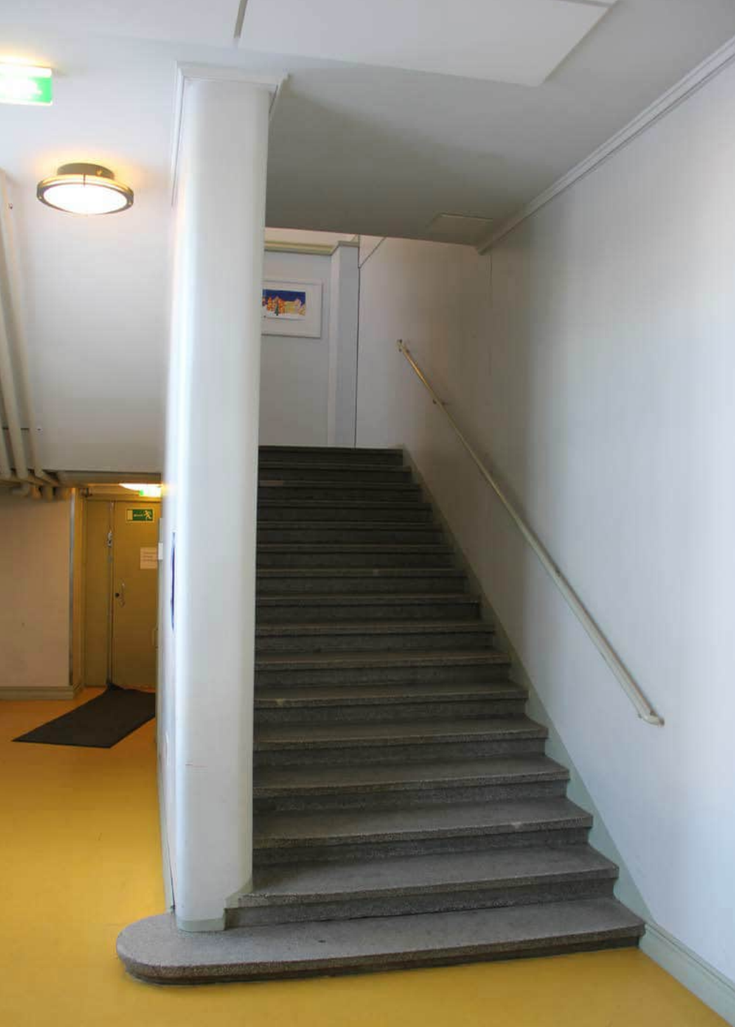
181. VASEMMALLA on ensimmäisen kerroksen porrashuone. Mosaikkibetonista valetut askelmat ovat alkuperäiset. Portaalla on sähköpääkeskus.
