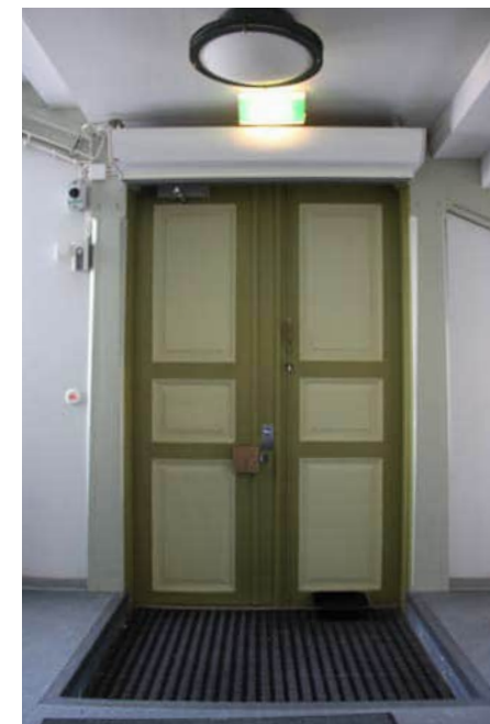
175. Pääovi on alkuperäisen muotoinen. Vedin on vaihdettu 1970-luvun malliin.
