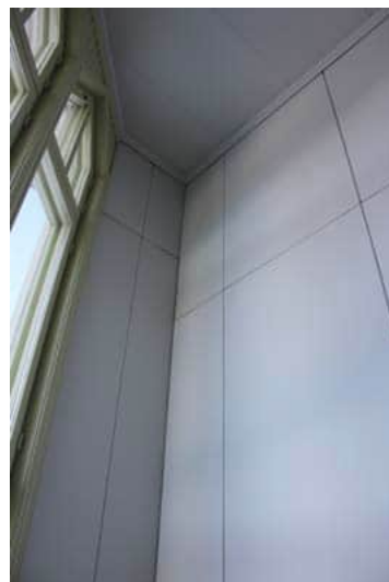
178. Seinät on eristetty ja levytetty.
