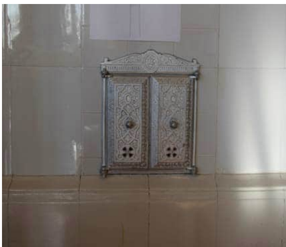
155. Alkuperäisestä lämmitysjärjestelmästä on jäljellä kaksi kakluunaa.
