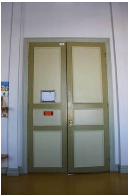
134. Luokkahuoneen ennallistettu peiliovi.
