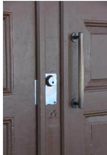
105. Pääovi on mahdollisesti alkuperäinen. Lukko ja vedin ovat myöhempiä lisäyksiä.
