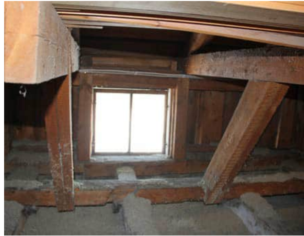
231. Ruotsalaisten kattotuolien välissä on yksinkertainen haukkaikkuna.
