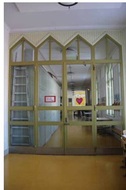
136. Käytävän teräsrunkoiset palo-ovet
