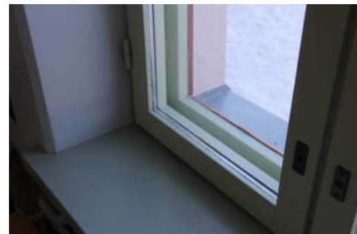
140. Ensimmäisen kerroksen ikkuna sisäpuolelta.
