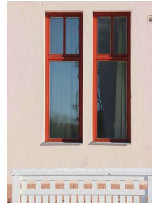
115. Ikkunat on sijoitettu pareittain. Niiden puitejako vaihtelee.
