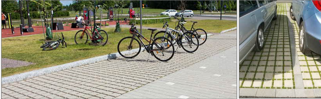
Kuva 10. Vettä läpäiseviä kiveyksiä pysäköintialueilla. (rakentaja.fi)
