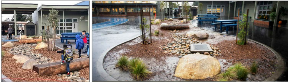
Kuva 15. Toiminnallinen hulevesien hallintarakenne koulun pihalla San Franciscossa (San Francisco Public Utilities Commission)
