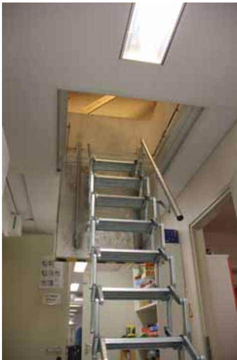
205. Ullakolle nouseaan sisäkautta huoltokäytävällä sijaitsevasta luukusta.
