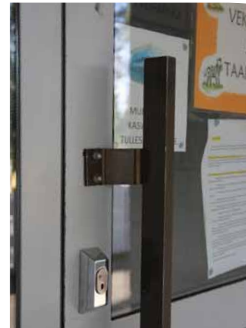
103. Alkuperäinen vedin on alumiinia. Kaikkien ulko-ovien lukitus on uusittu.
