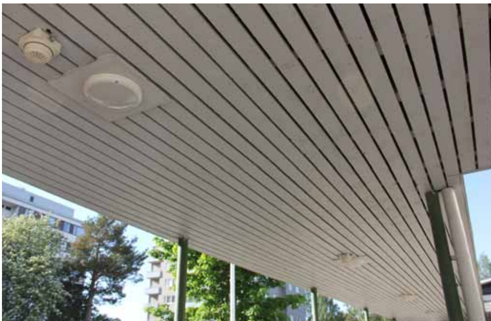
88. Etupihan puolella rakennusta ympäröi hoikkien teräspilareiden kannattamat levymäiset katokset.
