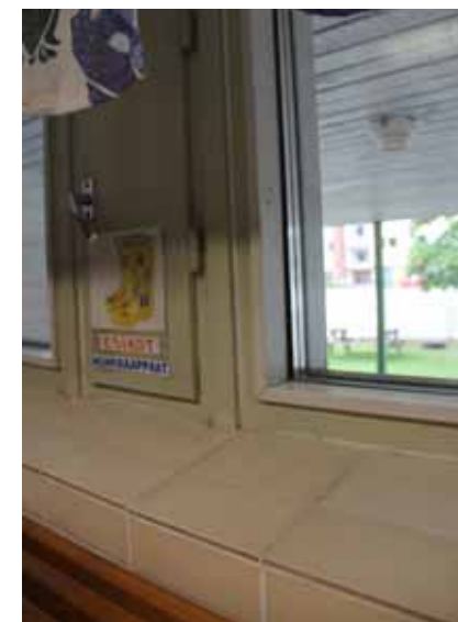
119. Kuraeteisen yläikkunan laatoitettu ikkunapenkki.
