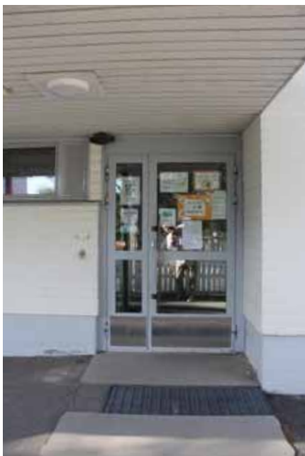
101. Teräsrunkoinen pääovi on vasikallinen. Potkulevy on ruostumatonta terästä.
