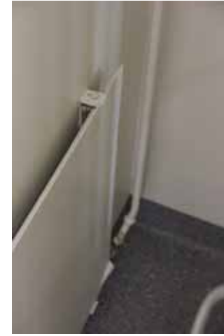
214. Lämpöpatterit ovat alkuperäisiä 1970-luvun levypatereita.
