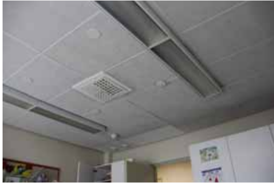
120. Tyypillisin alakattotyyppi on teräsjärjestelmään ripustettu ja akustiikkalevyistä muodostettu rakenne.
