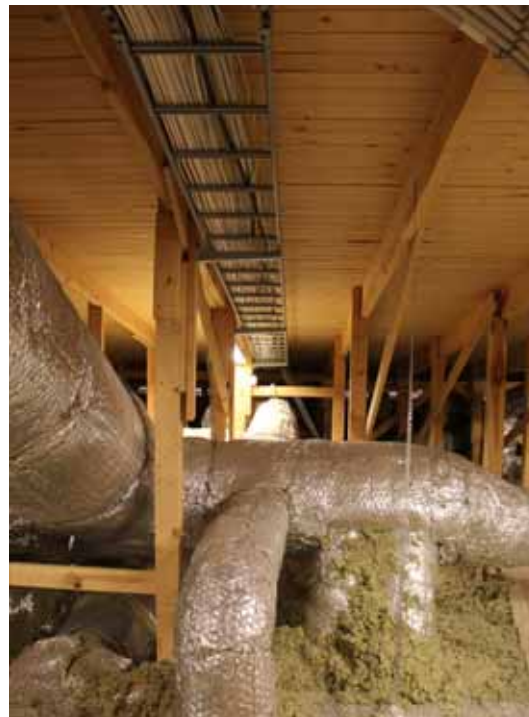
206. Tuulettuva ullakko on matala tila, johon on sijoitettu eristettyjä ilmanvaihtokanavia sekä kaapelihyllyjä.
