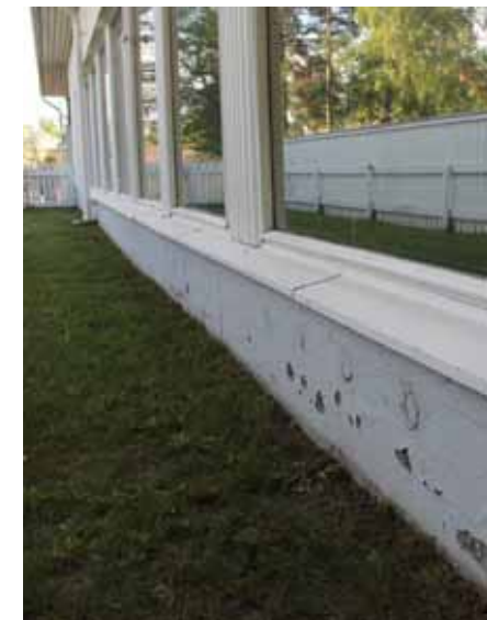
112. Ryhmähuoneiden ikkunalinja nousee piilosokkelin päältä.
