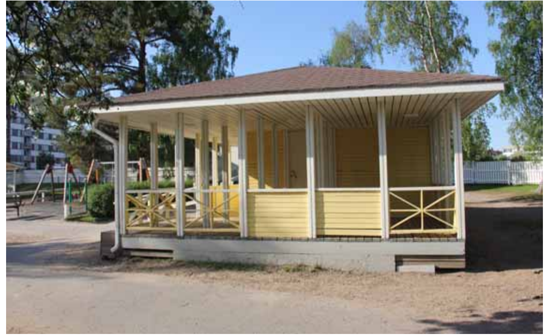
83. Leikkivälinevarasto rakennettiin 1980-luvulla aikakauden arkkitehtuurityyliin mukaisesti. Katoksen "pylväsmetsä" toimii lasten leikkiapaikkana. Varaston paikalla oli aiemmin lasten vesileikkiallas.
