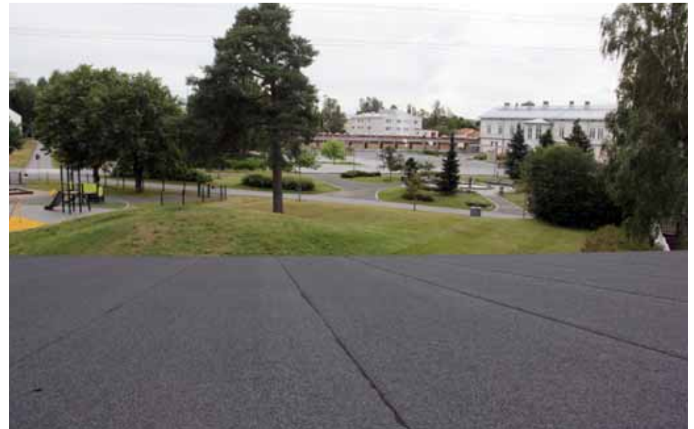
99. Bitumihuovalla päällystetty vesikatto on niin loiva, ettei lumiesteitä tai kulkuteitä tarvinnut rakentaa. Käynti vesikatolle tapahtuu ullakkotilan kautta.
