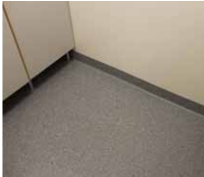
123. Tyypillisin lattiamateriaali on harmaa raekuvioinen vinyylimatto.
