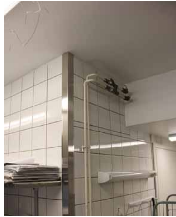
199. Seinät on laatoitettu. Ulkonurkissa on rosterilistat.
