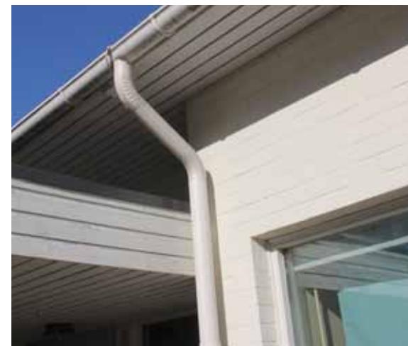
96. Räystään ja sadekatoksen liittymäkohta.
