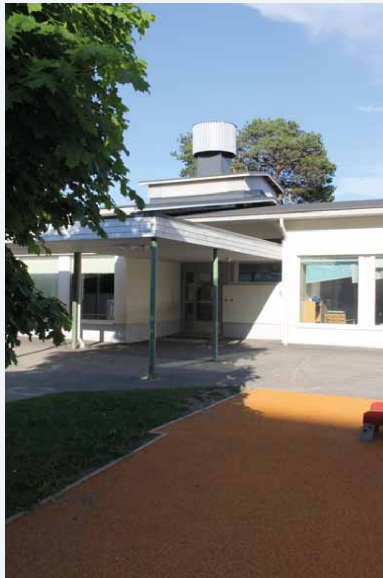
219. Rakennuksen keskelle tehty ilmavaihtokonehuone näyttävine päätelaitteineen muodostaa ehkä tahattoman julkisivuaiheen.
