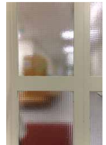
160. Keskuskäytävä on jaettu teräsrunkoisilla palo-ovilla kolmeen osaan.
