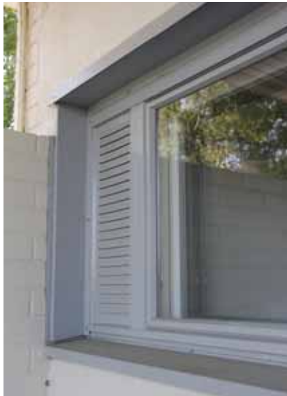
107. Entisen vauvalan vaunuvaraston yläikkuna on uusittu alkuperäisen mallin mukaisesti.
