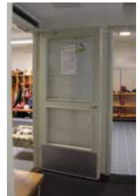
130. Alkuperäinen lasiaukollinen väliovi eteisessä.
