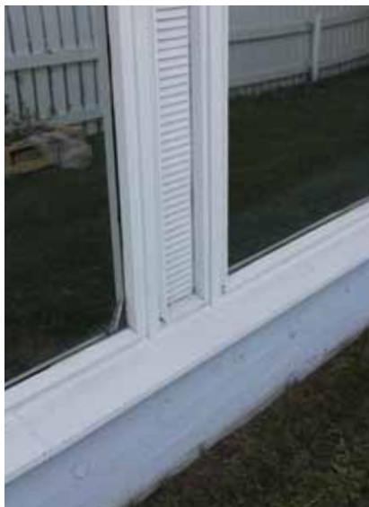
110. Ikkunanauhaa rytmittävät kapeat tuuletusikkunat ja pilareiden kohdalla poimulevyt.
