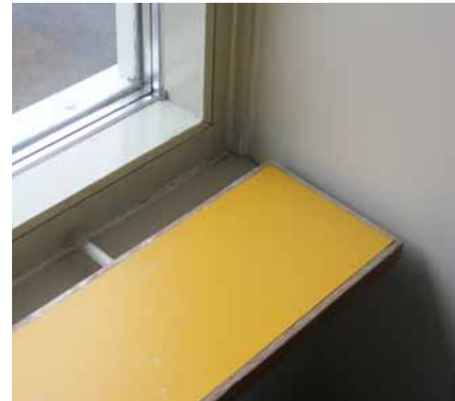
116. Kansliasta löytyy alkuperäinen ikkunalauda. Sen pinta on IKI-levyä ja sivut puulistaa. Lauta on kiinnitetty seinään metallitapeilla.
