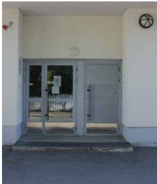
102. Pohjoispäädystä on rinnakkain keittiön kaksiosainen lasiovi ja kellariin johtava umpiovi.
