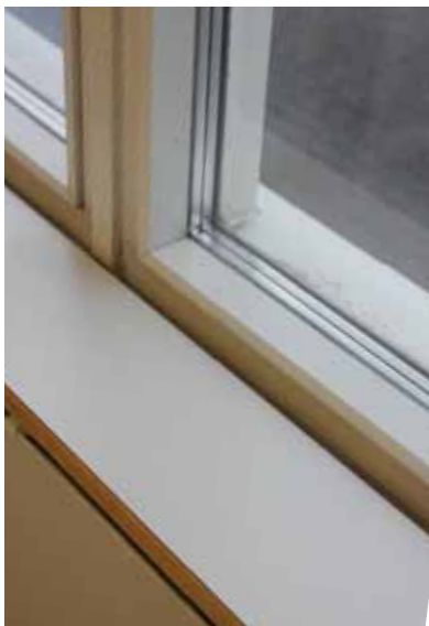
113. Uudet kolmilasiset lämpölasielementit vaihdettiin alkuperäisiin puitteettomiin ikkunakarmeihin.
