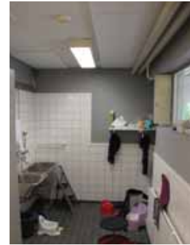
132. Saniteettitilan laatoitusta 2020-luvulta.
