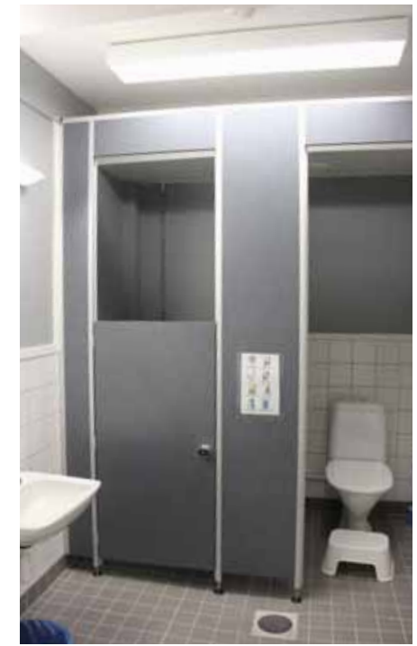
167. Keskuskäytävän varrella olevat WC:t on uusittu vuonna 2017. Ne edustavat uusinta mallia.
