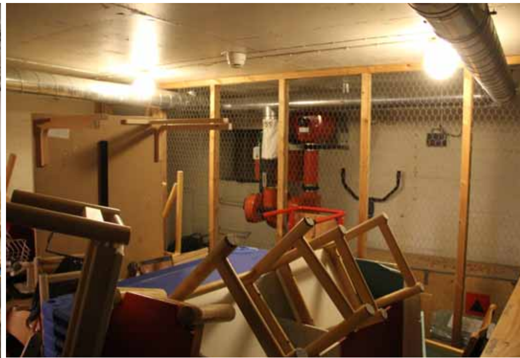
203. Väestönsuojaa käytetään varastona. Sen varustus ja verkkoseinät on uusittu vuonna 2006..
