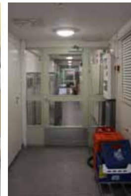
128. Alkuperäinen palo-ovi käytävällä.
