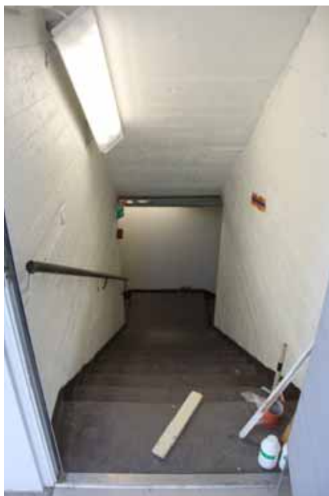
202. Betonirakenteinen porrashuone on alkuperäinen. Vain valaistus ja sähkökalusteet on uusittu.
