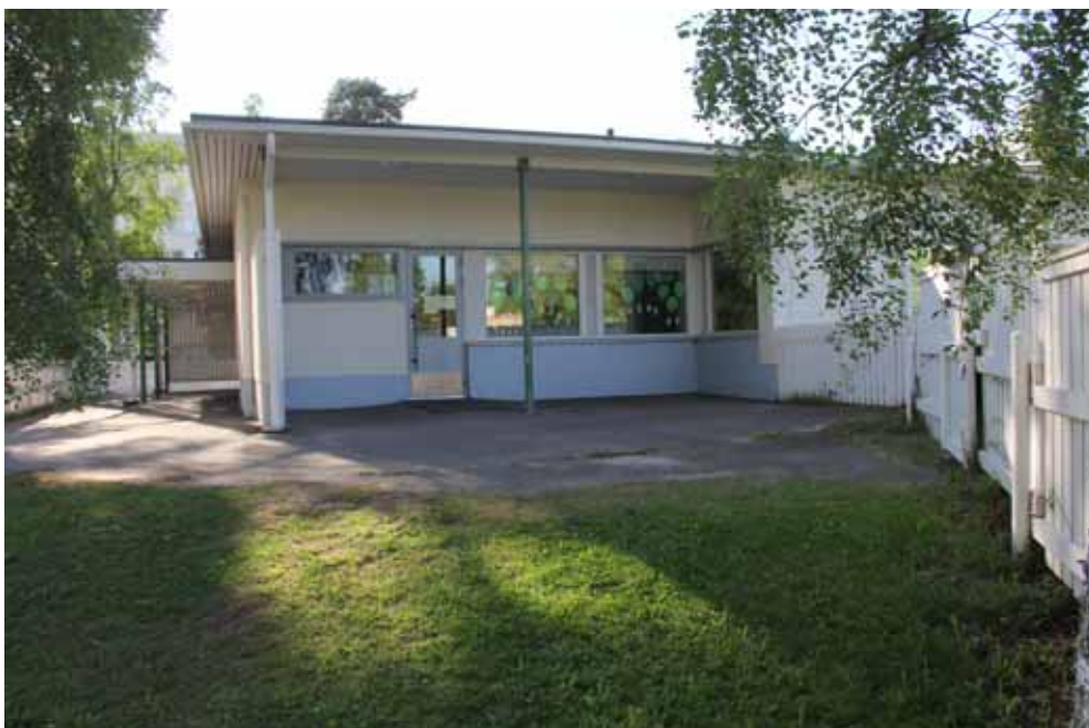
89. Rakennuksen eteläpäässä toimi ennen pienten lasten seimi. 1980-luvulla sen tiloihin muutti CP-vammaisten lasten osasto. Nykyisin tilat ovat 3-5 -vuotiaiden lastenryhmän käytössä.
