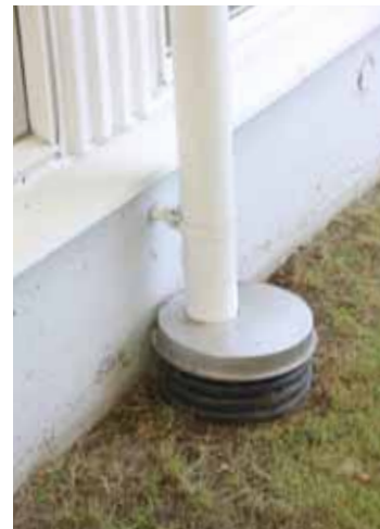
98. Pihan kuivatus ja sadevesijärjestelmä uusittiin 2002. Hulevesiputket kiertävät rakennuksen ympäri sokkelilinjaa seuraten.
