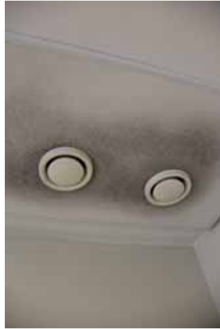
211. Poistoilmaventtiilit alakatossa.
