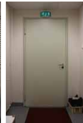
129. Alkuperäinen huullettu laakaovi pukuhuoneessa.
