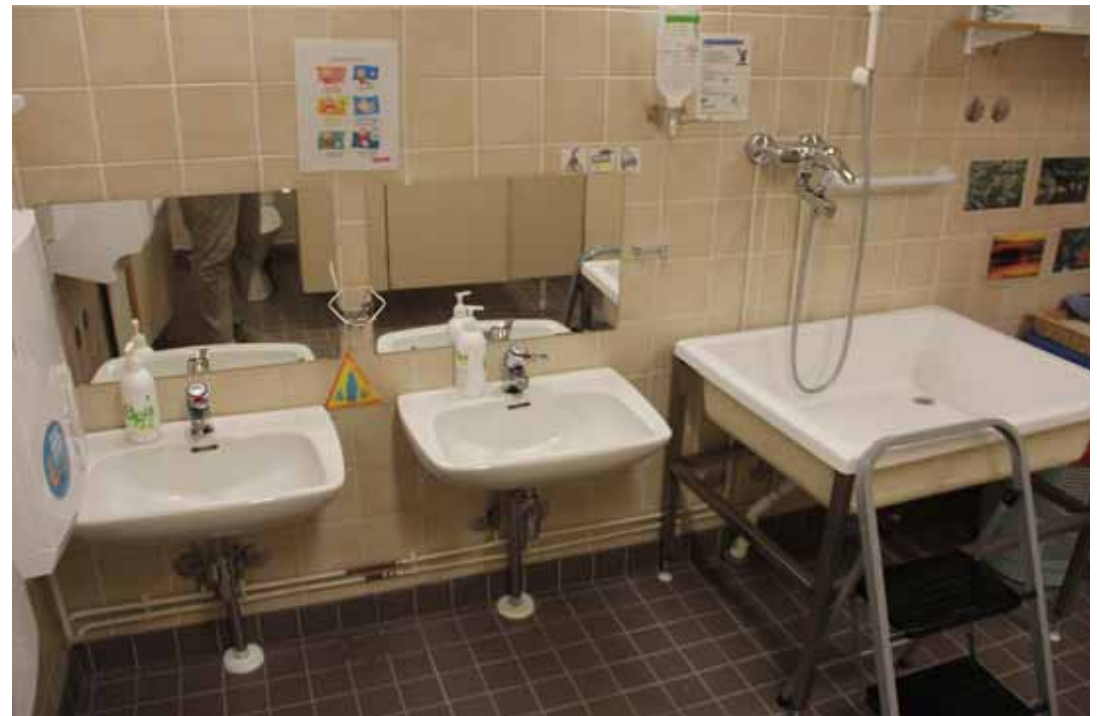
164. Altaat ja peilit on asennettu lapsen tasolle. Oikealla on kylvetysallas.
