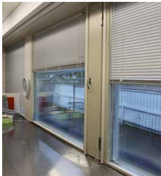
115. Keittiössä ikkunalinjan alareuna on työpöydän tasolla. Ruutujako noudattaa samaa rytmää kuin ryhmähuoneissa.
