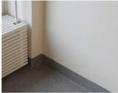
131. Ulkoseinän ja väliseinän liitos. Väliseinän kohdalla on betonipilari.
