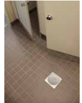
126. Lasten wc-tilan laatoitus on uusittu vuonna 2014.
