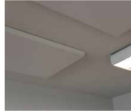
121. Levykatto, jossa akustoivat elementit on asennettu pintaan.
