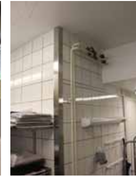
133. Keittiön seinät on laatoitettu. Nurkat on vahvistettu rst-listoilla.
