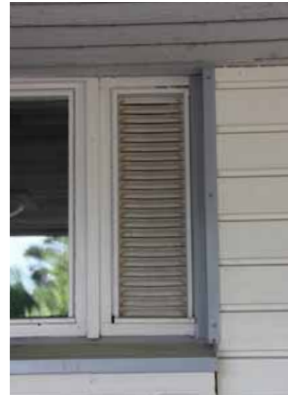
108. Alkuperäinen puurunkoinen ikkuna ja tuuletussäleikkö.
