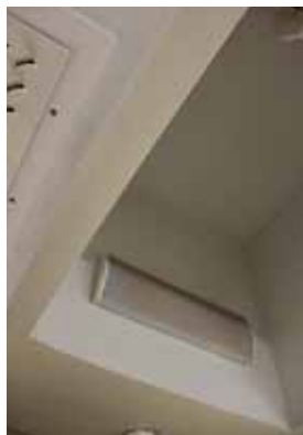
137. Valokuiluun on asennettu valaisimet.
