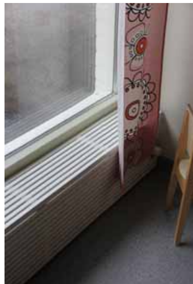
114. Leikkihuoneiden alkuperäiset ikkunalaudat on korvattu rimoitetuilla patterikoteloilla.
