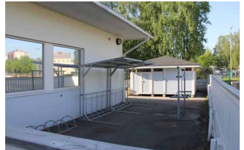
85. Huoltopihan laatikkovarasto purettiin vuonna 2004 ja sen tilalle tehtiin aumakattoinen jätekatos. Etualalla on henkilökunnan polkupyöräkatos.
