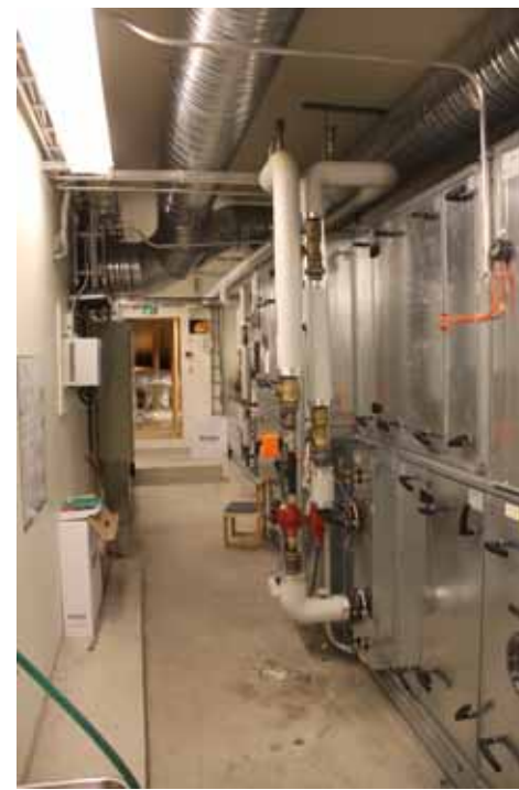
207. Ilmanvaihtokonehuone on lämpöeristetty huone, joka nousee vesikaton harjalinjan yläpuolelle.
