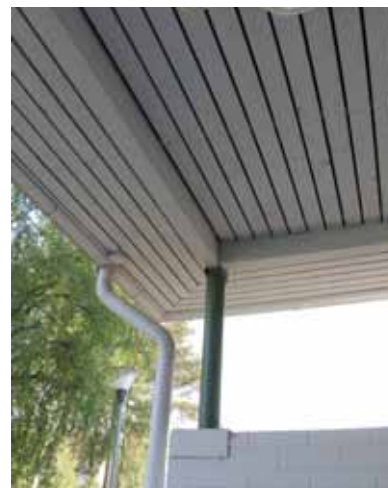
95. Vaunukatokseen lisättiin räystäät ja vesikouru. Muita katoksia ei muutettu.
