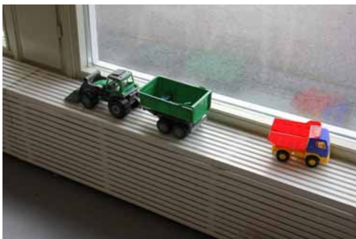
178. Ikkunalaudan tilalle tehtyjä patterikoteloita käytetään yhä leikkitaltoina.
