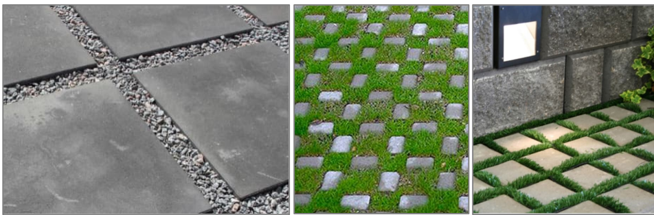
Kuva 8. Erilaisia kiveyksiä vettä pidättävällä saumalla. (Kuvat vasemmalta: Rudus Oy, Maisemabetoni, HB-Betoni)
